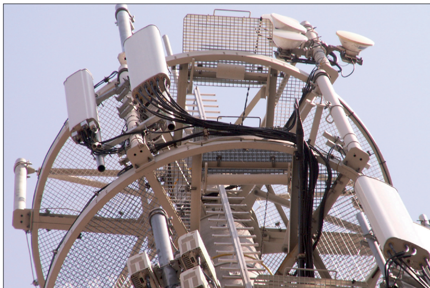
Fot. 8. Przykład anteny 4-systemowej
