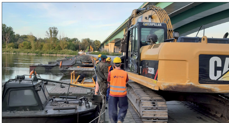
Instalacja rurociągów na moście pontonowym
