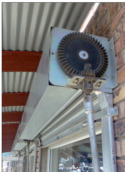
Fot. 5. Koła zębate w napędzie bramy rolowanej (fot. G.D. Harington, Wikipedia)
