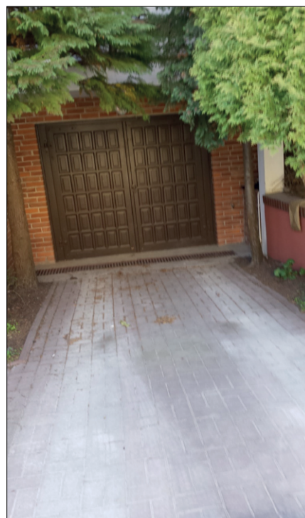
Fot. 10. Wjazd do garażu, różnica poziomów 0,3 m od posadzki garażu do ulicy. Duże korytko odwadniające z piaskownikiem i podłączeniem do kanalizacji tuż przy bramie garażowej
