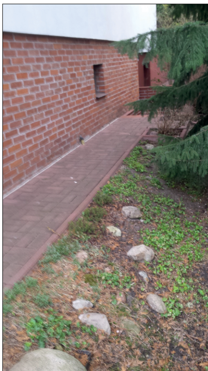
Fot. 9. Opaska wokół budynku oraz obsypanie go do wysokości ok. 0,4 m ziemią z wykopu (do głębokości przemarzania)
