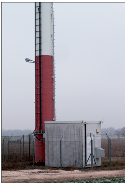
Fot. 6. Przykład lokalizacji urządzeń w kontenerze technologicznym
