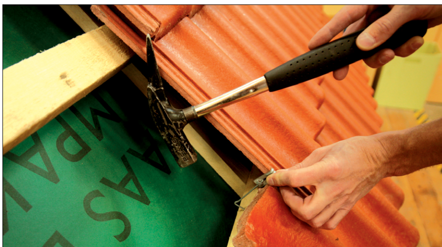
Fot. 2. Zasada mocowania dachówki klamrą boczną
