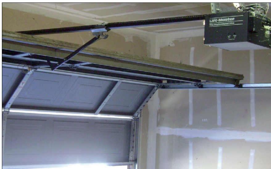
Fot. 4. Elektryczny mechanizm otwierania drzwi garażowych (fot. Wikipedia)
