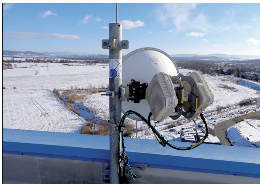
Fot. 11. Przykład anteny MW XPIC
