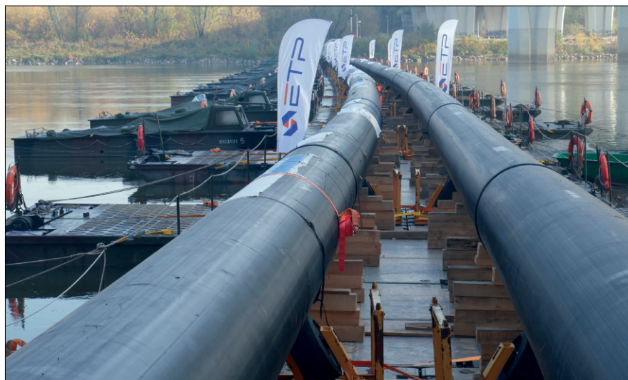
Rurociąg na moście pontonowym
