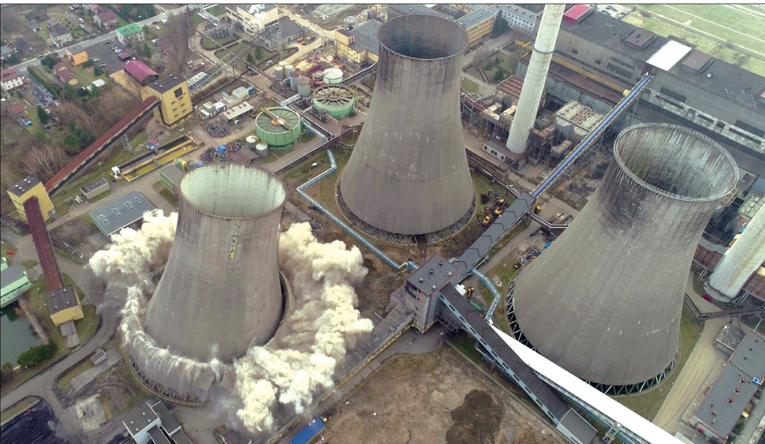
Fot. Wyburzenie chłodni kominowej w elektrowni Łagisza w 2019 r. (archiwum TAURON Wytwarzanie SA)
