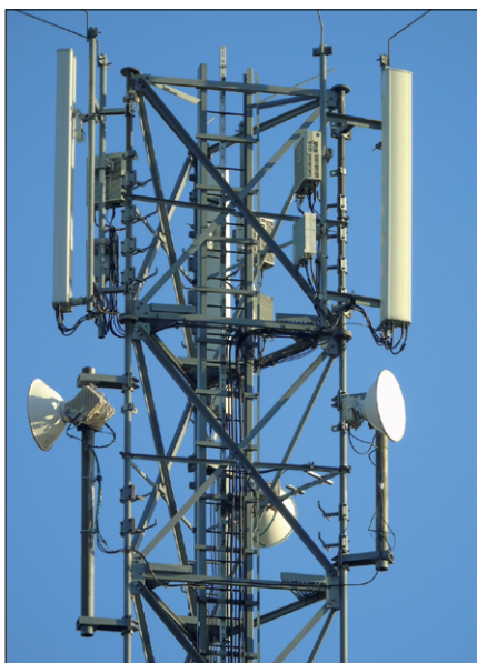
Fot. 7. Każda z anten MW to połączenie z inną stacją bazową
