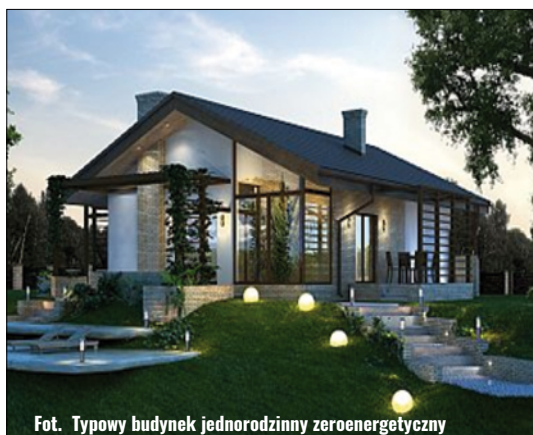
Fot. Typowy budynek jednorodzinny zeroenergetyczny
