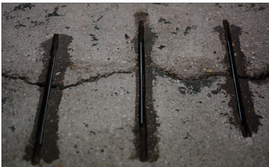
Fot. 1. Naprawa podłóg przemysłowych przez zszycie rys prętami stalowymi
