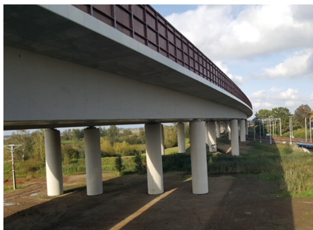
Most MS6 posadowiony na 544 palach FRANKI NG w ciągu Drogi Ekspresowej S5 Poznań–Wrocław, odc. Korzeńsko–Widawa
