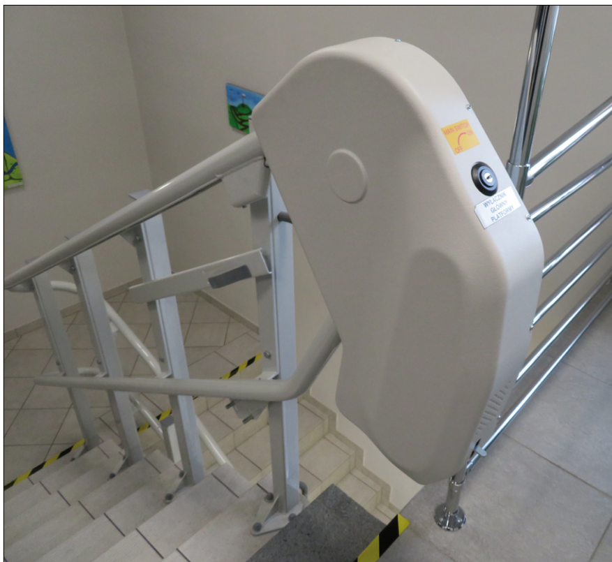
Fot. 3. Platforma schodowa
