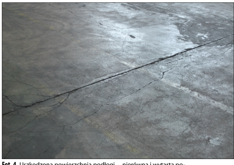
Fot. 4. Uszkodzona powierzchnia podłogi – nierówna i wytarta powierzchnia posadzki/zasypki
