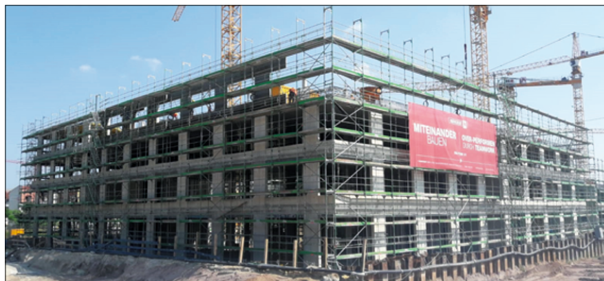
Fot. 5. Rusztowanie wyprzedzające z klatkami schodowymi
