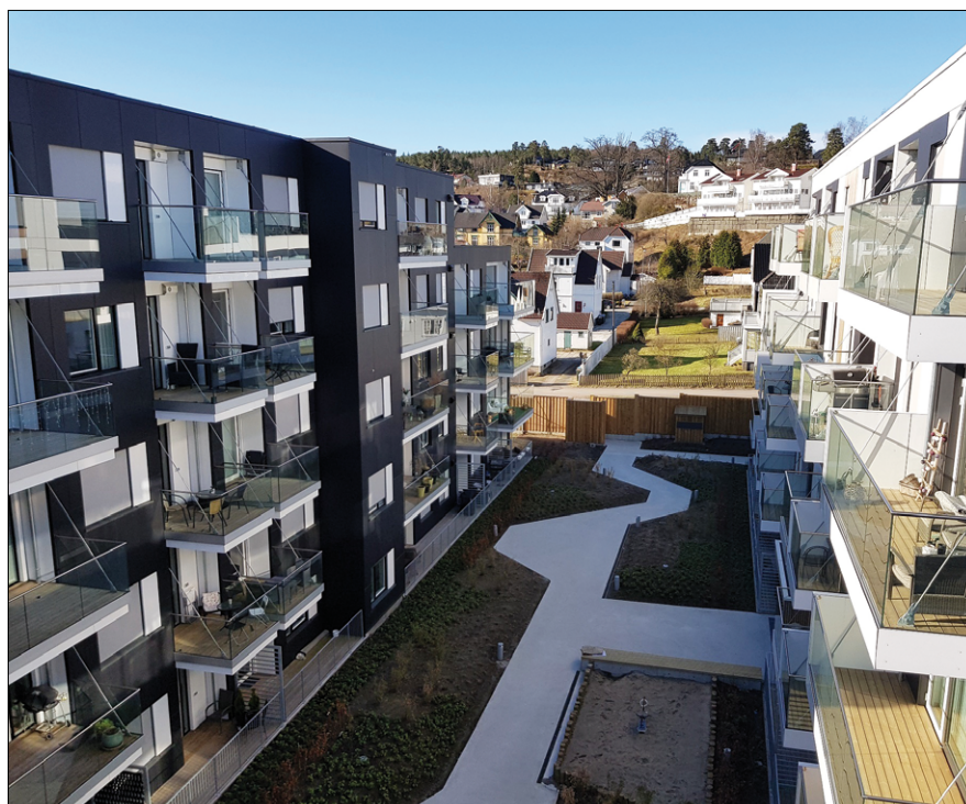
Fot. 2. Przykłady elementów budownictwa modułowego
