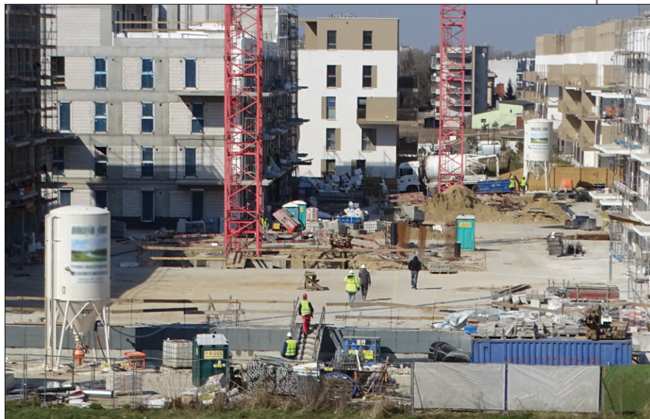
Budowa domów mieszkalnych przy ul. Łazurowej w Warszawie, kwiecień 2020 r. (fot. K. Wiśniewska)
