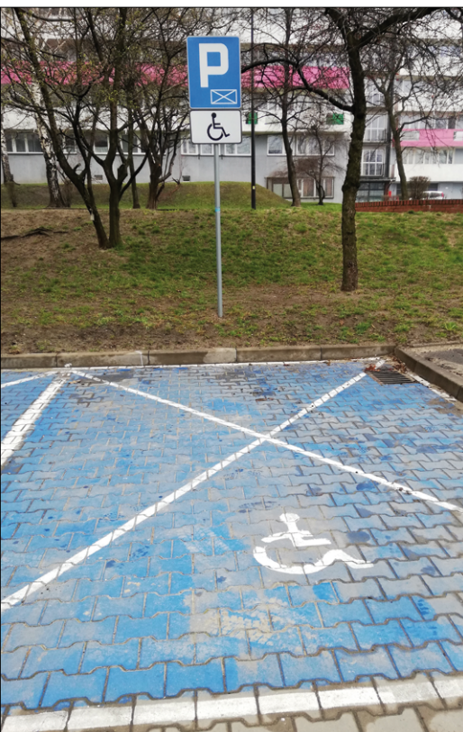
Fot. 2. Oznakowanie miejsca postojowego dla osób niepełnosprawnych
