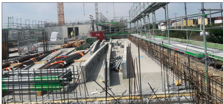
Fot. 3. Rusztowanie wyprzedzające z zabezpieczeniem krawędzi stropu
