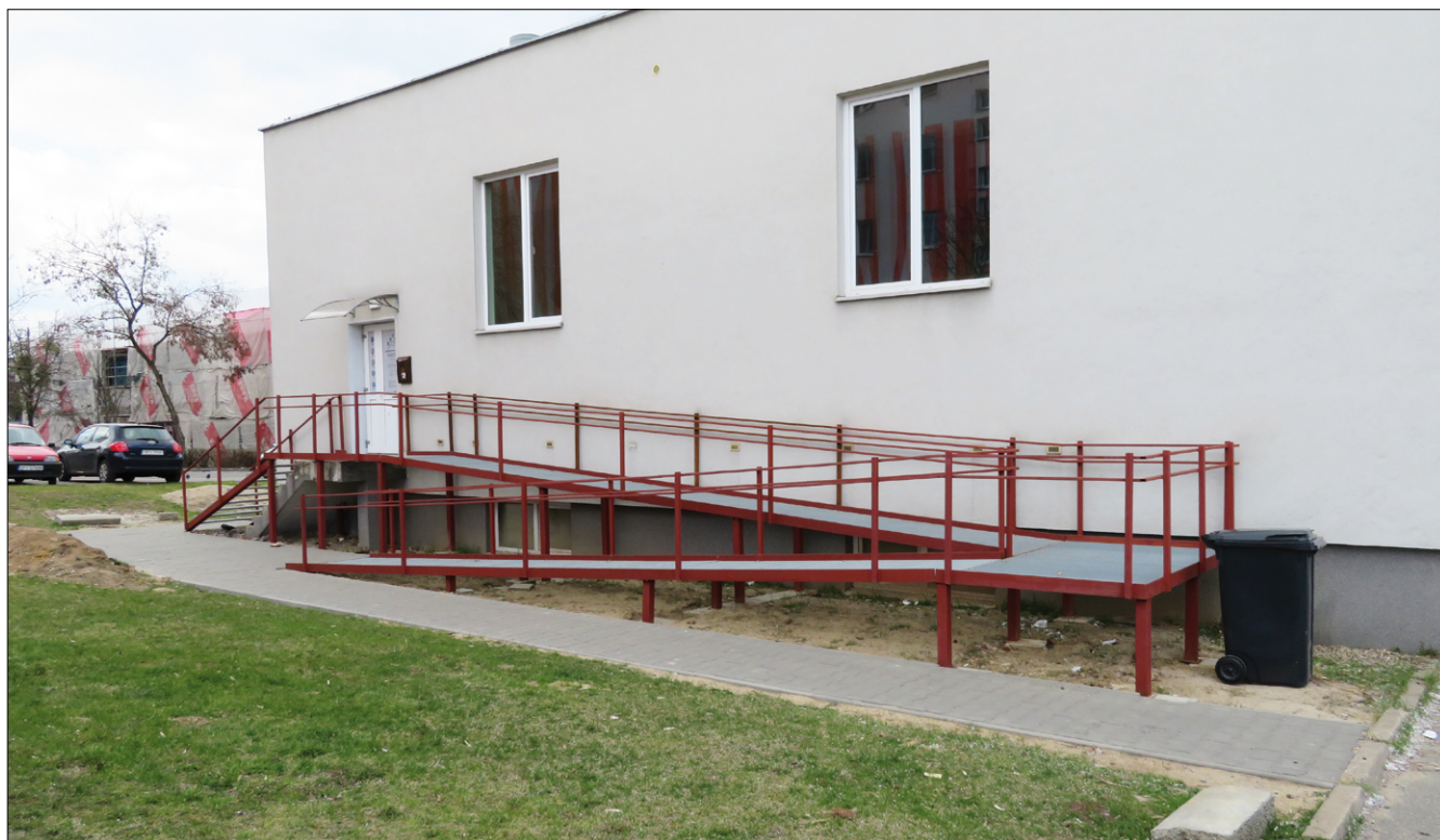
Fot. 1. Budowa pochylni dla osób niepełnosprawnych
