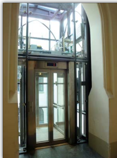
Fot. 5. Dźwig panoramiczny elektryczny z wciągarką w nadzszybiu (prod. KONE)
