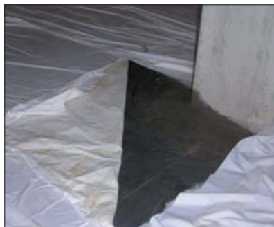
Fot. 7 | Pielęgnacja posadzki fizeleiną z folią PE, widok po trzech tygodniach
