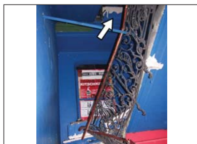
Fot. 4 | Zawalone pod ciężarem tłumu schody w starej kamienicy (fot. Maciej Grzyb) [19]
