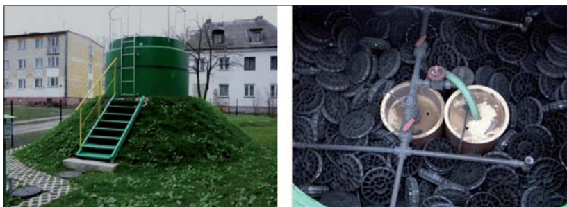
Fot. 1 | Przydomowa oczyszczalnia ścieków ze złożem biologicznym (fot. M. Marzec)
