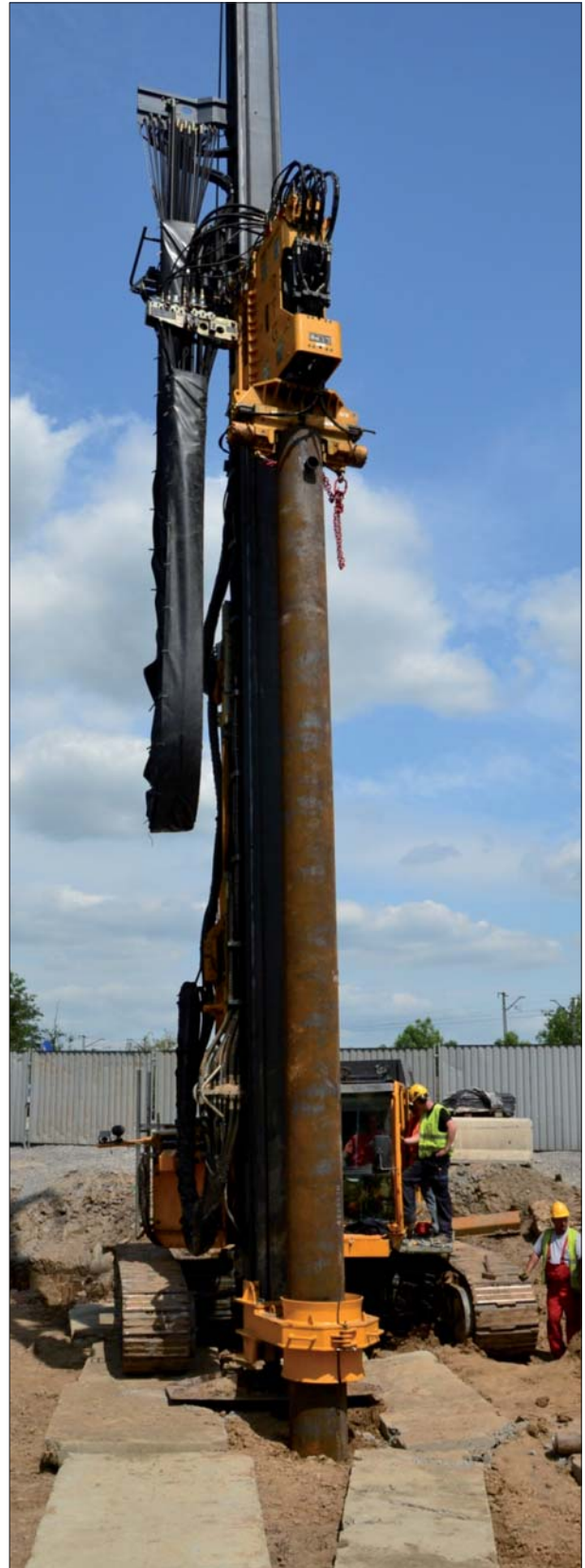
Fot. 3 | Maszyna w czasie pograżania rury wibromłotem
