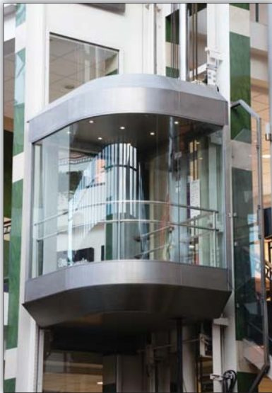
Fot. 6. Dźwig panoramiczny hydrauliczny (prod. OTIS)
