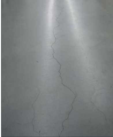
Fot. 1 | Typowe pęknięcia posadzki
