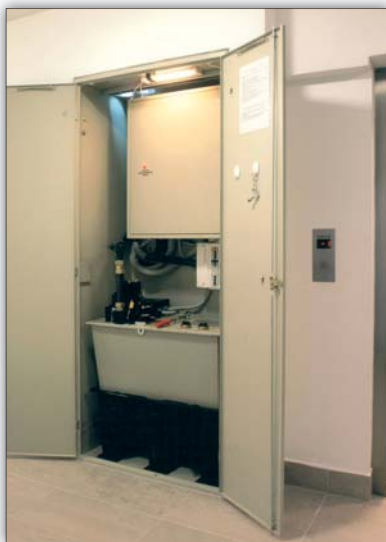
Fot. 4. Zespół napędowo-sterujący dźwigu hydraulicznego w osłonie poza szybem, tzw. maszynownia prefabrykowana, udźwig 630 kg
