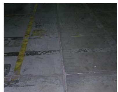
Fot. 5 | Zniszczenie krawędzi dylatacji z powodu curlingu
