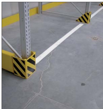
Fot. 8 | Pęknięcia od nacięć pętli indukcyjnej
