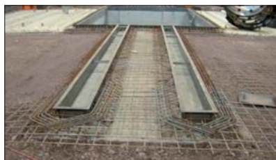
Fot. 6 | Dozbrojenie posadzki przy narożach i kanałach
