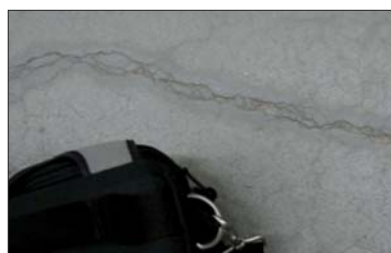
Fot. 2 | Wykruszenia przy pęknięciu posadzki
