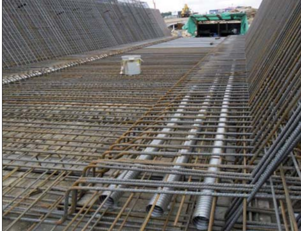
Fot. 2 | Zbrojenie ustroju nośnego o przekroju skrzynkowym na estakadzie WS-02a pod Międzyrzeczem
