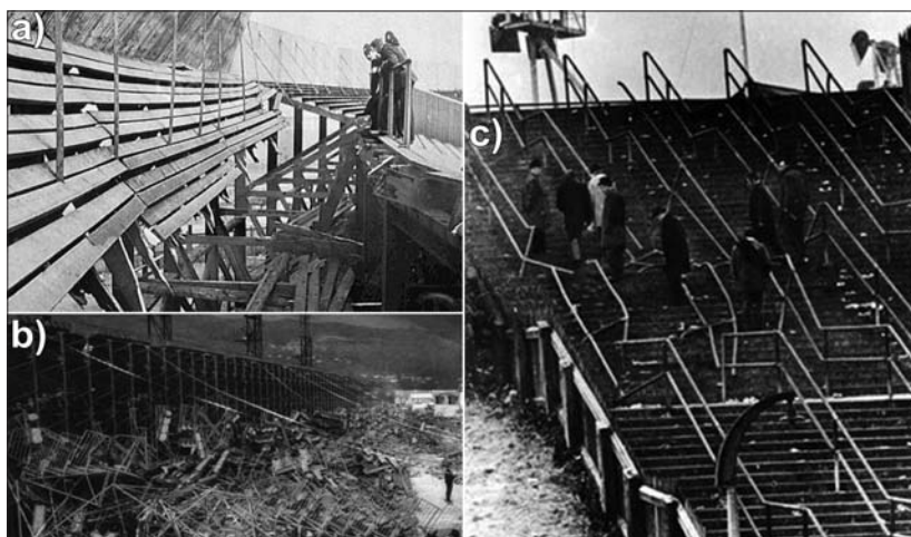
Fot. 1 | Przykłady katastrof obiektów budowlanych spowodowanych przeciążeniem: a) połamane elementy trybuny stadionu Ibrox Park w Glasgow, Szkocja 1902 [16]; b) zawalona tymczasowa trybuna, dostawiona do stałej na stadionie Armand Cesari, Francja 1992 [17]; c) połamane bariera schodów na stadionie Ibrox Park w Glasgow, Szkocja 1971 [18]
