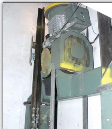
Fot. 3. Dźwig elektryczny bez maszynowni (prod. Schindler), wciągarka bez-reduktorowa w nadszybiu
