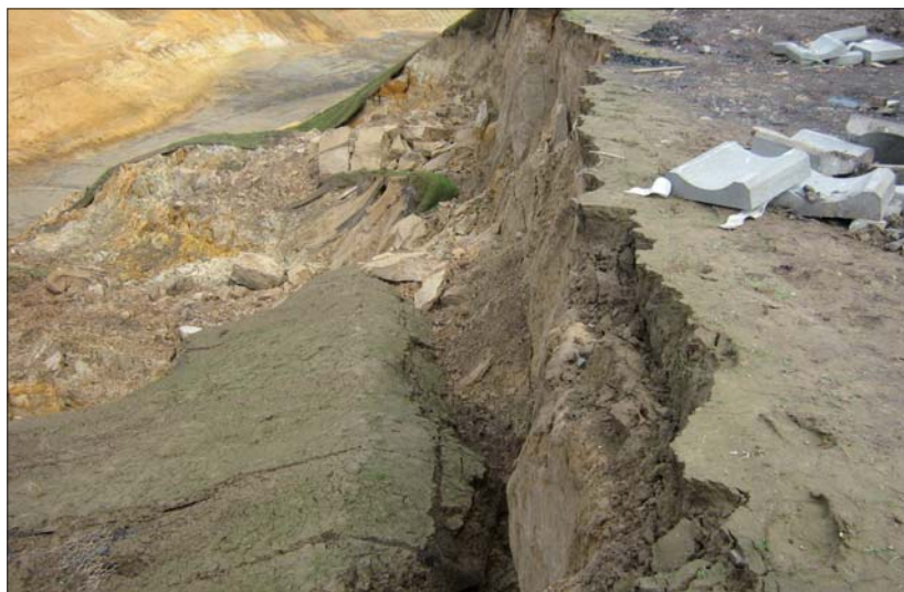
Fot. 2 | Widok na osuwisko
