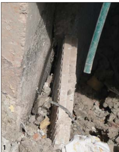
Fot. 1, 2 | Błędy przy wykonywaniu oraz uszkodzenia powłoki hydroizolacyjnej z masy KMB
