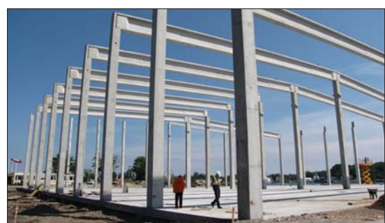
Fot. 1 Budowa płyty fundamentowej TAB-Structural™, opartej na palach w budynku Chłodni Magazynowej, Dalekomorski Port Rybacki w Gdańsku, Wolny Obszar Celný. Płyta ma grubość 400 mm. Założona wartość równomiernie rozłożonego obciążenia użytkowego 100 kN/m 2 wymagała dozowania włókien Twincone 1/54 na poziomie 50 kg/m 3 , na siatce pali 3,7 m x 2,0 m. Włókna stalowe były aplikowane do mieszanki betonowej na betoniarni za pomocą integratorów (wdmuchiwarek). Mieszankę betonową układano dziennie na powierzchni od 730 m 2 do 1260 m 2
