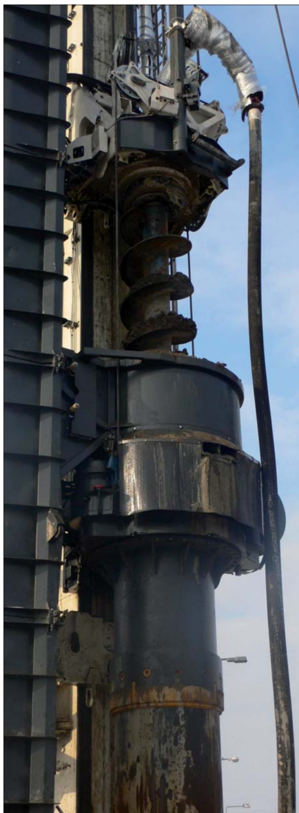
Fot. 4 | Świder ciągły wewnątrz rury obsadowej (fot. Warszawskie Przedsiębiorstwo Mostowe Mosty SA)
