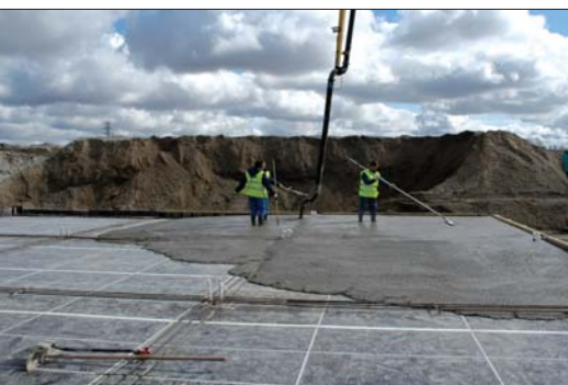
Fot. 4 | Typowy przykład stropu TAB-Slab, z włóknami stalowymi jako jedyną formą zbrojenia betonu, zastosowanego dla swobodnie podpartego, międzykondygnacyjnego stropu grub. 180 mm o gładkiej powierzchni sufitowej, zbrojonego włóknami TABIX 1.3/50 dozowanych 100 kg/m 3 . Dodatkowe zbrojenie zapobiegające rozprzestrzenianiu się stanów awaryjnych ułożono pomiędzy słupami
