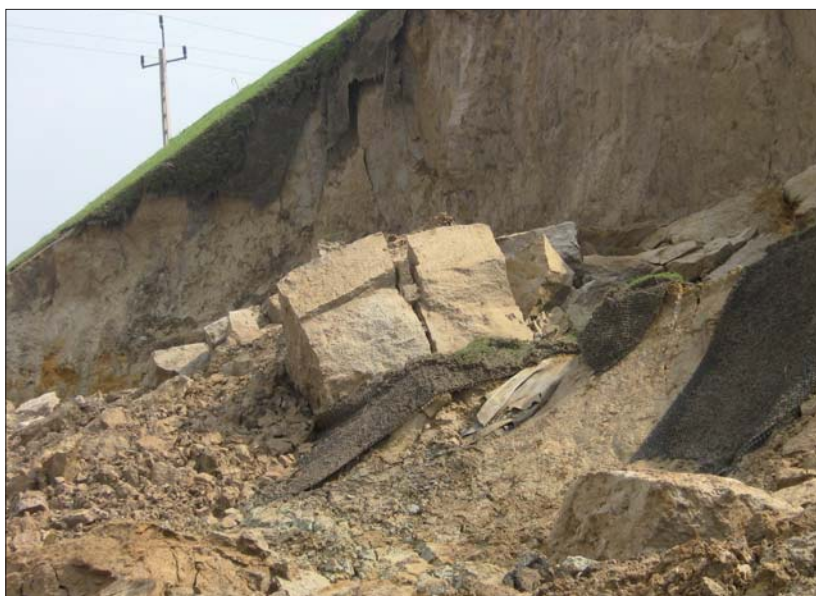
Fot. 1 | Spękania gruntu – obrywy
