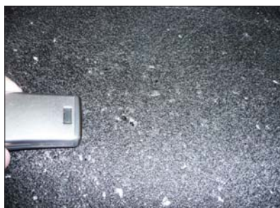
Fot. 3 | Drobną, lecz dokuczliwą usterką izolacji z masy KMB
