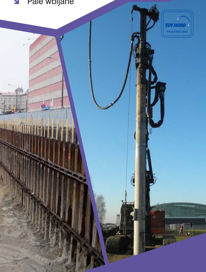
Fot. 5 | Głowica obrotowa do wykonywania palisad (VDW). Widać, że część do zamontowania rury jest najbardziej wystającym elementem głowicy
