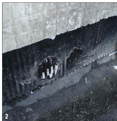
Fot. 1, 2 | Błędy przy wykonywaniu oraz uszkodzenia powłoki hydroizolacyjnej z masy KMB
