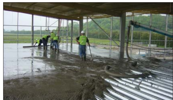
Fot. 6 | Strop zespolony TAB-Deck™ o grubości 150 mm na blachach trapezowych z zastosowaniem zbrojenia włóknami HE 1/50 dozowanych 30 kg/m 3 (budowa w Thanet, Wielka Brytania)
