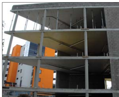
Fot. 5 | Gotowa konstrukcja budynku w Tallinie, Estonia. W budynku wykonano pięć stropów międzykondygnacyjnych o grub. 230 mm i rozpiętości 7,5 m, jak również płytę fundamentową. Dla wszystkich ww. elementów zastosowano dozowanie włókien na poziomie 80 kg/m 3
