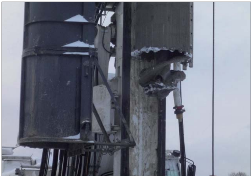
Fot. 1 | Spód rury obsadowej z wystającym świdrem ciągłym
