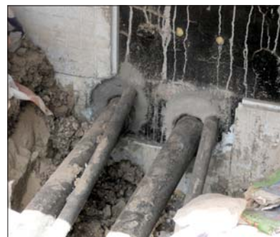
Fot. 4 | Błędne uszczelnienie przejścia rurowego
