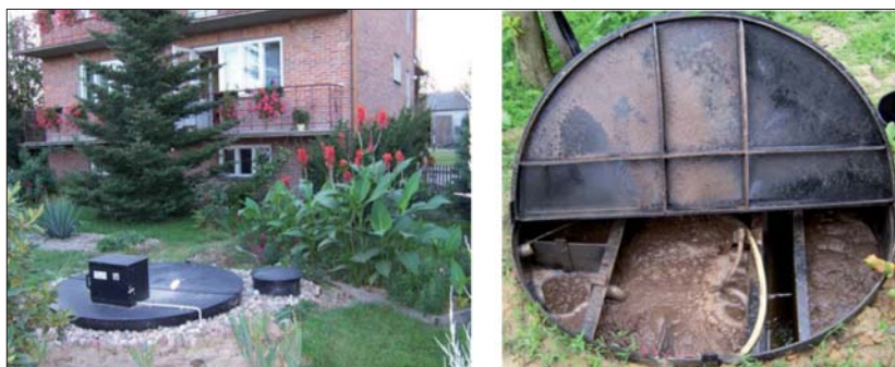
Fot. | Przydomowa oczyszczalnia z osadem czynnym (fot. autor)
