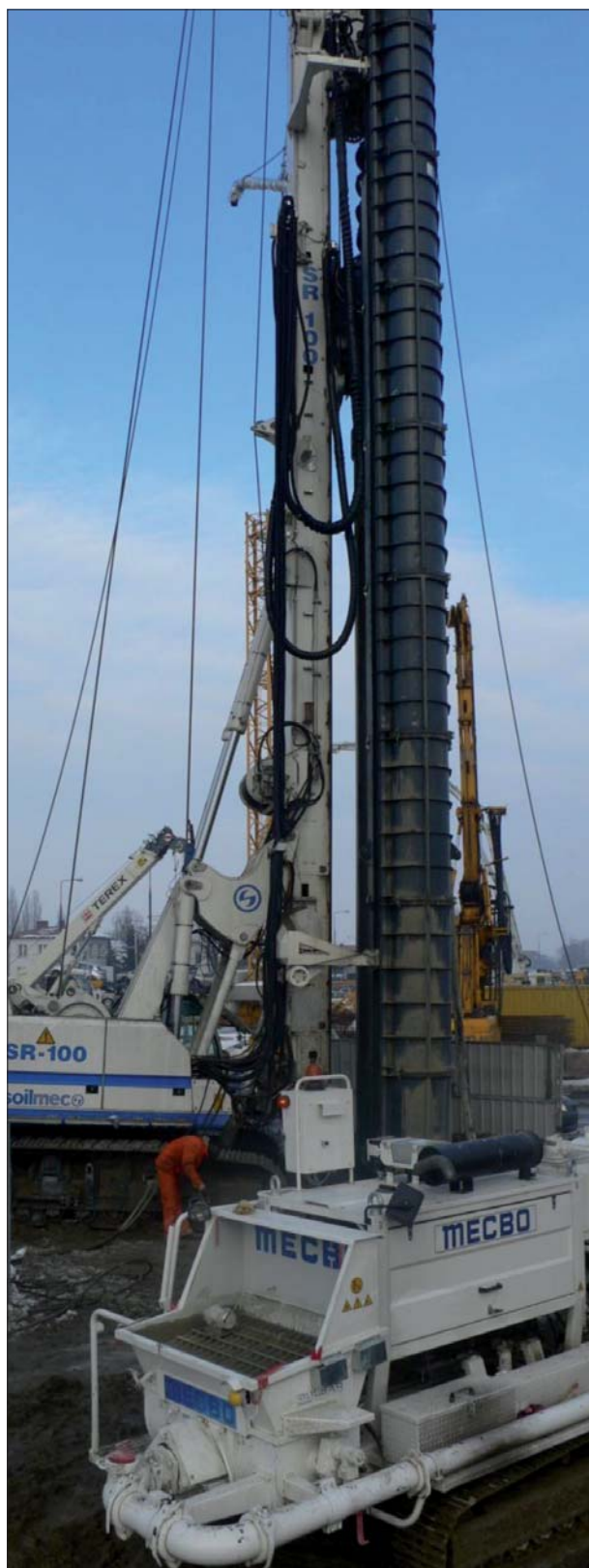
Fot. 3 | Maszyna z pompą przejeżdżną, która może podążać za maszyną na placu budowy (fot. Warszawskie Przedsiębiorstwo Mostowe Mosty SA)
