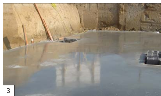
Fot. 2 i 3 TAB-Raft™ jako płyta denna układana na gruncie pod wielorodzinnym budynkiem mieszkalnym. Płyta o pow. 2000 m 2 , grub. 350 mm. Rys. 3 przedstawia układanie mieszanki z włóknami TABIX 1,3/50 dozowanymi 80 kg/m 3 oraz pogrubienie płyty dla stopy fundamentowej słupa. Rys. 4 przedstawia stan wykończenia powierzchni płyty z zatarciem na gładko, stosownie do wymogów stawianych nawierzchniom w garażach samochodowych
