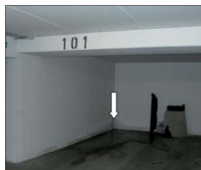
Rys. 6 | Kondensacja pary wodnej z ciepłego powietrza w lecie na chłodnych ścianach garażu. Przy częstym występowaniu i utrzymywaniu się zawilgocenia powoduje destrukcję podłoża – ściany
