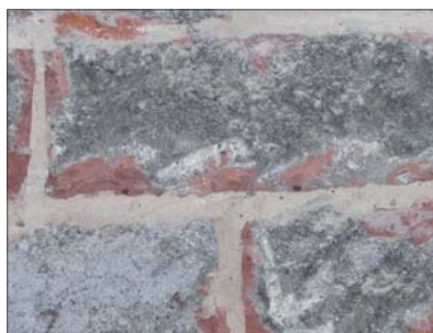
Fot. 4 | Dwa podstawowe błędy przy wykonywaniu obrzutki: 1 – obrzutka powinna pokrywać maks. 50% powierzchni ściany i musi być wykonana w postaci „szprycu”; 2 – zbyt długa przerwa po wykonaniu obrzutki może skutkować wysoleniami na powierzchni muru
