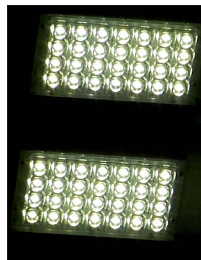
Fot. 3 Widok fragmentu zaświeconej oprawy oświetlenia ulicznego LED. Funkcje oświetleniowe spełniają elementarne diody elektroluminescencyjne
