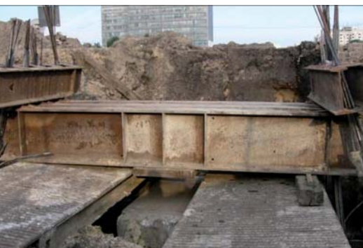
Fot. 1 | Konstrukcja do próbnego obciążenia barety z wykorzystaniem kotew
