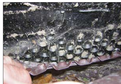
Fot. 6 Skutki położenia masy KMB na źle przygotowanym podłożu (opis w tekście)
