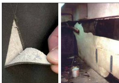
Fot. 4 Skutki położenia szlamu na nieoczyszczonej ścianie, odspojenie następuje razem z niestabilnymi cząstkami (fot. Weber Deitermann)
