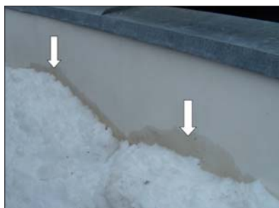
Rys. 3 | Zalegający przy ścianie śnieg powoduje nadmierne zawilgocenie ściany i w razie zamarznięcia trwałą destrukcją materiału. Zdjęcie wykonane w pierwszym roku użytkowania obiektu po przekazaniu
