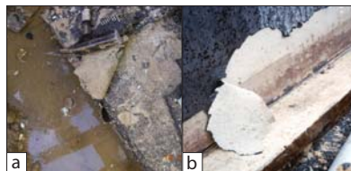
Fot. 1 Skutki położenia masy KMB na źle przygotowanym podłożu (opis w tekście)
