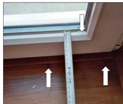
Rys. 5 | Kondensacja pary wodnej wynika zwykle z braku właściwego wietrzenia. W tym przypadku wykroplona woda powoduje destrukcję posadzki z parkietu
