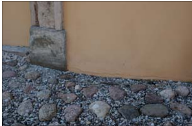
Fot. 7 | Tynk nie powinien stykać się z gruntem, należy pozostawić tam szczelinę
