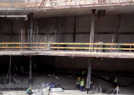
Fot. 3 | Baretę jako fundamenty stalowych słupów tymczasowych w metodzie stropowej
