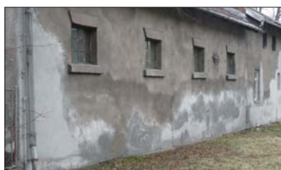
Fot. 1,2 Tradycyjne tynki położone na ścianie bezskutecznie działających powłok wodochronnych
