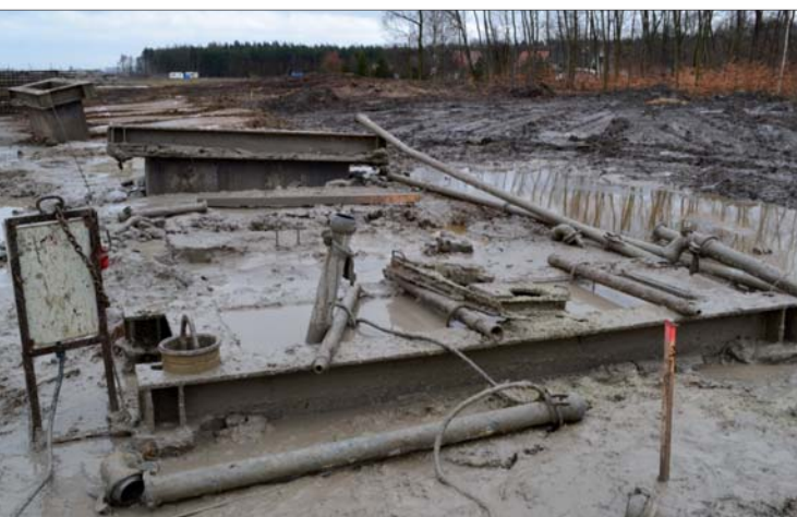
Fot. 4 | Stalowe murki prowadzące wielokrotnego użytku
