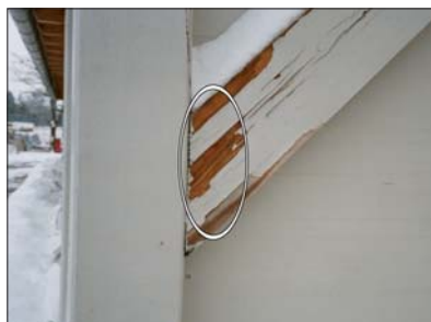
Rys. 4 | Zalegający śnieg prowadzi do destrukcji budowli. Na tym przykładzie stanowi to zarazem błąd projektowy. Zdjęcie w drugim roku użytkowania obiektu po przekazaniu
