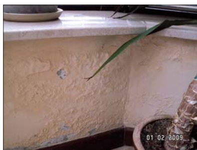
Fot. 3 Skutki braku izolacji wewnętrznej w budynku niepodpiwniczonym (opis w tekście)
