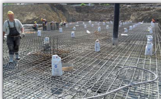
Fot. 1 Uszczelnianie płyty fundamentowej i zalewanie betonem
