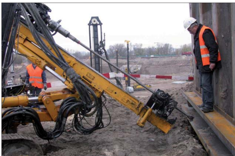
Fot. 4 | Wykonanie kotew w systemie samowiercącym typu Titan.
