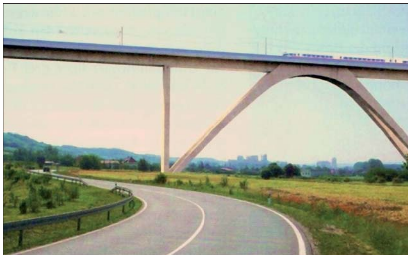
Fot. 5 | Wiadukt przez dolinę Unstrut na LDP Erfurt–Lipsk/Halle (Niemcy) [11]
