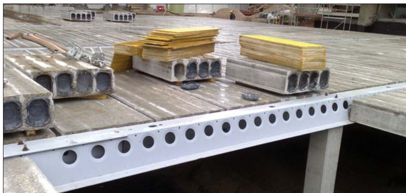
Fot. 1 | Podciąg Deltabeam® ukryty w wysokości płyt HC
