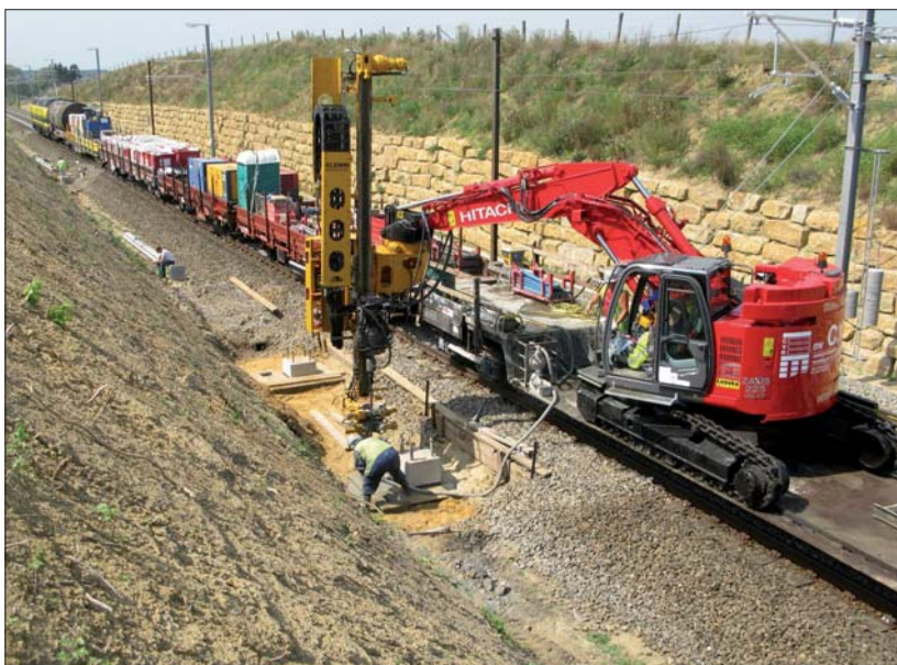
Fot. 2 | Wykonywanie mikropali pod słupy trakcyjne, widoczne zaplecze budowy zmieszane na platformie pociągu roboczego
