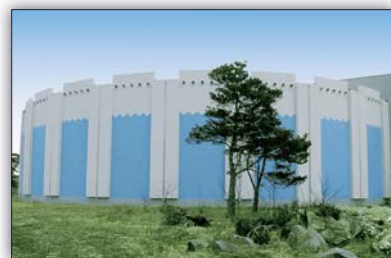
Fot. 3 | ...a także zbiorników na wodę pitną (atest PZH)
