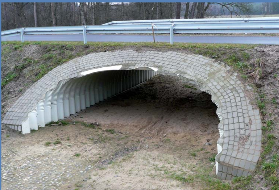
Dolne przejście dla zwierząt pod drogą ekspresową S3 w rejonie Zielonej Góry
