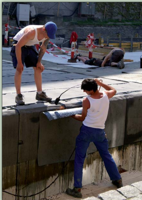
Fot. 3 | Wykonywanie izolacji przeciwwodnej z papy termozgrzewalnej
