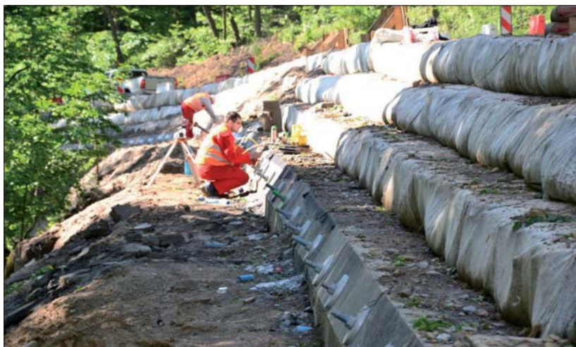
Fot. 5 | Zabezpieczenie osuwiska palisadą kotwioną prętami typu Titan
