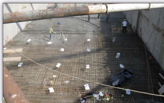
Fot. 2 Uszczelnianie płyty dennej między ścianami szczelinowymi
