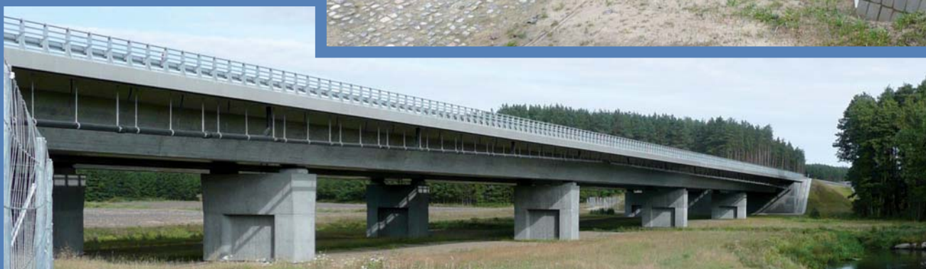
Dolne, duże przejście dla zwierząt w ciągu autostrady A1 na odcinku Nowe Marzy – Gdańsk
