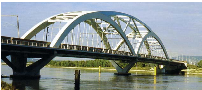
Fot. 1 | Most La Garde-Adhémar nad kanałem Donzère na LDP Méditerranée (Francja) [15]
