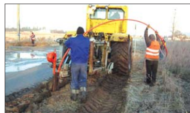
Układanie wiązki Novonet DB 5x10+7 przy pomocy pługoukładacza
