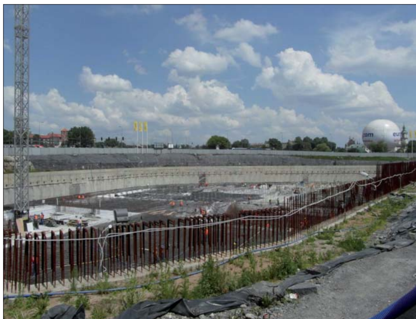
Fot. 1 | Wykop Centrum Kongresowego w Krakowie zabezpieczony kotwami
