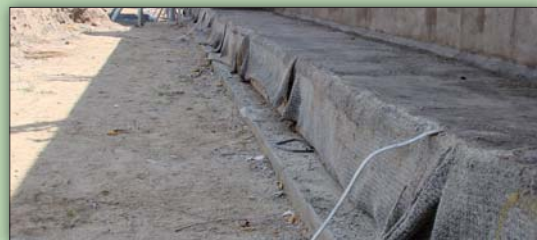
Fot. 7 I Izolacja płyty fundamentowej wykonana z bentonitu
