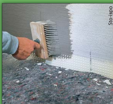
Fot. 5 | Mikrozaprawy mogą być nanoszone ręcznie, np. pędzlem ławkowcem
