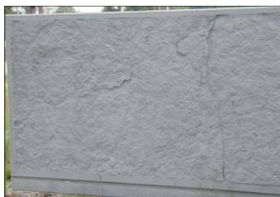
Fot. 5 | Beton elewacyjny wykonany na matrycy silikonowej – technologia SCC
