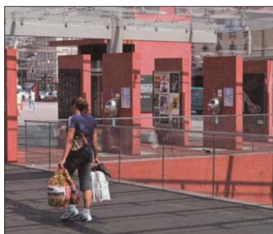
Fot. 3 | Szerokie możliwości wykorzystania efektów barwnego betonu – dworzec kolejowy w Bernie, Szwajcaria
