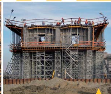
Estakada E118 w ciągu A4
