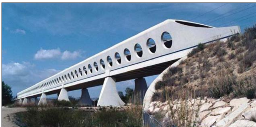
Fot. 3 | Most Osera przez Ebro w postaci belki Vierendeela (LDP Madryt–Szaragosa) [6]
