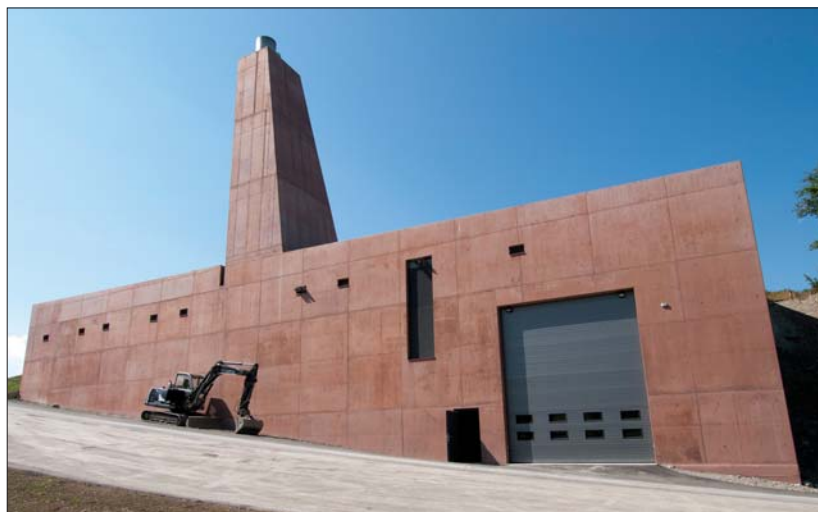
Fot. 6 | Zastosowanie betonu kolorowego – budynek Holzheizzentrale Haldenweg w Menzingen
