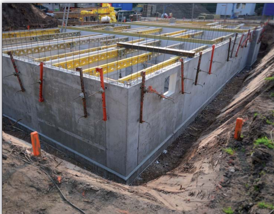
Fot. 1 | Hydroizolacja przyziemnych części budynku musi być dobrana przy uwzględnieniu warunków gruntowo-wodnych
