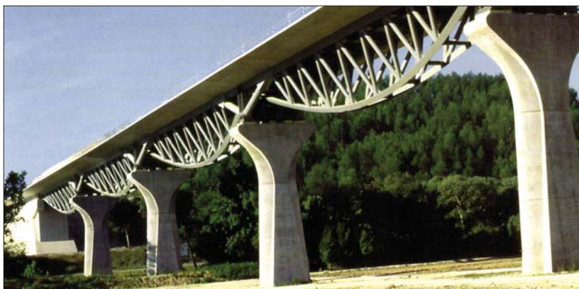
Fot. 2 | Wiadukt de l'Arc koło Ventabren na LDP Méditerranée (Francja) [15]
