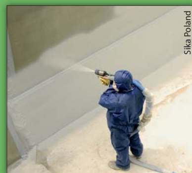
Fot. 6 | Na dużych powierzchniach mikrozaprawy rozprowadza się mechanicznie
