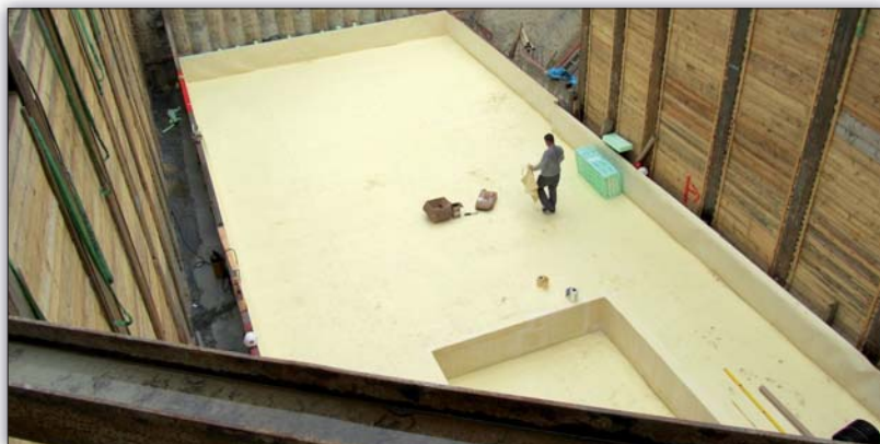
Fot. 2 Instalacja membrany hydroizolacyjnej SikaProof®A na płycie dennej
