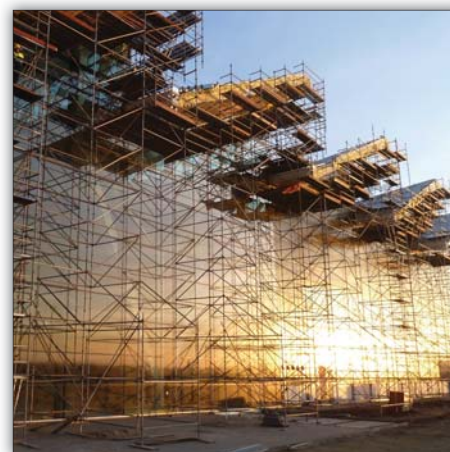
Nowy terminal lotniczy w Gdańsku – montaż elewacji
