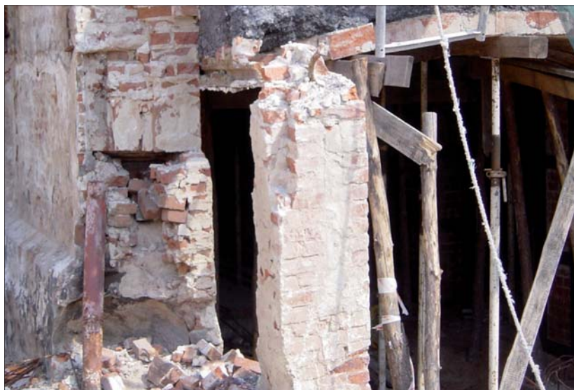
Fot. 2 | Struktura ściany w płaszczyźnie zniszczenia
