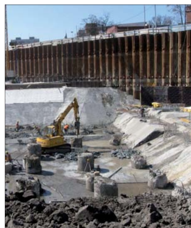
Fot. 2 | Obudowa wykopu kotwiona w trzech poziomach jednego z najwyższych budynków w Polsce (SkyTower we Wrocławiu)
