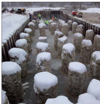
Fot. 5 Ścianka szczelna jako obudowa wykopu fundamentów Mostu Północnego w Warszawie. Zabetonowanie ścianki razem z fundamentem zwiększa jego nośność i znacząco poprawia odporność na rozmycie
