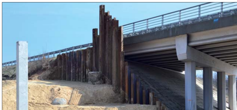
Fot. 6 | Ścianka umożliwiająca wykonanie sąsiedniej nitki obwodnicy Kielc
