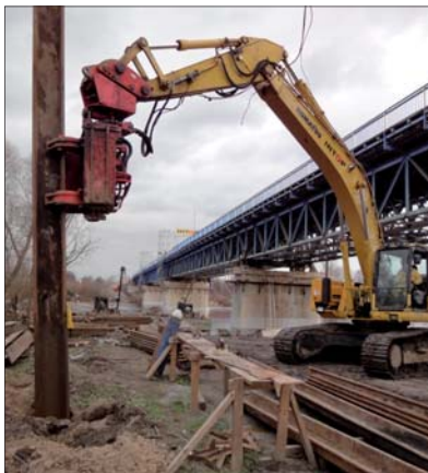
Fot. 4 | Urządzenie umożliwiające uchwycenie ścianki w trakcie pograżania blisko powierzchni terenu. Zmniejszenie długości wybozczeniowej znacząco zwiększa efektywność pograżania ścianki. Analogicznym urządzeniem podjęto skuteczną próbę przebicia ścianką szczelną starej autostrady betonowej w okolicach Gliwic.
