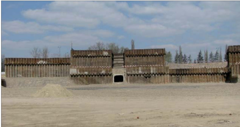
Fot. 3 | Ścianka szczelna oddzielająca poszczególne platformy robocze na budowie Stadionu Narodowego w Warszawie (I etap)
