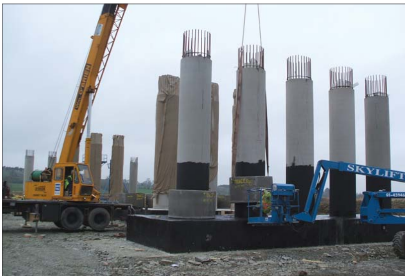
Fot. | Rękawy z kręgów betonowych
