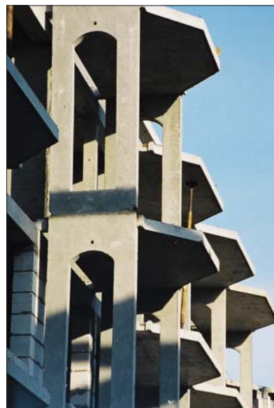
Fot. 9 | Prefabrykowane elementy ścienne oraz balkonowe [6]
