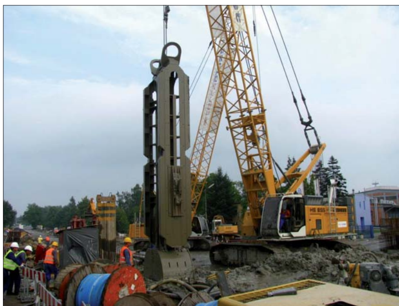
Fot. 3 | Chwytak linowy w trakcie głębienia szczeliny
