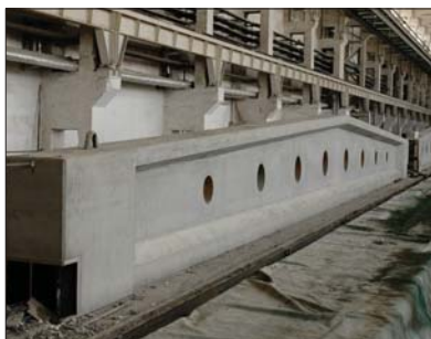
Fot. 5 | Dźwigary sprężane w trakcie wykonywania (fot. G. Adamczewski)
