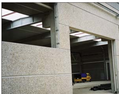
Fot. 6 | Prefabrykowane architektoniczne płyty ścienne [6]
