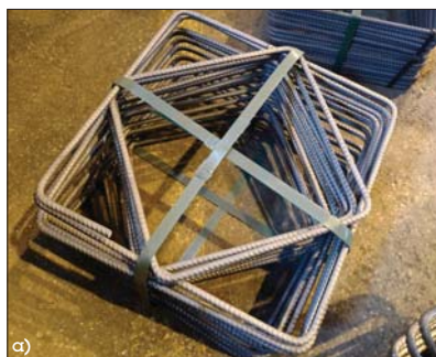
Fot. 11 | Prefabrykowane zbrojenie w postaci dostarczanej na budowę (a) oraz przed wprowadzeniem do deskowania (b) (fot. G. Adamczewski)
