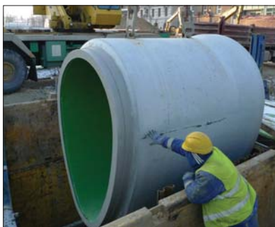
Fot. 7 | Rurowy element prefabrykowany PEHD o przekroju jajowym 2400 mm (fot. G. Adamczewski)
