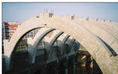
Fot. 3 | Prefabrykowane dźwigary w konstrukcji kościoła [6]
