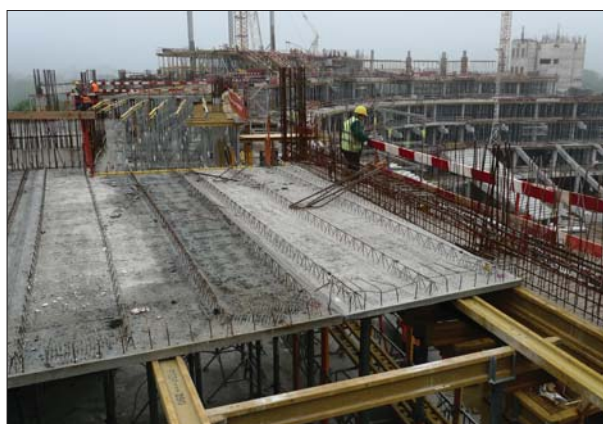
Fot. 2 | Wykonywanie prefabrykowanego stropu typu filigran (fot. G. Adamczewski)
