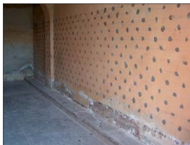
Fot. | Iniekcja strukturalna w ścianę (fot. C. Magott)
