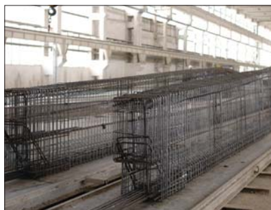
Fot. 10 | Zbrojenie dźwigarów sprężanych przed zaformowaniem (fot. G. Adamczewski)
