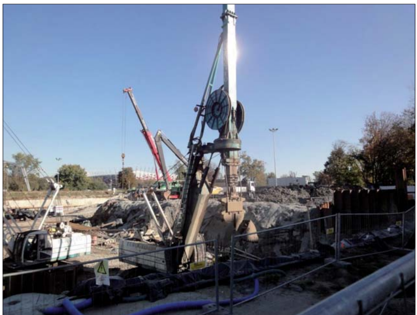
Fot. 2 | Chwytak na żerdzi w trakcie wykonywania ścian szczelinowych na stacji metra Powiśle
