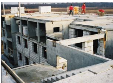
Fot. 8 | Budynek mieszkalny wykonywany z elementów prefabrykowanych [6]
