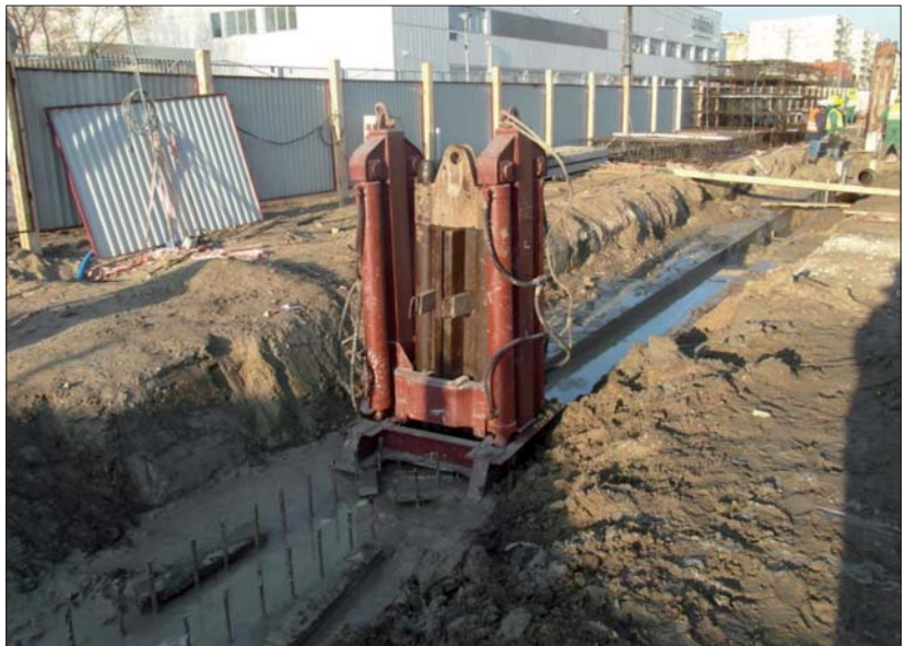
Fot. 1 | Płaski element rozdzielczy ze szczeliną służący do zamontowania uszczelki wraz z urządzeniem do wyciągania elementu
