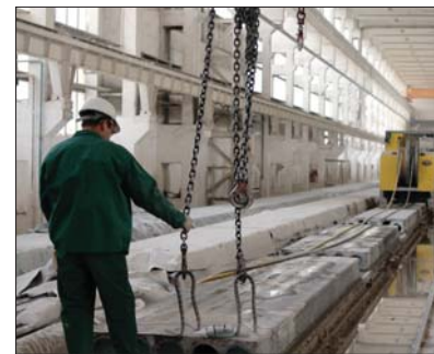
Fot. 12 | Wykonywanie kanałowych płyt sprężanych (fot. G. Adamczewski)
