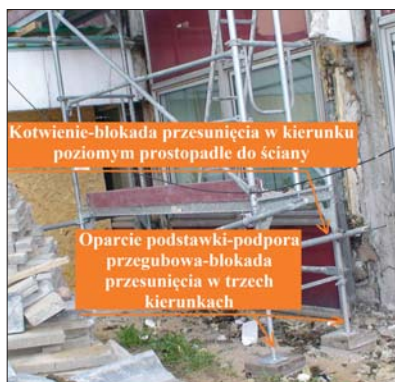
Fot. 1 | Modelowanie podpór rusztowania
