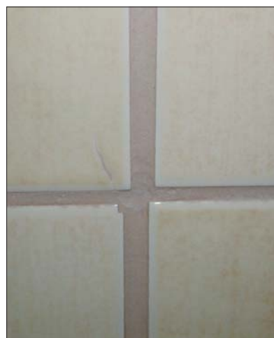
Fot. 3 | Niewłaściwe wykonanie spoin płytek ceramicznych. Zastosowanie uszkodzonych (złe dociętych) płytek ceramicznych
