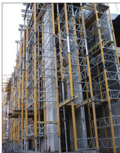
Fot. 3 | Rusztowania podczas budowy
