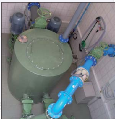
Fot. | Przepompownia AWALIFT w Czarnkowie
