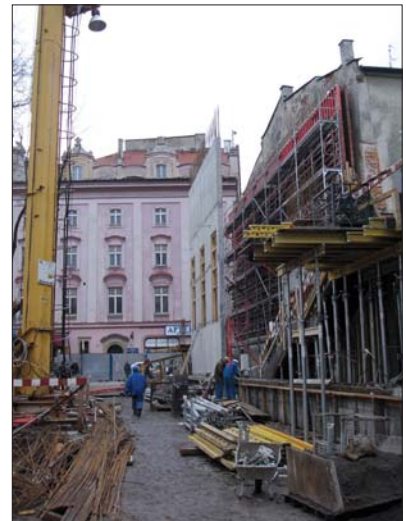
Fot. 2 | Widok na ścianę z witrażami podczas budowy
