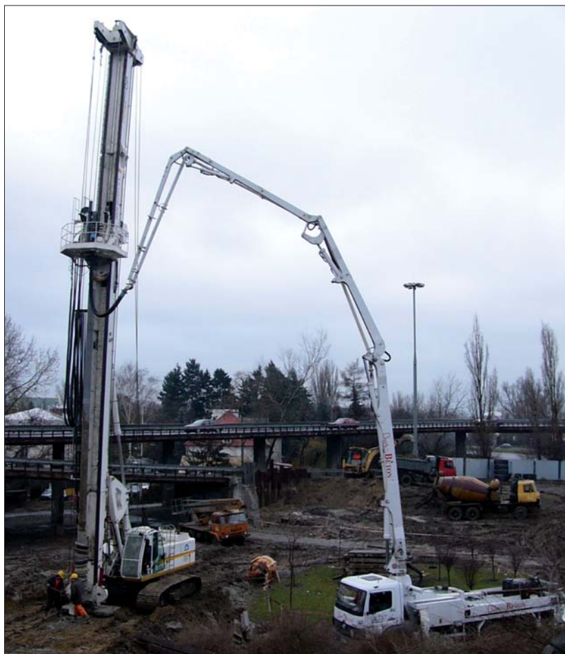
Fot. 3 | Maszyna w czasie wykonywania pali Omega na dojazdach do Trasy Łazienkowskiej w Warszawie
