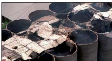
Fot. 1 | Przykład zniszczonego w wyniku wybuchu pyłów stropu nadkomorowego w baterii silosów zbożowych
