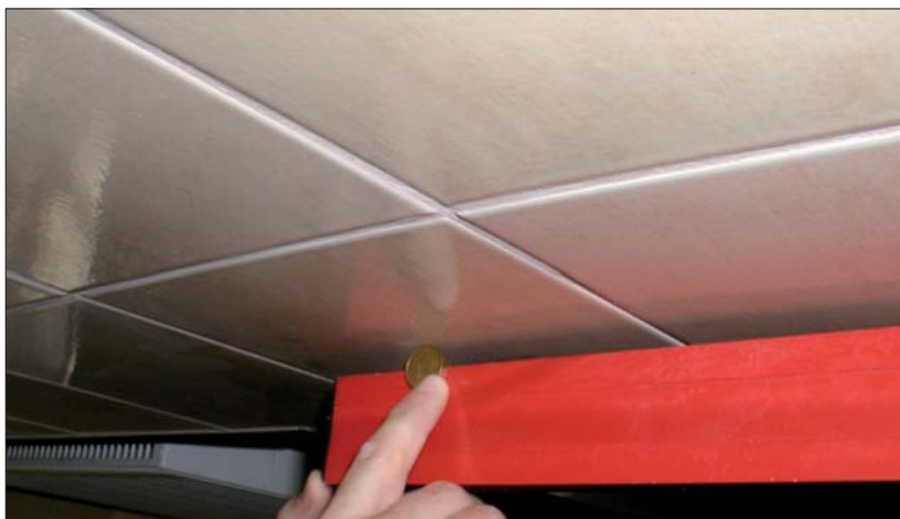
Fot. 1 | Odchylenie powierzchni płytek ceramicznych od płaszczyzny
