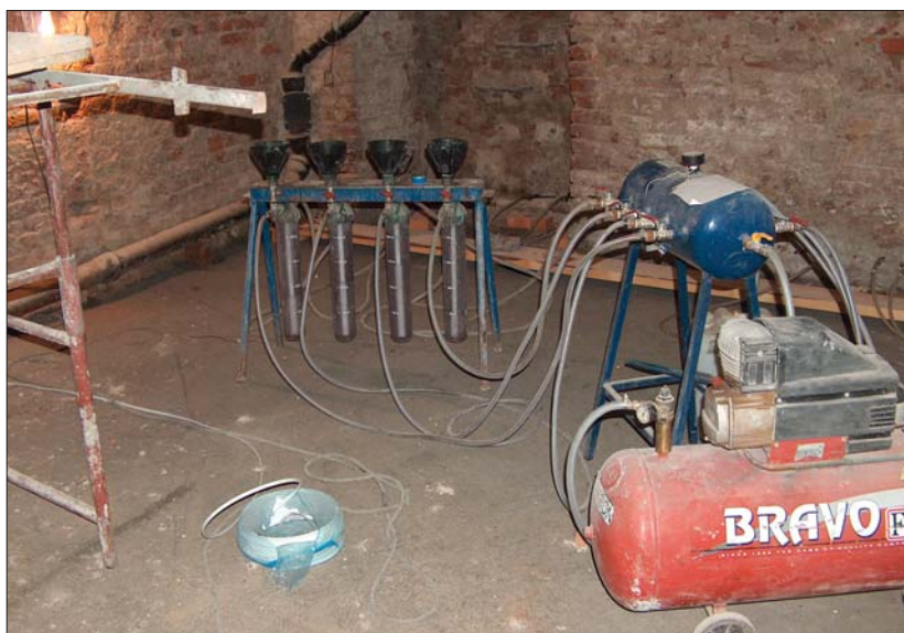
Fot. 2 | Iniekcja ciśnieniowa (fot. C. Magott)
