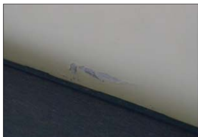
Fot. 12 | Uszkodzenia tynku spowodowane podciąganiem kapilarnym wilgoci
