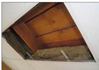
Fot. 6 | Odkrywka w suficie sali
