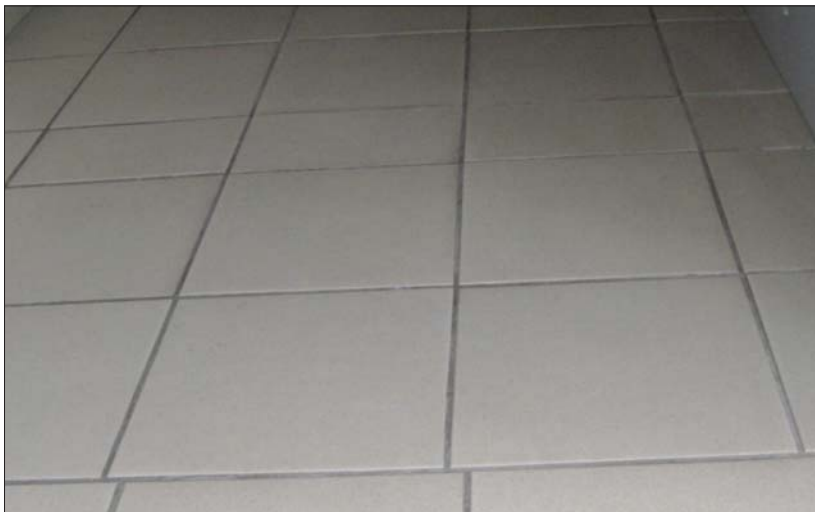
Fot. 2 | Posadzka z niedopuszczalnymi odchyleniami spoin od linii prostej
