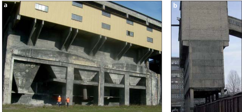
Fot. 4 | Wielokomorowe zbiorniki (bunkry) na węgiel (fot. A. Halicka, K. Gromysz)
