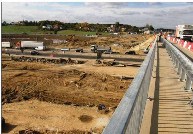
Fot. 3. | Fragment budowy węzła Karczemki z widokiem na Kaszuby
