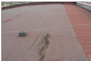
Fot. 2 | Pęknięcie pokrycia dachowego
