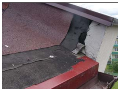
Fot. 4 | Stan pokrycia na krawędzi dachu
