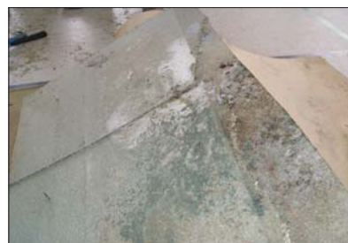
Fot. 11 | Stan spodniej powierzchni płyty
