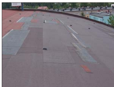
Fot. 3 | Liczne ślady napraw pokrycia
