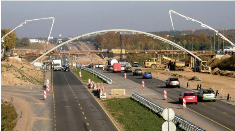
Fot. 2. | Kładka pieszo-rowerowa nad obwodnicą Trójmiasta na wysokości kompleksu handlowego Auchan. Ustrój niosący to stalowa belka ciągła zespolona z żelbetową płytą, podwieszona do dwóch łuków usytuowanych na zewnątrz konstrukcji. Rozpiętości belki wynoszą 7,70 m + 61,60 m + 7,70 m. Konstrukcja, oprócz podwieszenia, oparta jest na ryglach pomiędzy łukami. Na zdjęciu uchwyciono moment podawania betonu jednocześnie z dwóch pomp po dwóch stronach kładki
