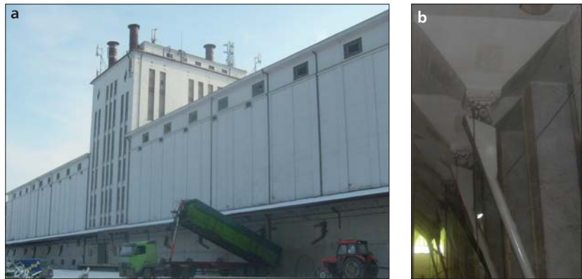
Fot. 3 | Żelbetonowy elewator zbożowy o komorach kwadratowych z lat 20. XX w. w Lublinie (do dziś użytkowany – widok obecny): a) widok z zewnątrz; b) przestrzeń podkomorowa – widoczny szereg lejęw ostrosłupowych (fot. A. Halicka)
