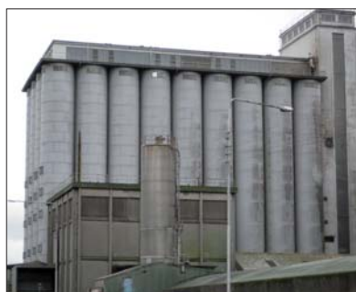
Fot. 1 | Portowy elewator na zboże o komorach cylindrycznych (fot. K. Bąbol)
