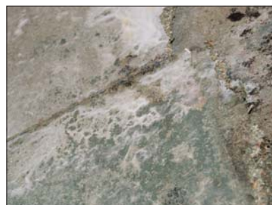
Fot. 8 | Ślady porażenia grzybami pleśni na powierzchni płyty wiórowej, w warstwie kleju
