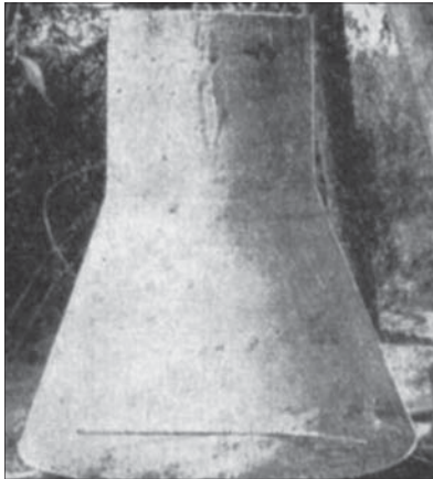
Fot. 6 | Odkopana powiększona podstawa pala
