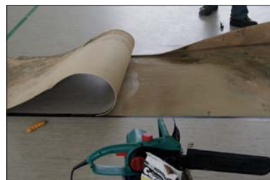
Fot. 7 | Odkrywka w posadzce sali
