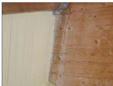
Fot. 5 | Zacieki na ścianie i dźwigarze
