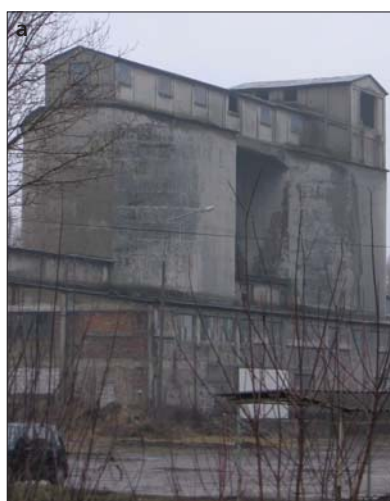
Fot. 2 | Żelbetowe silosy na cement z początku lat 20. XX w. w cementowni w Rejowcu (obecnie nieużytkowane – widok dzisiejszy): a) widok z zewnątrz; b) wnętrze hali obudowującej silosy – widoczny lej silosu w kształcie stożka ściętego (fot. A. Halicka)
