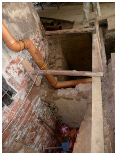
Fot. 1 | Niezainwentaryzowane na etapie diagnostyki pozostałości starych fundamentów znacznie komplikują prace renowacyjne
