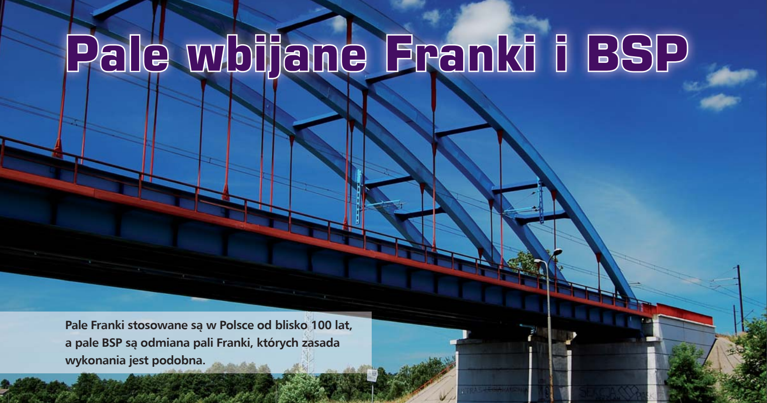
Fot. 1 | Wiadukt kolejowy posadowiony na palach Franki
