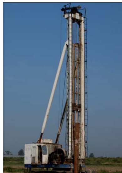
Fot. 2 | Widok maszyny w czasie wbijania pali Franki
