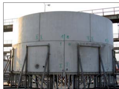
Fot. 5 | Prefabrykaty zamontowane na sucho w miejscu ich produkcji
