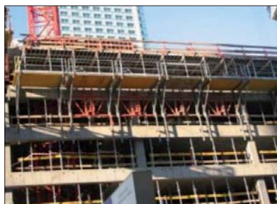
Fot. 1 | Balustrady zamontowane na krawędziach stropu podczas wznoszenia budynku (fot. archiwum PIP)
