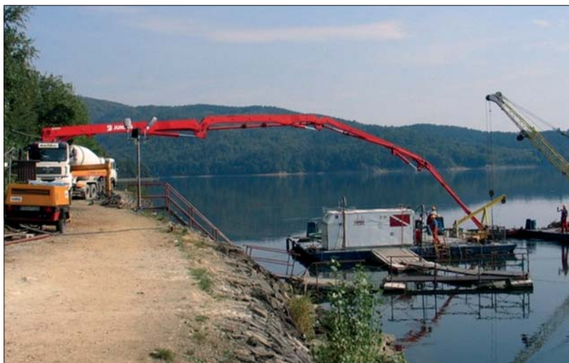
Fot. 4 | Betonowanie fundamentu 15 m poniżej poziomu lustra wody
