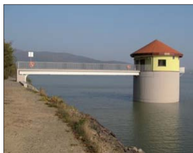
Fot. 1 | Ujęcie wody po ukończeniu budowy
