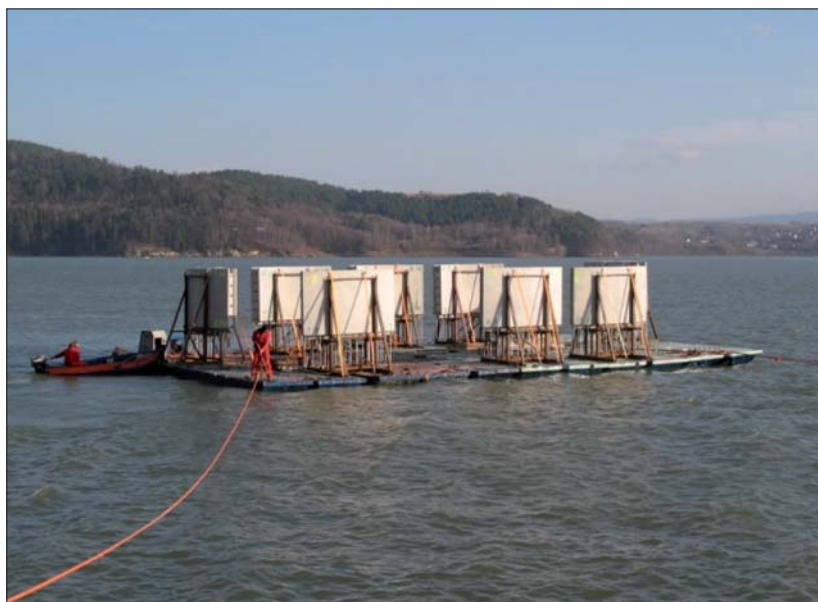
Fot. 6 | Transport jednej warstwy prefabrykatów do miejsca wbudowania
