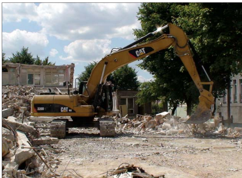
Fot. | Miejsce rozbiórki obiektu o konstrukcji monolitycznej
