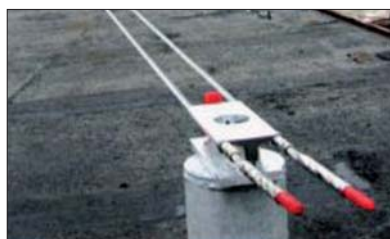
Fot. 5 | Zaczepy taśmowe na kominie (fot. archiwum PIP)
