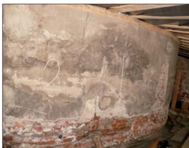
Fot. 3 | Widok, który jednoznacznie świadczy o kilku przyczynach zawilgocenia
