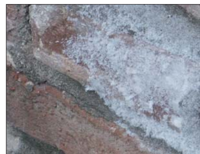
Fot. 4 | Wykwity solne na murze
