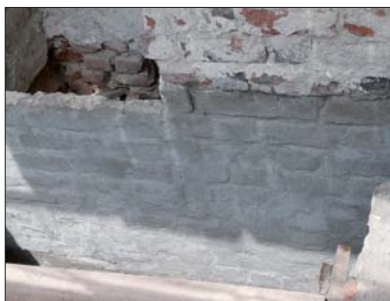
Fot. 2 | Zbadanie struktury przegrody jest niezbędne przy projektowaniu prac iniekcyjnych
