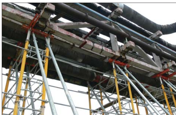
Fot. 1 | Tymczasowe podparcie uszkodzonych kratownic
