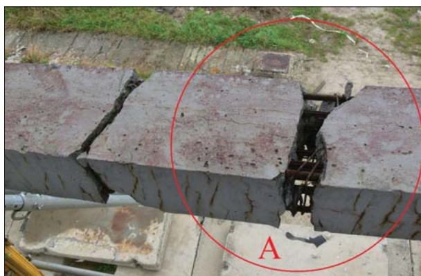
Fot. 2 | Widok fragmentu przerwanego
