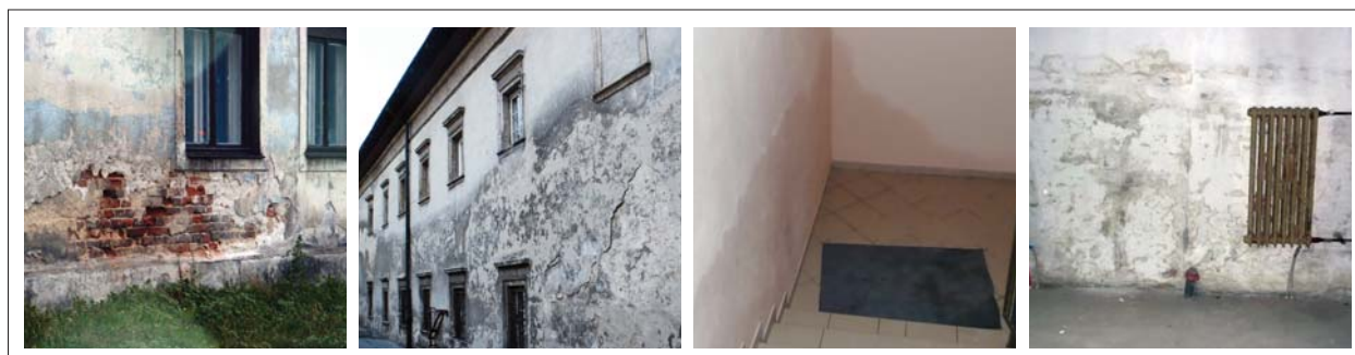
Przykładowe objawy destrukcyjnego wpływu wilgoci na budynek
