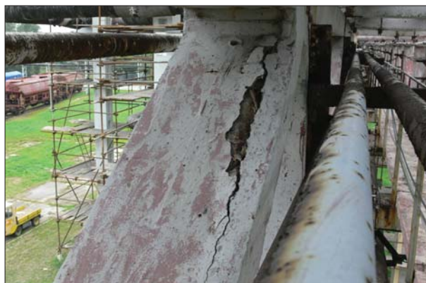
Fot. 6 | Widoczne uszkodzenia krzyżulca i słupka kratownicy
