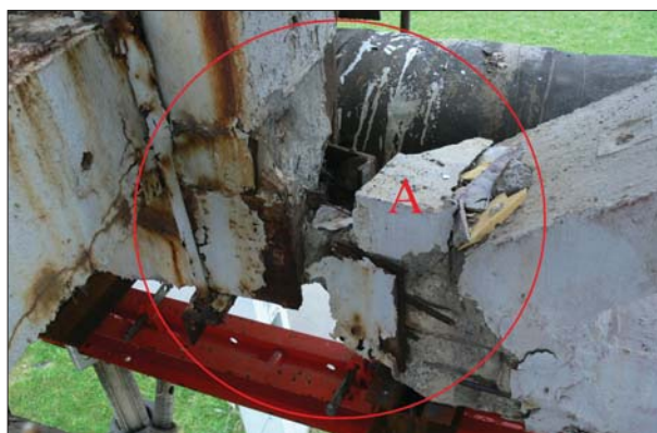
Fot. 4 | Widok ściętego pasa dolnego
