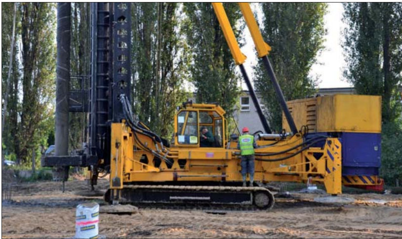
Fot. 3 | Maszyna do wykonania pali Fundex z iniekcją
