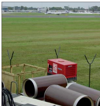
Fot. 1 | Przejście pod pasem startowym lotniska w Gdańsku
