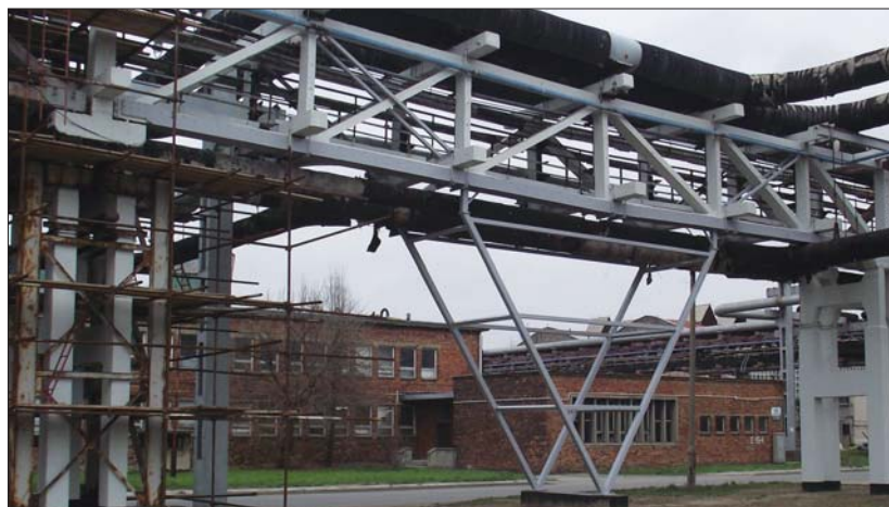
Fot. 7 | Widoczne uszkodzenia krzyżulca i słupka kratownicy
