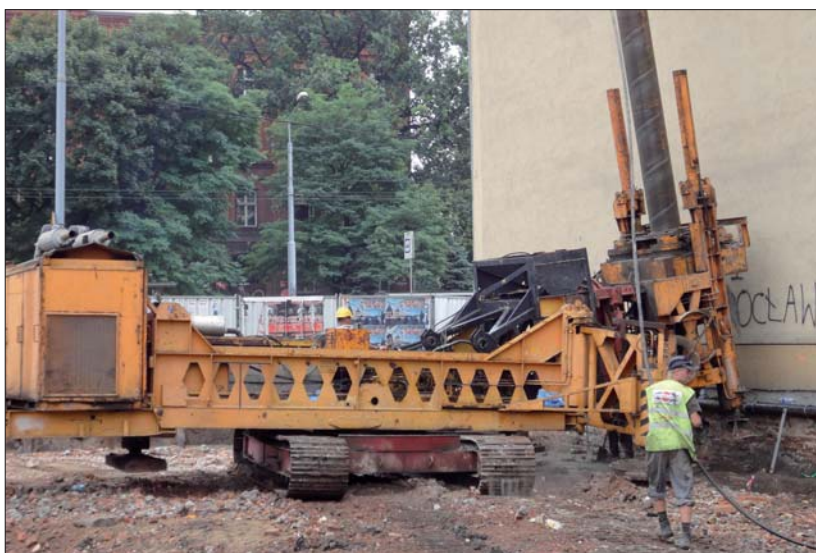
Fot. 1 | Maszyna do wykonania pali Tubex
