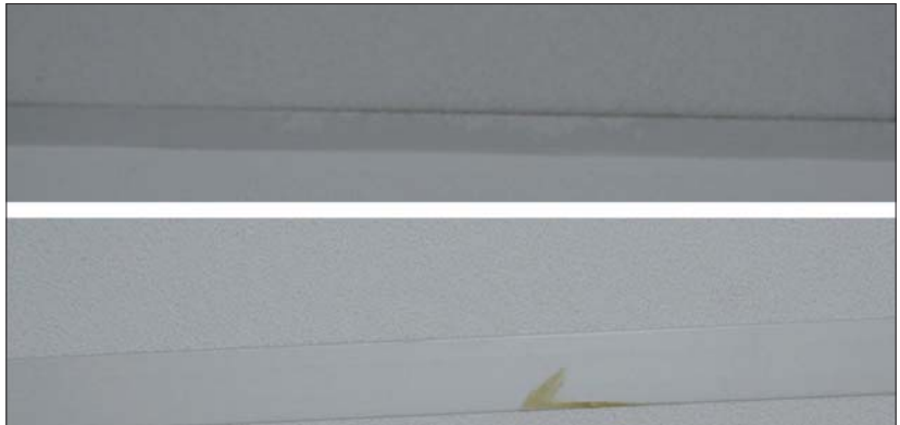
Fot. 9 | Typowe zabrudzenia sufitów podwieszanych farbami
