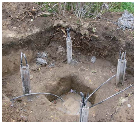
Fot. 1 | Główce mikropali przygotowane do próbnego obciążenia; widać ich zbrojenie i rurki iniekcyjne
