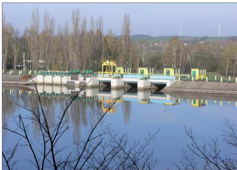
Fot. 1 | Widok na zapórę w Niedowie przed katastrofą (fot. W. Rędowicz)
