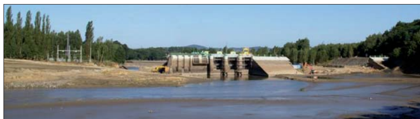
Fot. 2 | Stan po katastrofie. Widoczny blok upustowy i po jego prawej stronie jedyny pozostały po katastrofie fragment korpusu ziemnego (fot. W. Rędowicz)
