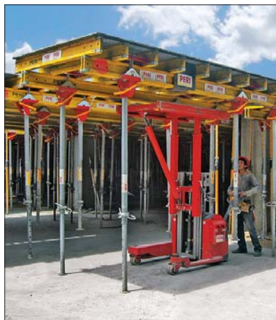
Fot. 5 | Optymalnie dobrane stoły stropowe przemieszczane w obrębie jednej kondygnacji za pomocą wózka transportowego
