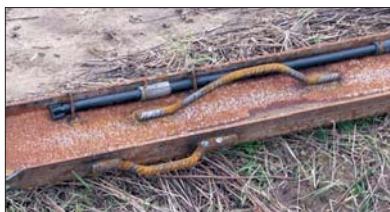
Fot. 3 | Dolna część zbrojenia pala z rurką iniekcyjną
