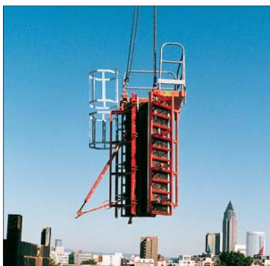
Fot. 4 | Deskowanie słupów, przemieszczane jednym ruchem żurawia, znacznie redukuje nakłady robocze związane z ich obsługą
