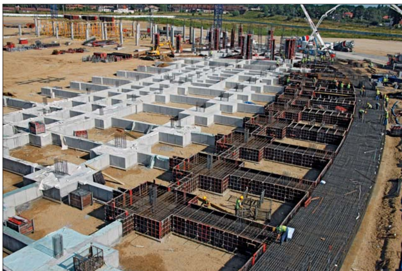
Fot. 2 | Lekkie, ręcznie przestawiane deskowania ramowe zapewniają optymalną realizację łąw i fundamentów o skomplikowanych kształtach
