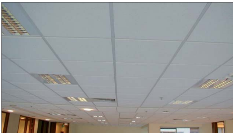
Fot. 5 | Odchylenie osi listew od linii prostej
