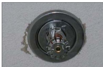
Fot. 7 | Niedokładne wycięcie otworów w połączeniach sufitowych
