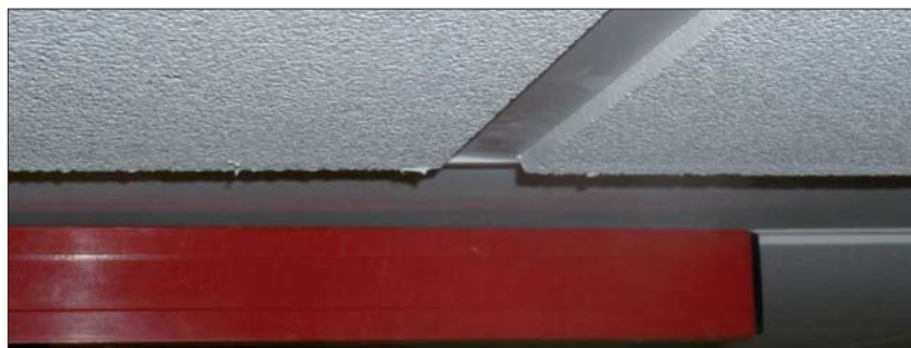
Fot. 8 | Odchylenia od poziomu płaszczyzny sufitów podwieszanych
