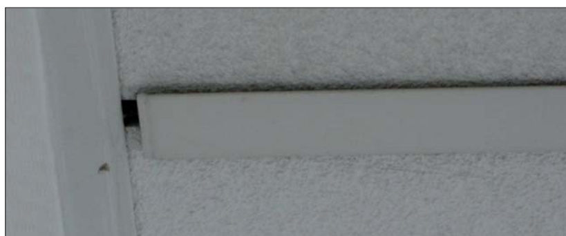
Fot. 2 | Niedokładne cięcie listew sufitowych
