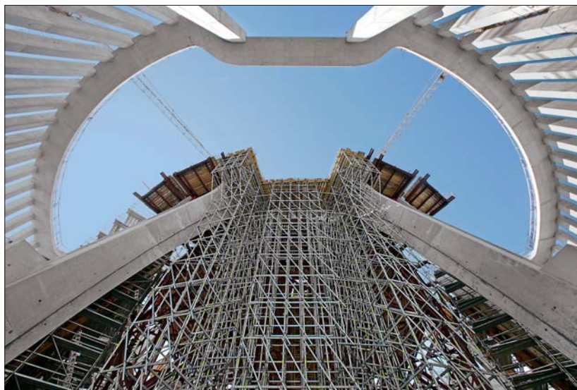
Fot. 1 | Faza realizacyjna elementów żelbetowych konstrukcji Świątyni Opatrzności Bożej w Warszawie
