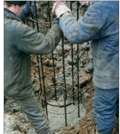
Fot. 2 | Pograżanie zbrojenia
