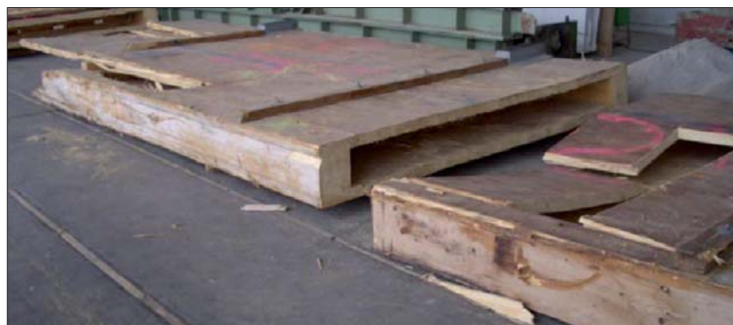
Fot. 4 | Fragmenty dźwigarów o przekroju skrzynkowym po katastrofie poddane ekspertyzie
