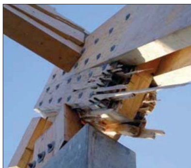
Fot. 3 | Zniszczenie błędnie zaprojektowanego węzła podporowego więzara
