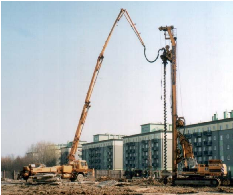
Fot. 1 | Palownica ze świdrem ciągłym
