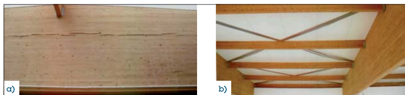
Fot. 1 | Przykładowe uszkodzenie dachu z drewnianych dźwigarów dwutrapezowych: a) spękania dźwigarów, b) niewłaściwe stężenie dźwigarów
