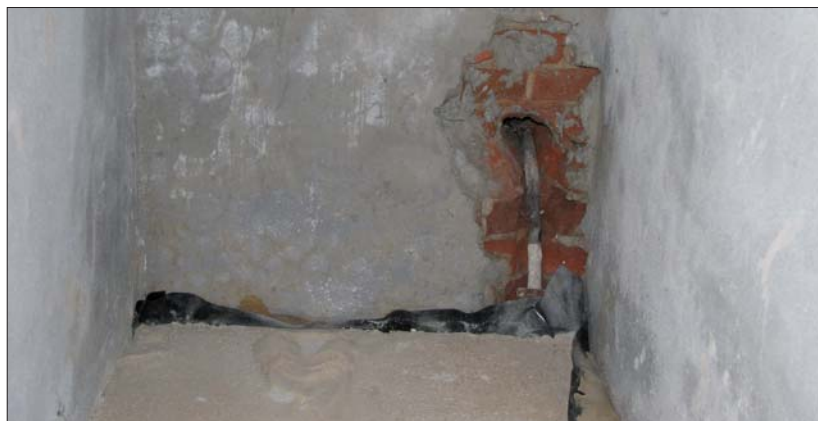
Fot. 1 | Skutek stosowania niekompatybilnych ze sobą materiałów do wykonania powłok wodochronnych
