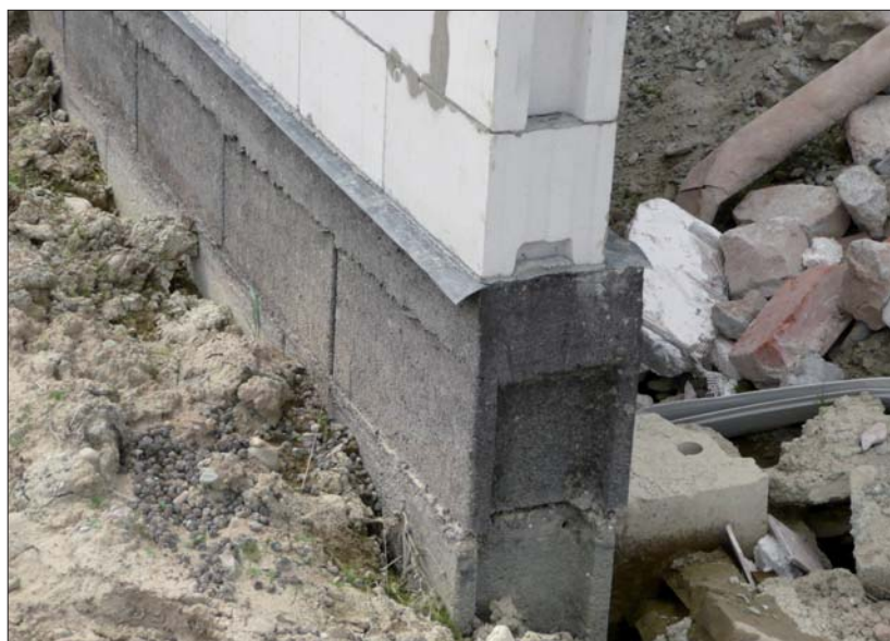
Fot. 3 | Izolacja przeciwwilgociowa z emulsji/roztworów bitumicznych wymaga otynkowanego podłoża
