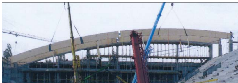
Fot. 5 | Niewłaściwy montaż dźwigarów na dwa dźwigi
