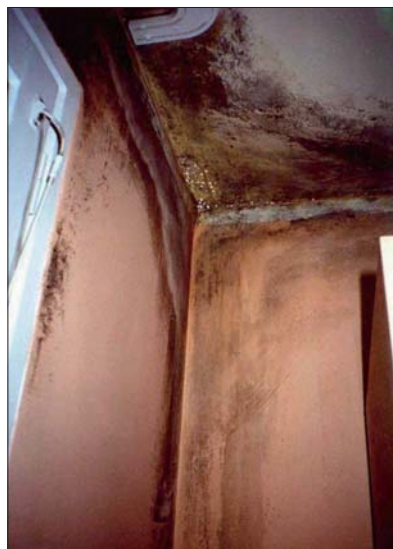
Fot. | Kondensacja pary wodnej i rozwój pleśni na wewnętrznych powierzchniach wadliwie ocieplonego narożnika
