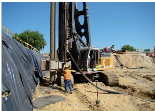
Fot. 1 | Wykonywanie kolumn VDC
