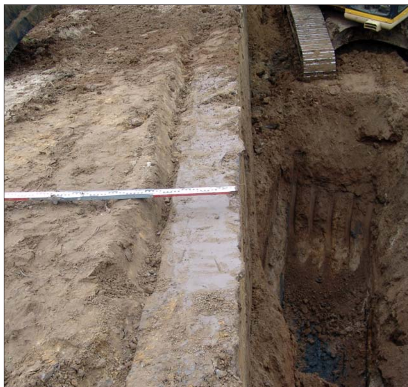
Odkrywki wykonanej przesłony
