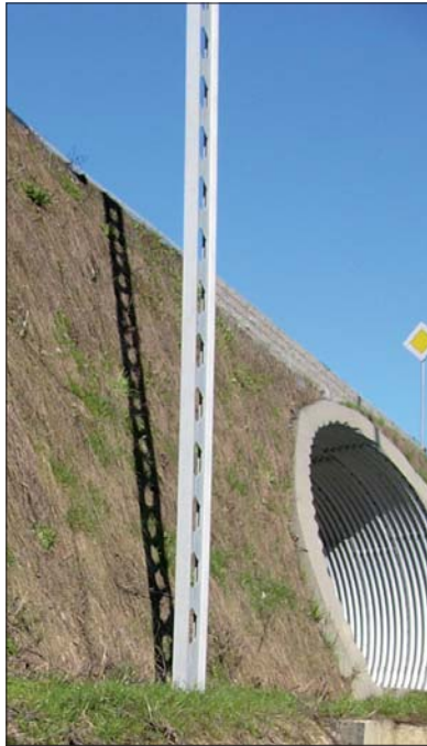
Fot. 3 | Stroma skarpa nasypu drogowego zbrojona geotkaniną poliestrową
