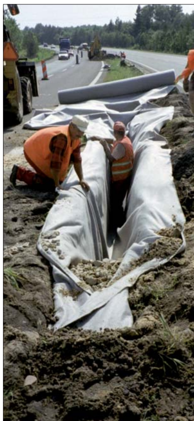
Fot. 2 | Wykonanie drenażu kamiennego w otocze z geowłókniny w pasie rozdzielnym drogi krajowej
