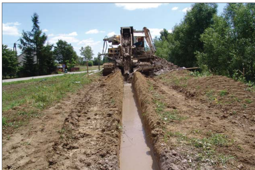
Trencher wykonujący przesłone
