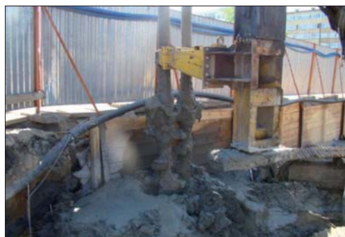
Fot. 4 | Wykonywanie palisady DSM przy zastosowaniu podwójnego mieszadła
