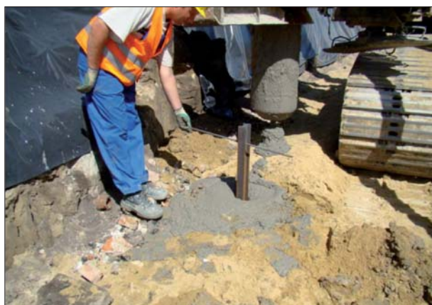
Fot. 2 | Umieszczenie profili stalowych w kolumnie VDC
