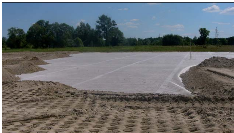
Fot. 5 | Zbrojenie podstawy nasypu drogi dojazdowej do mostu geosiatką poliestrową
