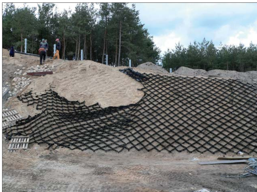
Fot. 1 | Przykład zabezpieczenia skarpy przed erozją powierzchniową materiałami geosyntetycznymi
