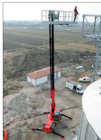
Fot. 2 | Ładowarka teleskopowa obrotowa
