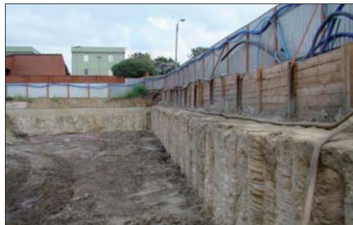
Fot. 3 | Widok wykonanej palisady zbrojonej DSM (na pierwszym planie) i ściany szczelinowej (w głębi)
