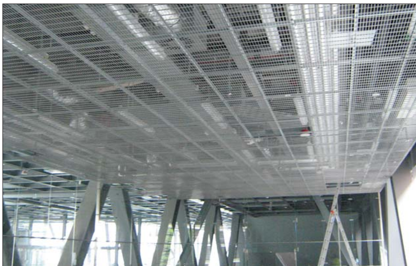
Fot. 3 | Instalacje wewnątrz konstrukcji stropu
