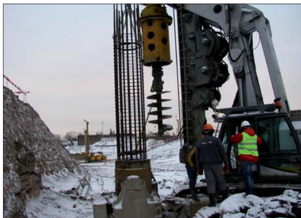
Fot. 2 | Maszyna ze świdrem spiralnym w trakcie wkładania zbrojenia
