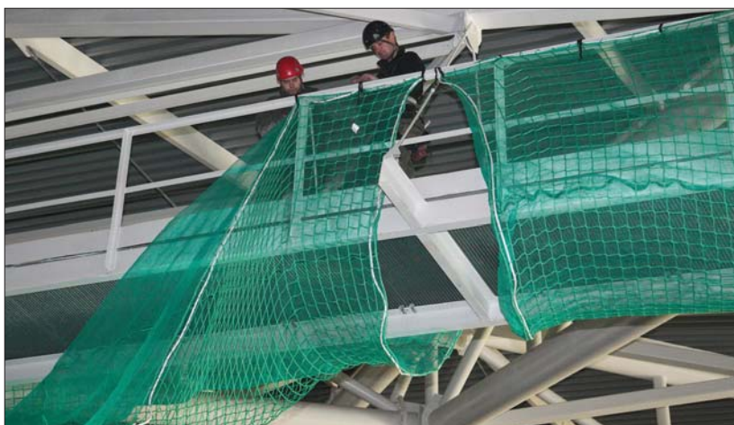
Fot. 3 | Budowa hali Arena Łódź (archiwum Huck Polska)
