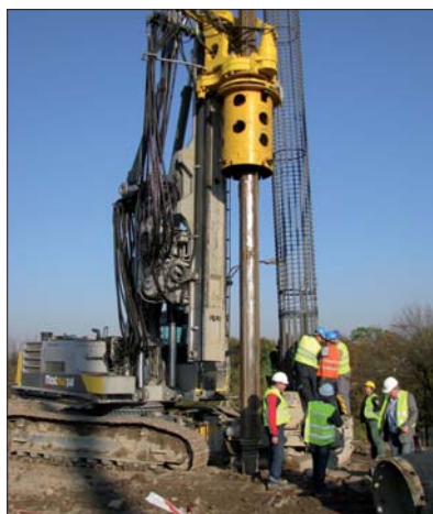
Fot. 3 | Widok maszyny w trakcie wkładania bardzo długiego zbrojenia łączonego z dwóch części
