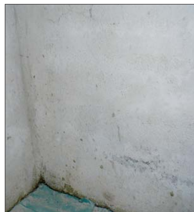
Fot. 3 | Mur po osuszeniu preparatem HERMON
