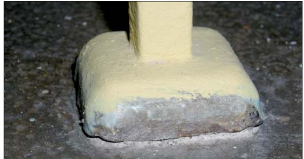
Fot. 3 | Niemalowane elementy, zabrudzenie farbą powierzchni przylegających
