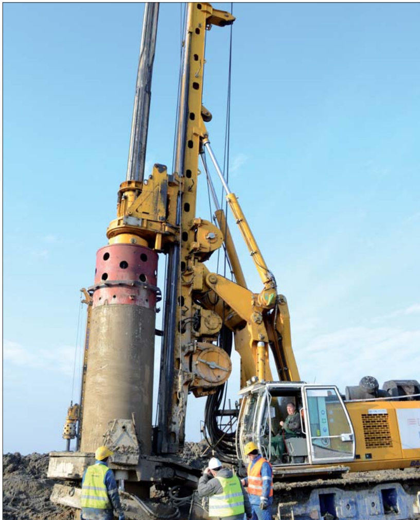
Fot. 1 | Palownica z rurą osłonową i urządzeniem rurującym
