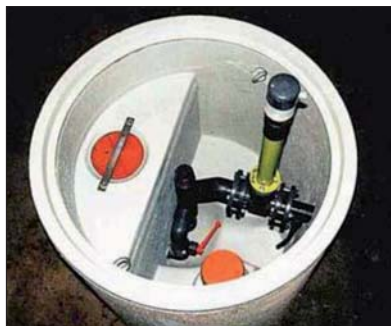
Fot. 2 | Studzienka systemu Schluffa
