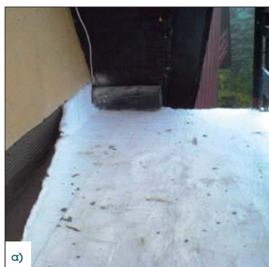
Fot. 3 | Izolacja z wykorzystaniem maty Spaceloft: a) płyty balkonowej, b) lukarny (fot. D. Krakowski – Aerogels Poland)
