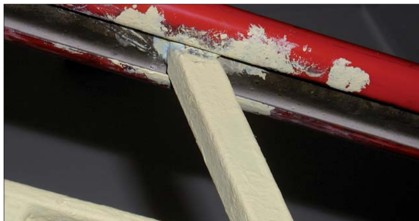
Fot. 2 | Nierzetelne wykonanie robót – zabrudzenie farbami powierzchni przylegających, nieodpowiednie przygotowanie podłoża
