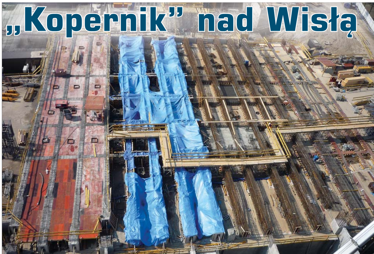
Fot. 1 | Platforma żelbetowa w trakcie montażu
