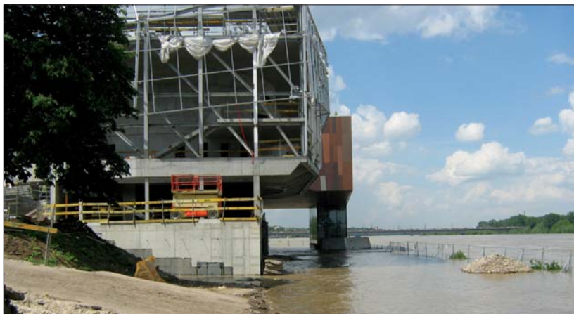
Fot. 4 | „Kopernik” w czasie fali kulminacyjnej powodzi przechodzącej w maju 2010 r.
