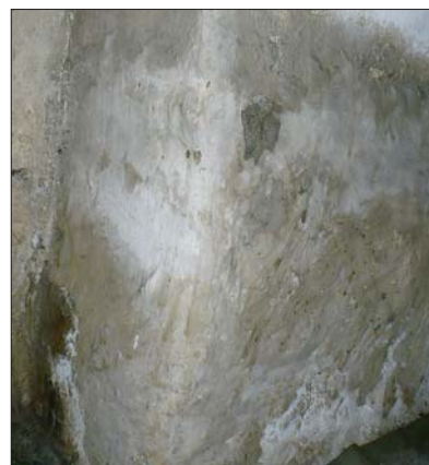
Fot. 1 | Mur mokry, przed rozpoczęciem procesu osuszania
