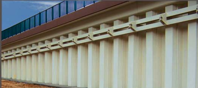
Fot. 3 | Niemalowane elementy, zabrudzenie farbą powierzchni przylegających
