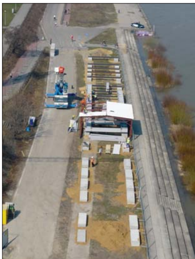
Fot. 2 | Scalanie kratownic w warsztacie polowym
