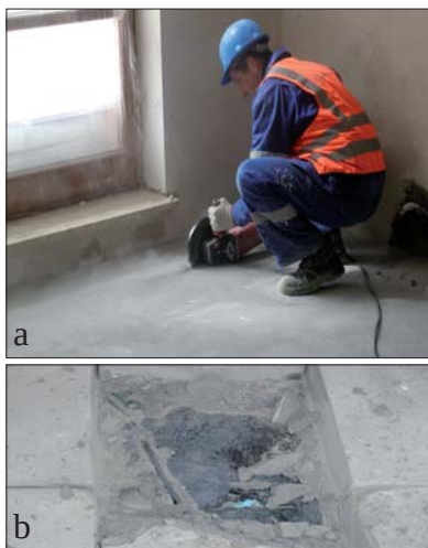
Fot. 2 | Pobranie próbek podkładu w celu zbadania wytrzymałości na ściskanie i zginanie: a) wycinanie; b) widok podkładu po pobraniu próbek
