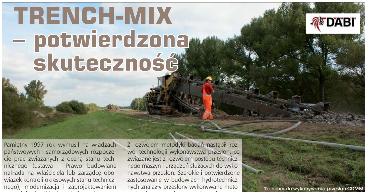
Trencher do wykonywania przesłon CDMM
