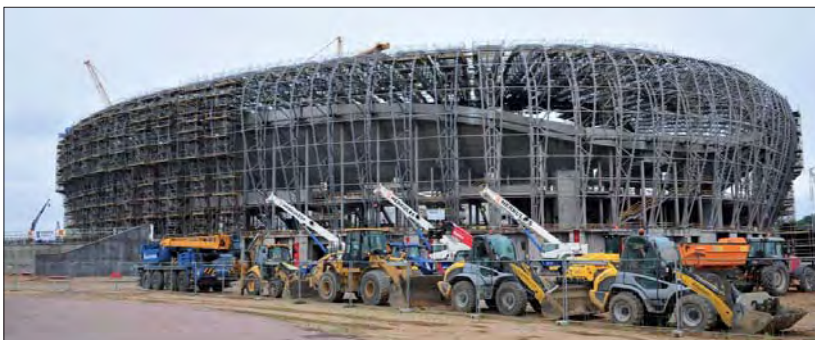
Fot. 2 | PGE Arena Gdańsk
