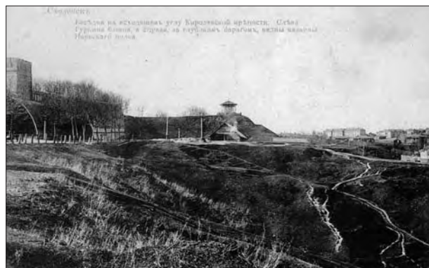
Fot. 2 | Bastion nr 5 na zdjęciu z 1912 r. Widoczny przylegający mur i parów Czuryłówki
