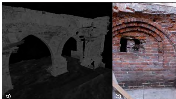
Fot. 2 | a) Gdańskie piwnice widziane okiem skanera laserowego – fragment chmury punktów w skali szarości b) Tradycyjny widok na odkryte w Gdańsku romańskie piwnice Skanowanie laserowe przeprowadzone pod okiem archeologów bez ingerencji w trudno dostępny obiekt zabytkowy
