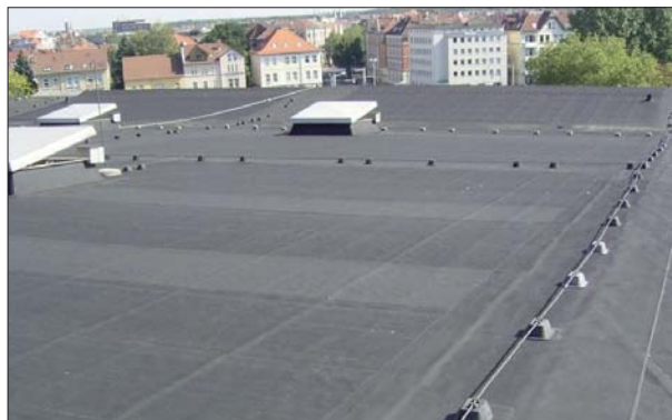
Fot. 2 | Hydroizolacja przeciwkorozenna EPDM Phoenix (archiwum firmy Phoenix)
