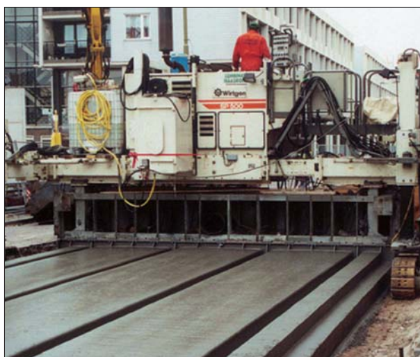
Fot. 1 | Układanie rozścielaczem płyty żelbetowej dla nawierzchni bezpodsypkowej typu ERS [8]. Szyny układane są w widocznych kanałach na elastycznej podkładce i w tłumiącej drgania elastycznej otulinie. Szyna ma ciągłe podparcie i nie wymaga żadnego systemu zamocowania do płyty
