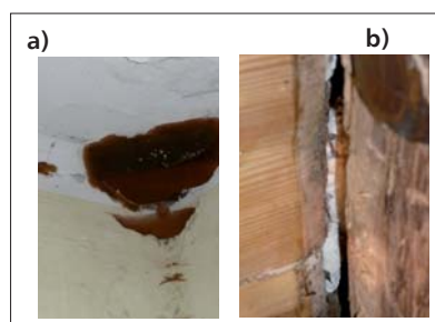
Fot. 2 | a) Wykształcony owocnik grzyba domowego właściwego. b) Młody owocnik grzyba domowego właściwego rozwijający się w szczelinie w zawilgoconej drewnianej ścianie
