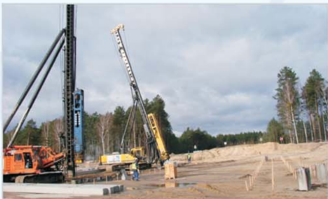
Autostrada A2, Świecko - Nowy Tomyśl
