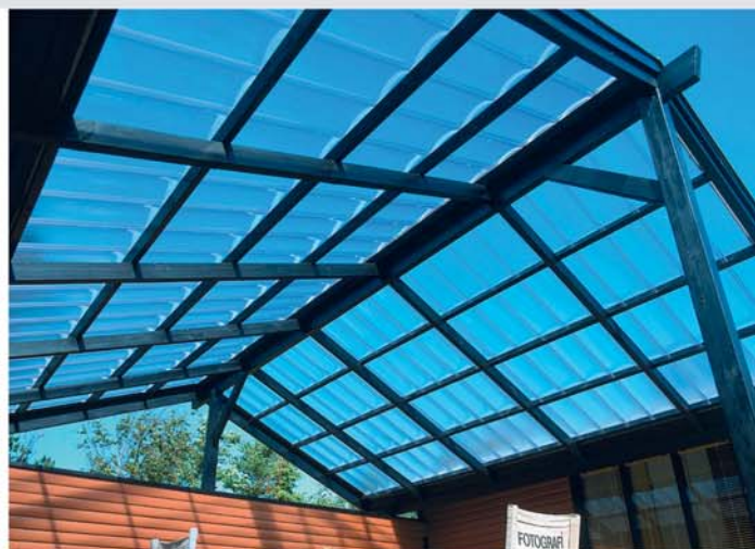
Zadaszenie altany ogrodowej – projekt i konstrukcja inwestora
