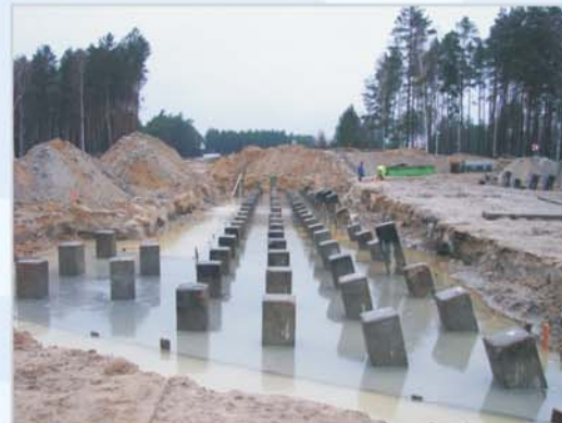
Autostrada A2, Świecko - Nowy Tomyśl
