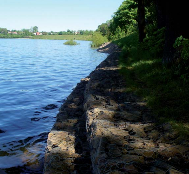
Fot. 4 | Zabezpieczenie brzegu zbiornika przed abrazją
