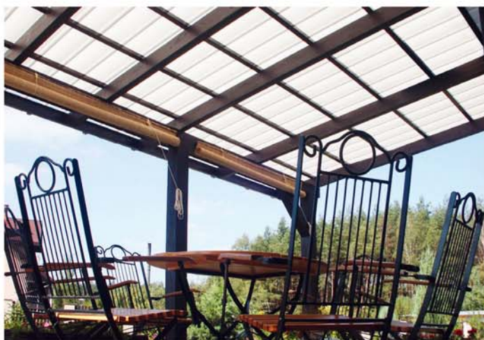
Zadaszenie tarasu – projekt i konstrukcja inwestora
