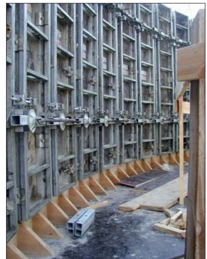
Szalowanie ścian okrągłych
