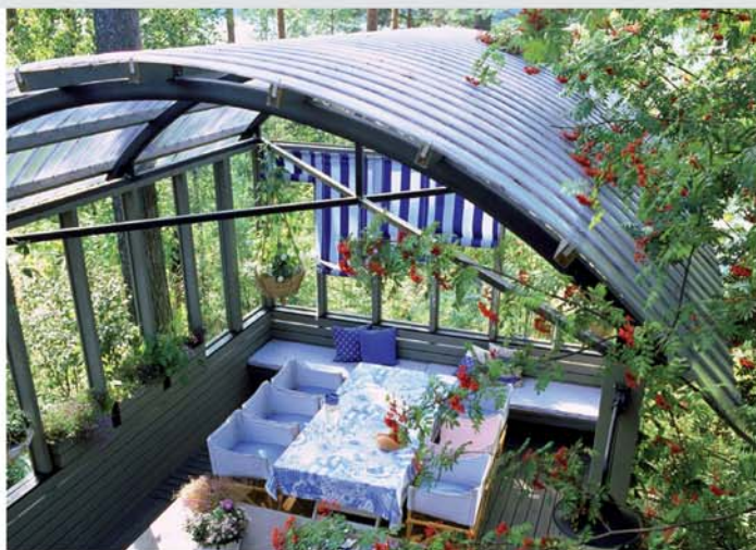
Zadaszenie altany ogrodowej – projekt i konstrukcja inwestora
