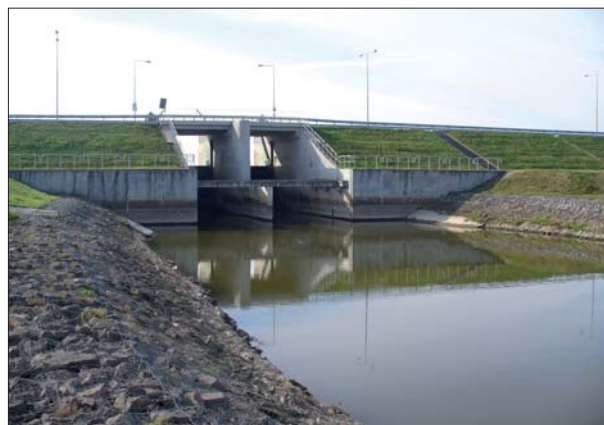
Fot. 2 | Jaz zapory czołowej zbiornika głównego – widok od strony wody dolnej
