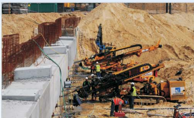
S8 - Węzeł Konotopa - kotwienie ściany szczelinowej
