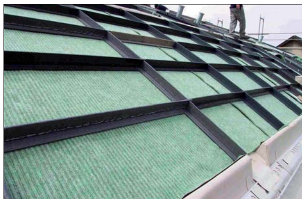
Fot. 4 | Progi systemowe zabezpieczające przed osuwaniem substratu (archiwum firmy Optigruen)
