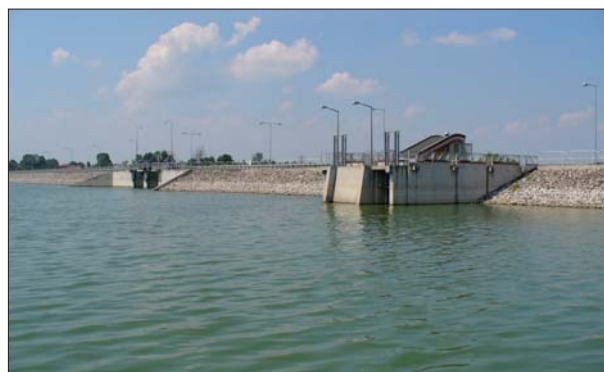
Fot. 1 | Zapora czołowa zbiornika głównego
