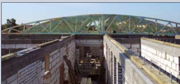
Fot. 3 | Konstrukcja z więzarów pod dach łukowy (Fot. Archiwum firmy Wiązary Burkietowicz)
