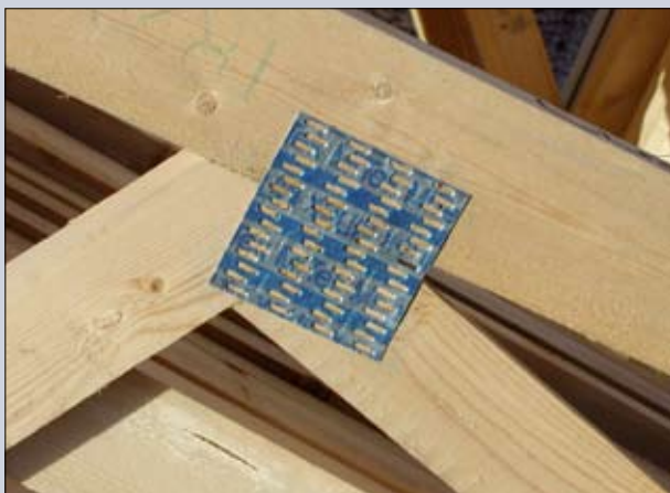
Fot. 4 | Płytki kolczaste
