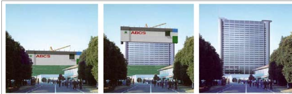
Fot. | Kolejne fazy wznoszenia budynku przy wykorzystaniu systemu ABCS [5]
