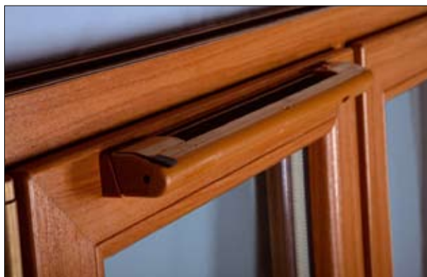
Fot. 2 | Nawiewnik zamontowany na oknie
