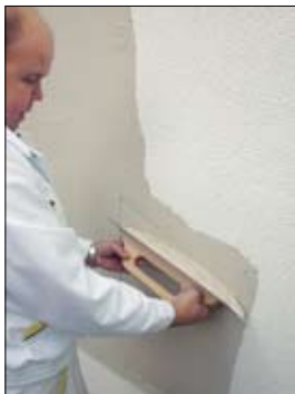
Nanoszenie modyfikowanej organicznie, zbrojonej włóknem zaprawy szpachlowej jest proste: nałożenie materiału, zatopienie siatki, wygładzenie
