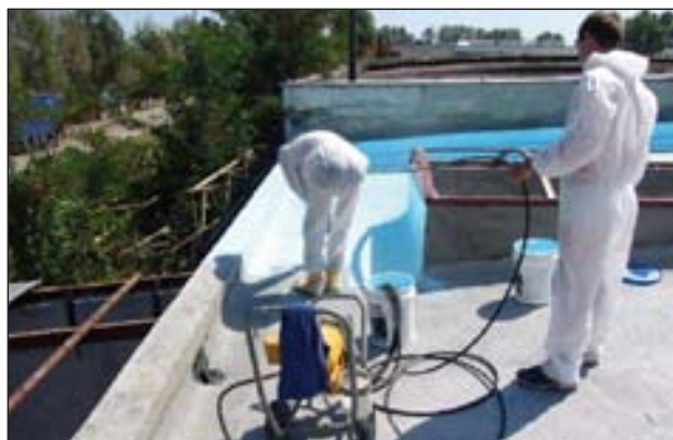
Fot. 1 | Wykonywanie pokrycia z multigumu (archiwum firmy Bitum)
