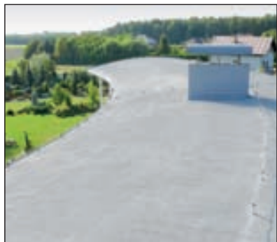
Fot. 2 | Nylon dekarski na dachu budynku mieszkalnego (archiwum firmy Dachermann Polska)
