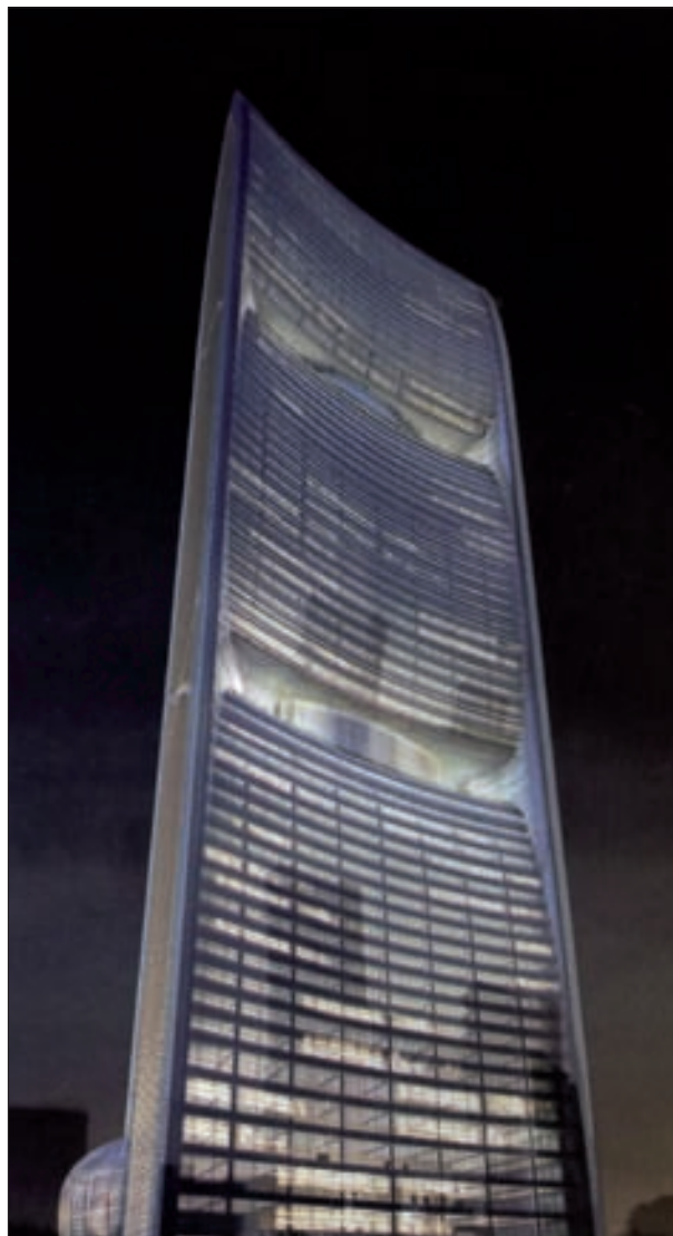
Podwójna przeszklona fasada budynku Pearl River Toner, Guangzhou, Chiny (wysokość 300 m) [1]
