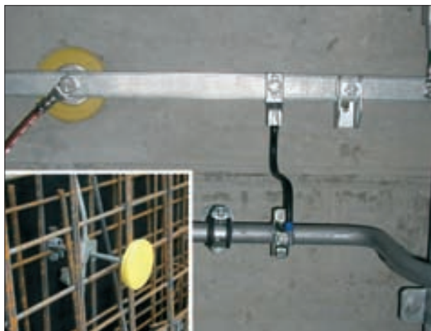
Fot. 4 | Wykonanie punktu umożliwiającego proste połączenie instalacji wyrównawczej z konstrukcją obiektu
