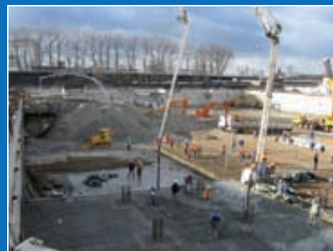
Fot. 1: Uszczelnienie płyty dennej ok. 20 tys. m 2 ; wokół widoczne ściany szkieletowe.
