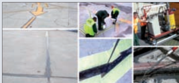
Fot. | Naprawiona przez konsorcjum PK-NTB betonowa płyta na wjeździe do portu Kraków-Balice przy użyciu polimerowego złącza podatnego oraz aplikacja polimeru w sposób ręczny i maszynowy
