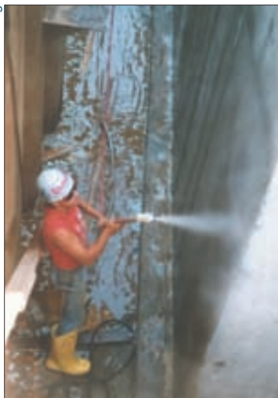
Fot. 2 | Natryskowe nakładanie krystalicznej zaprawy uszczelniającej
