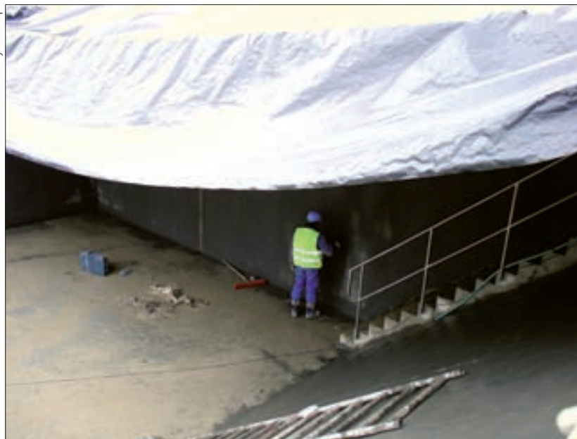
Nakładanie krystalicznej zaprawy uszczelniającej na ściany
