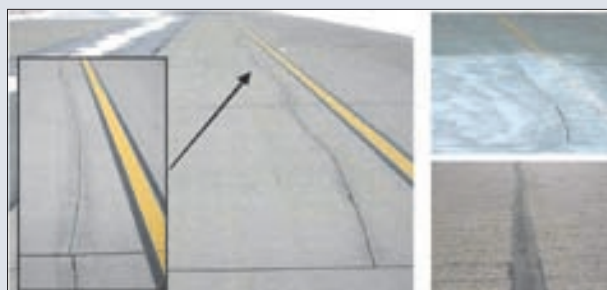
Rys. 6 | Naprawa betonowej nawierzchni drogi kołowania przy użyciu polimerowego złącza podatnego
