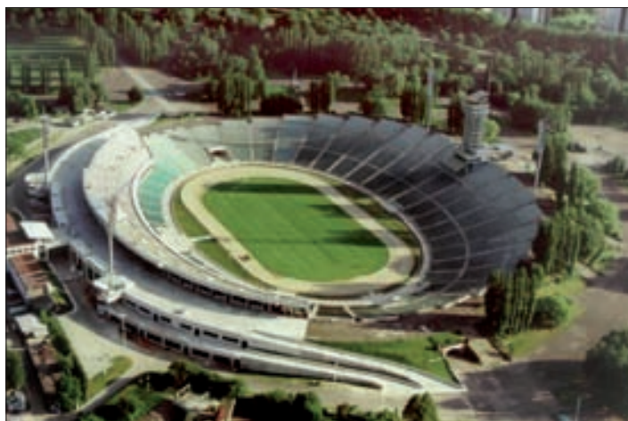
Fot. 1 | Stan zrealizowanych prac projektowych w ramach modernizacji Stadionu Śląskiego (2007 r.). Fot. T. Najdzien, archiwum ZPiW-TB
