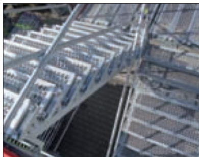
Fot. 3 | Klatka schodowa: belki nośne schodów, pomosty, stężenia jako poręcze
