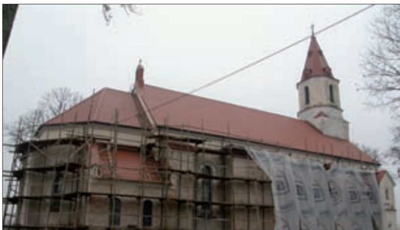
Fot. 1 | Podczas prac w zabytkowym kościele pw. św. Jana Apostoła i Ewangelisty w Knyszynie odkryto wiele przemurowań. Pokazały one, że budynek ma mniejsze okna, niż były wcześniej (fot. S. Rutkowski)
