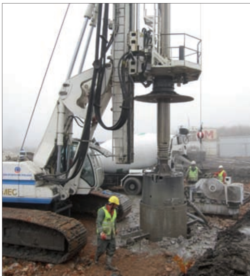
Głębienie pali wielkośrednicowych pod zawieszoną bentonitową
