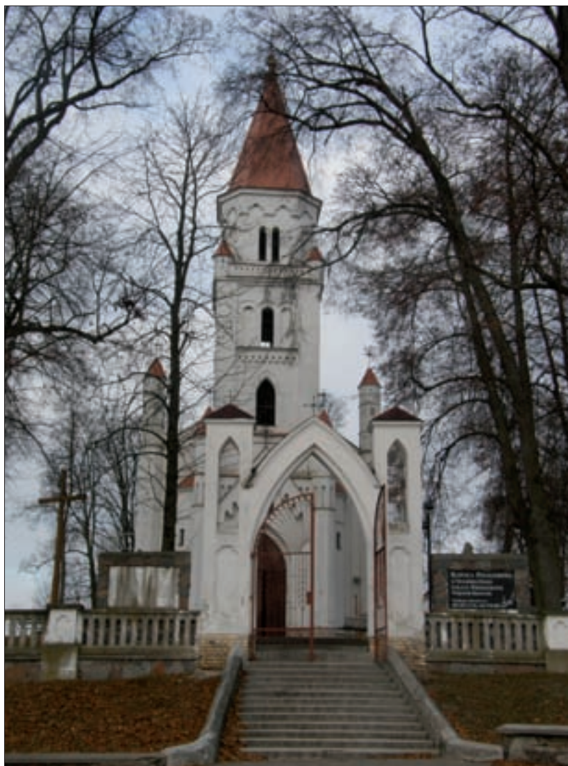
Fot. 2 | W kościele pw. św. Antoniego Padewskiego w Niewodnicy Kościelnej obecnie trwają prace budowlane. W tym roku zabytkowy obiekt będzie mógł pochwalić się nową elewacją (fot. B. Klem)
