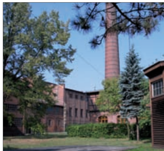
Fot. 1 i 2 | Widok stacji „Zawada”; komin ma ok. 50 m wysokości;
