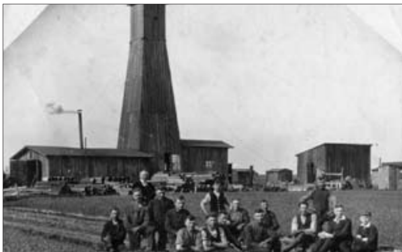
Fot. 3 | Pracownicy przy odwiercie, 1928 r.
