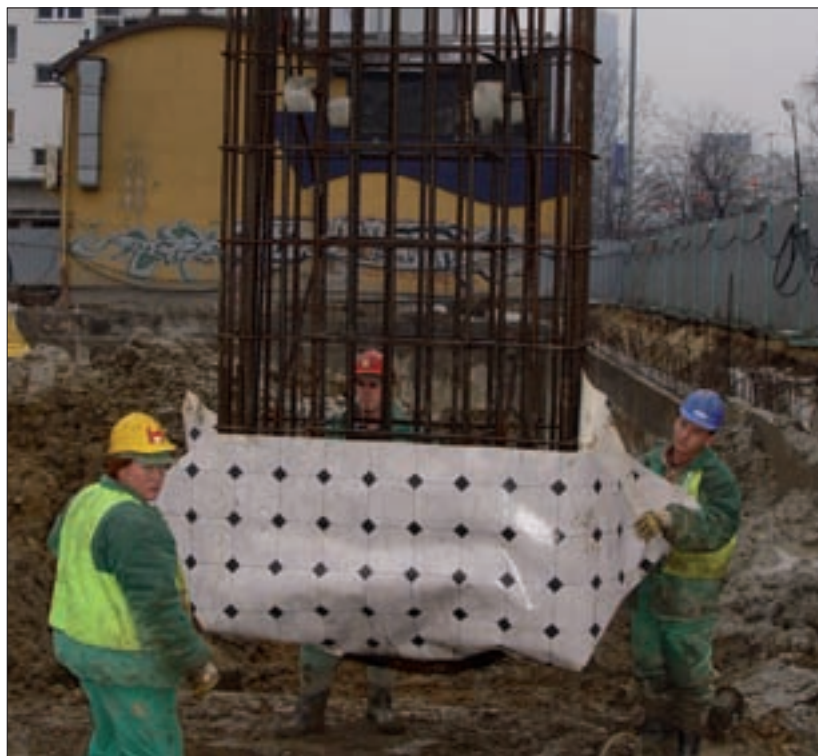
Fot. 3 | Widok instalacji iniekccyjnej do naprężania podstawy baret 80 x 250 cm (fot. P. Rychlewski)
