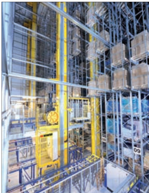
Fot. 1 | Układnica z regałami wysokiego składowania
