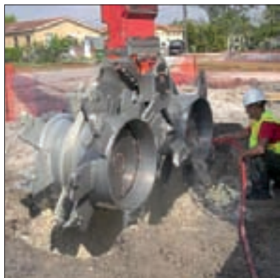
Fot. 1 | Narzędzie robocze w systemie CSM Soletanche-Bachy (Mathieu, Borel 2006) [14]
