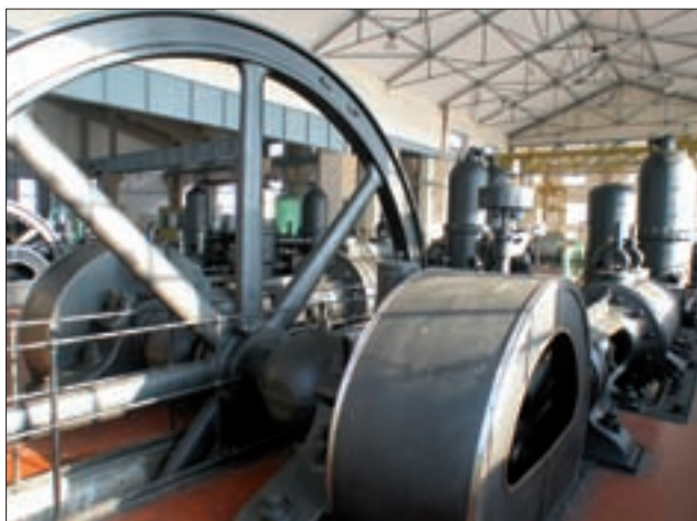
Fot. 4 | Hala pomp, widoczne pompy tłokowe
