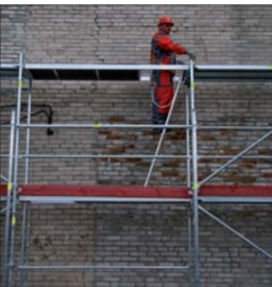
Fot. 2 | Pomost przejściowy
