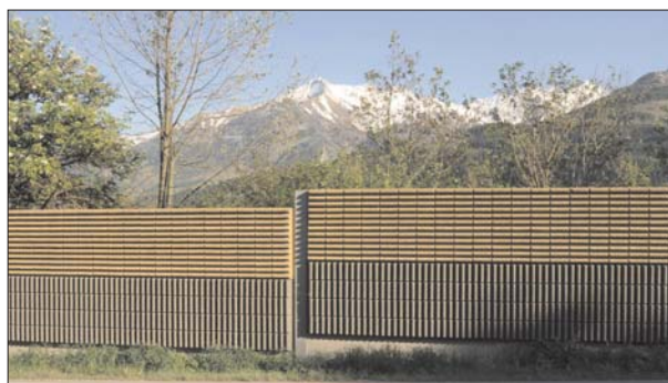
Fot. 8 | Ekran akustyczny idealnie wkomponowany w górski krajobraz na lokalnej drodze w Austrii (fot. autor)
