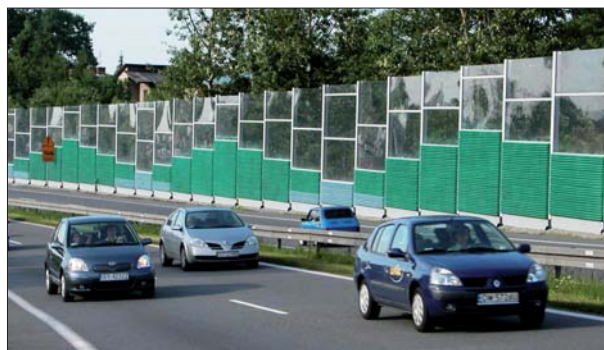
Fot. 9 | Połączenie ekranów pochłaniających i odbijających (przezroczystych) DE S1 (fot. Techbud Kraków)
