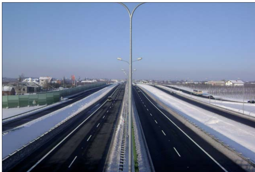
Fot. 2 | Widok z wiaduktu WD-2 w kierunku Grójca – ruch dwoma jezdniami; grudzień 2009 r.
