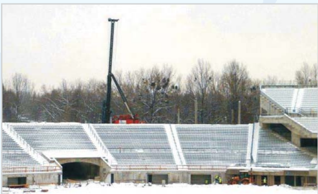
Stadion Śląski - Chorzów - pale pod konstrukcję trybun
