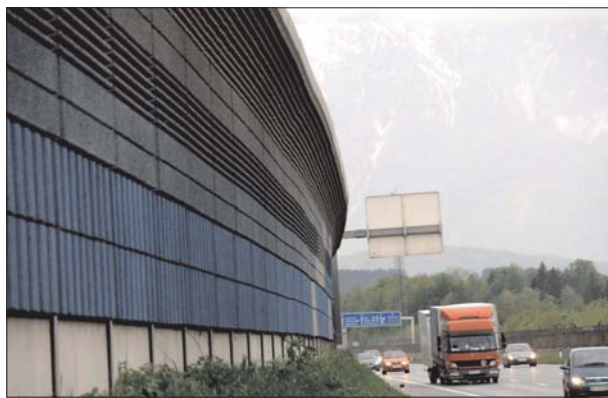
Fot. 4 | Wysoki na 8,5 metra, po części łukowy, pomalowany ciemnymi kolorami ekran stwarza przytłaczające wrażenie, autostrada A1, Salzburg, Austria (fot. autor)
