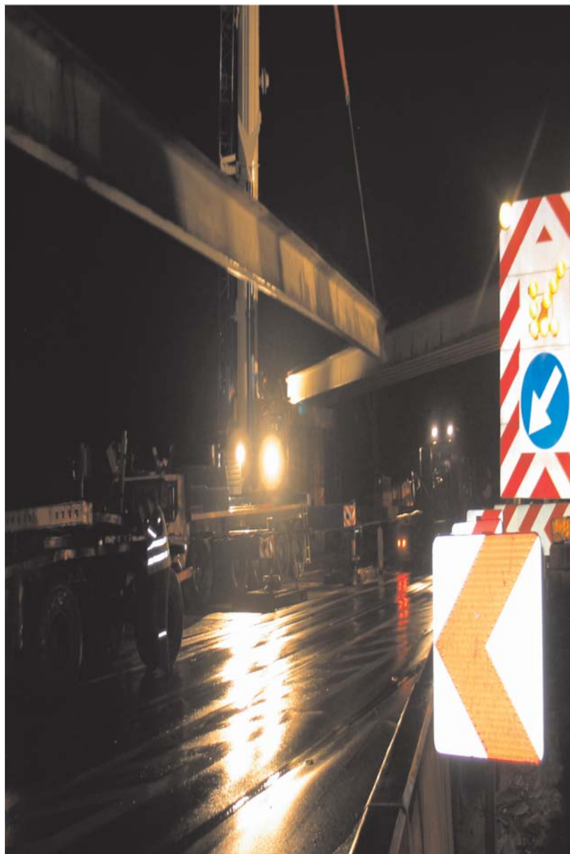
Fot. 1 | Montaż belek – wiadukt WD12
