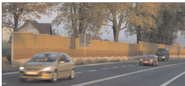
Fot. 1 | Przykład pionowego przejścia tonalnego kolorów, ekrany akustyczne na DK 4 (fot. Techbud Kraków)
