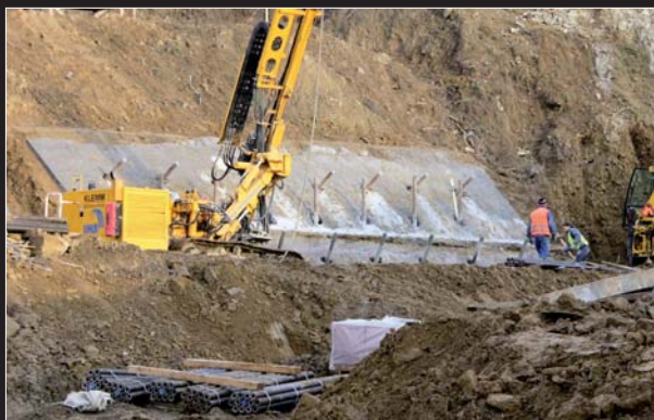
Fot. 2 | Fundament dźwigaru łukowego w trakcie wykonywania mikropali; fot. A. Kulawik
