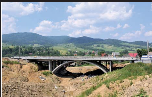
Fot. 3 | Most łukowy w ciągu DE S7 Kraków – Rabka, Lubień; z fundamentami mikropalowymi; fot. arch. TITAN POLSKA
