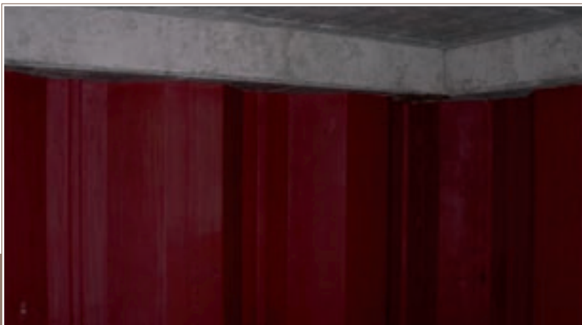
Fot. 3 | Oczyszczona i zabezpieczona przeciwnikorozyjnie ściana garażu podziemnego, w górnej części widoczny oczepek płyty stropowej
