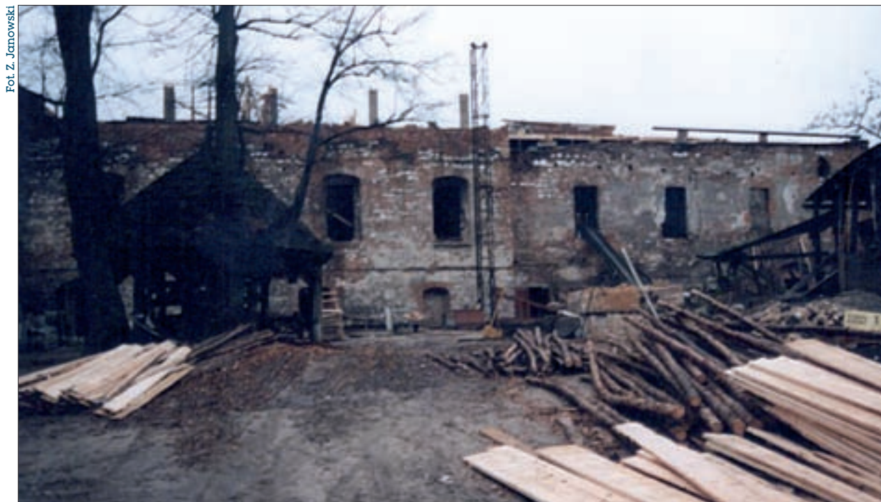
Fot. 1 | Widok ściany północnej z odbudowaną koroną
