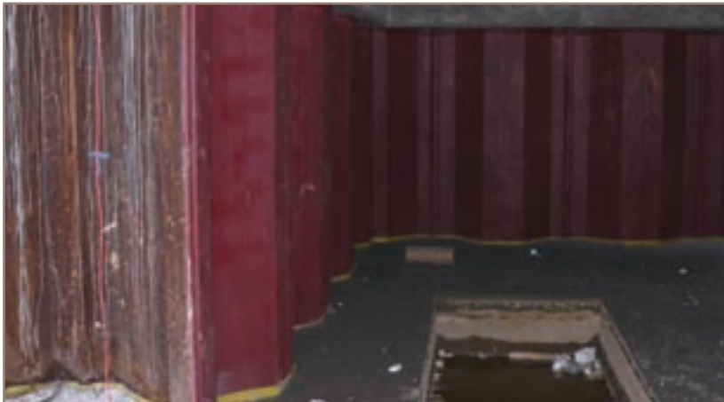
Fot. 2 | Widok na część wjazdową do hali garażowej, po lewej stronie widoczny zarys rampy zjazdowej z nieoczyszczoną ścianką szczelną
