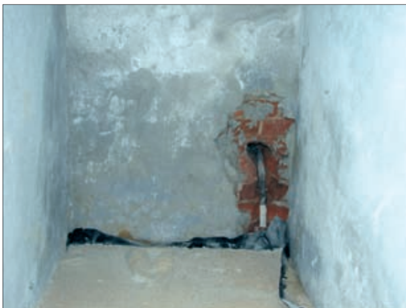
Fot. 1 | Zastosowane materiały hydroizolacyjne powinny pozwolić na wykonanie szczelnych połączeń izolacji pionowej z izolacją poziomą ław fundamentowych oraz izolacją podposadzkową, jak również na uszczelnienie przejść rurowych, dylatacji itp. Rezultat stosowania niekompatybilnych ze sobą materiałów hydroizolacyjnych oraz podstawowych błędów w sztuce budowlanej
