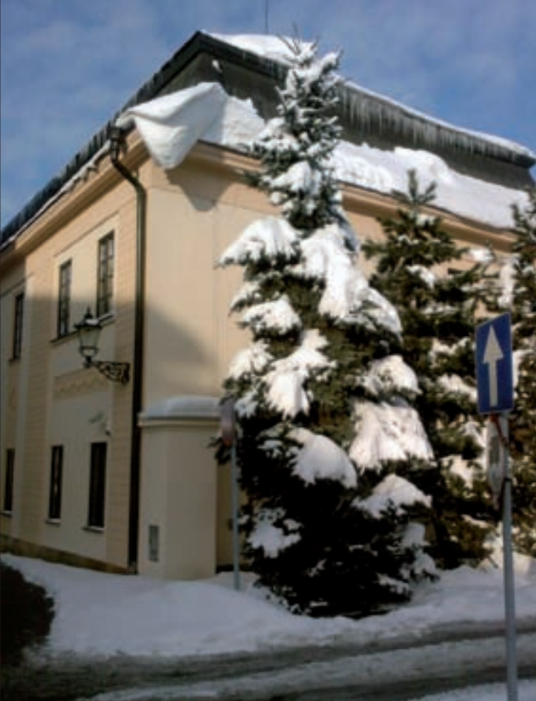
Zimą eksploatacja budynku wiąże się ze zwracaniem szczególnej uwagi na śnieg zalegający na dachu; fot. W. Kołodziejczyk
