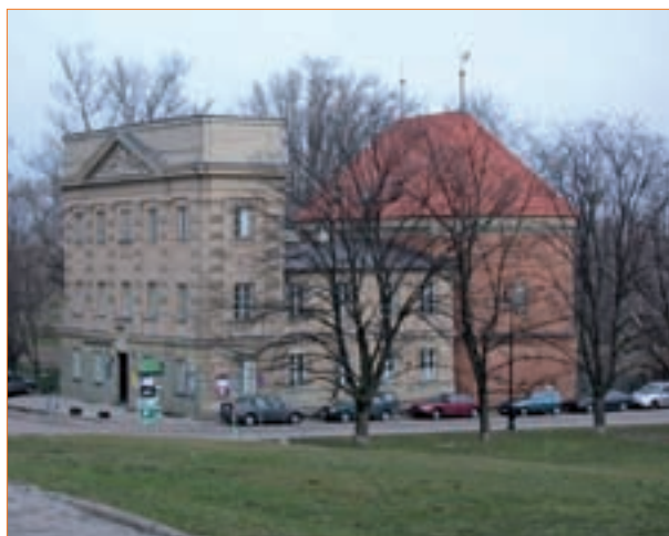
Brama mostowa, wybudowana w 1582 r. na polecenie królowej Anny Jagiellonki, służyła do ochrony mostu, szczególnie przed pożarem. W XVII w. przebudowana na prochownię, a następnie na więzienie. Później dobudowano do bramy Dom Poprawy. Po uszkodzeniach wojennych w latach 1961–1967 bramę odbudowano (Fot. Wikipedia)
