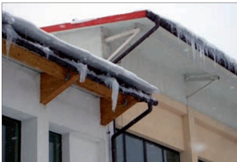
Nowe dachy sali gimnastycznej i basenu; fot. W. Kołodziejczyk
