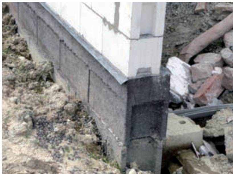
Fot. 2 | Powłoki hydroizolacyjne z roztworów lub emulsji bitumicznych wymagają wcześniejszego otynkowania podłoża z elementów drobnowymiarowych
