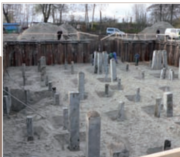
Fot. 1 | Widok na nieckę wykopu, widoczna ścianka szczelna oraz nierozkute głowice pali prefabrykowanego fundamentu
