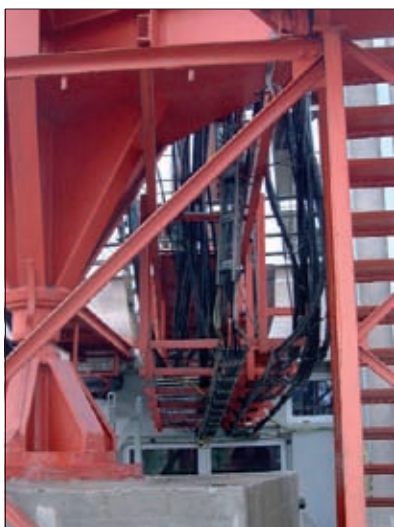
Fot. 9 | Posadowienie masztu
