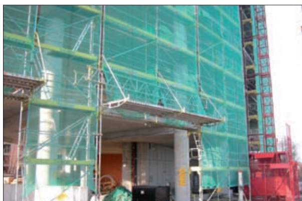
Fot. 4 | Siatki na rusztowaniach
