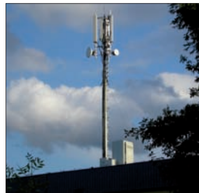
Fot. 4 | Stacja GSM na budynku
