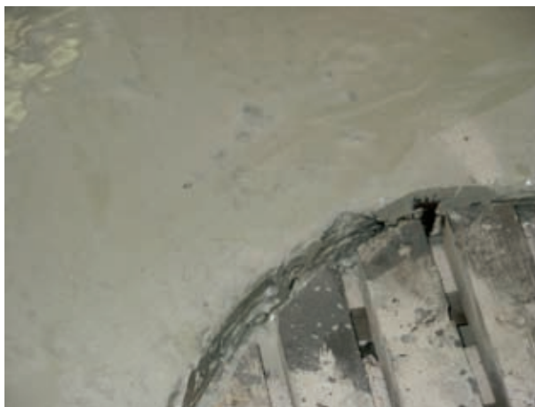
Fot. 3 | Złe obrobienie wpustu
