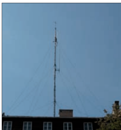
Fot. 1 | Stacja VHF
