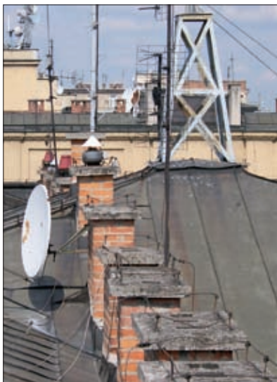
Fot. 8 | Anteny na budynkach
