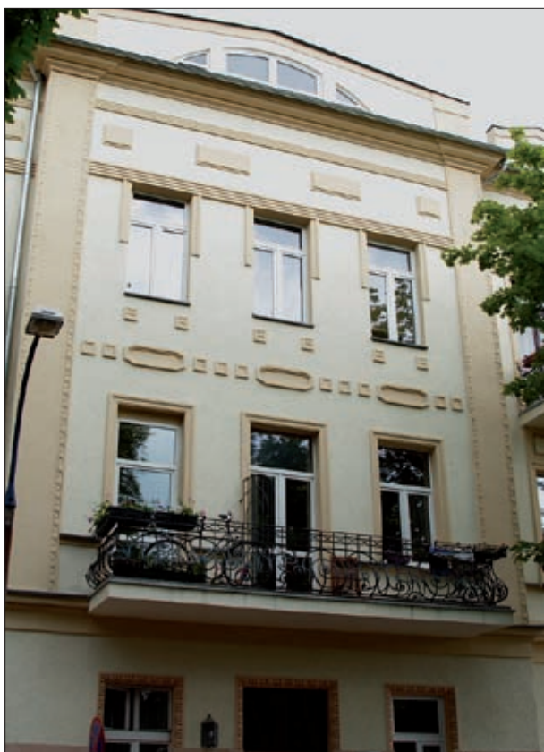
Fot. 4 | Kraków, kamienica przy ul. Józefińskiej
