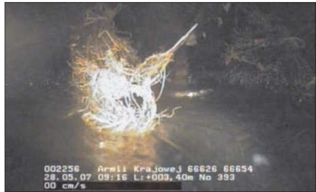
Fot. 2 | Przykład uszkodzenia – korzenie
