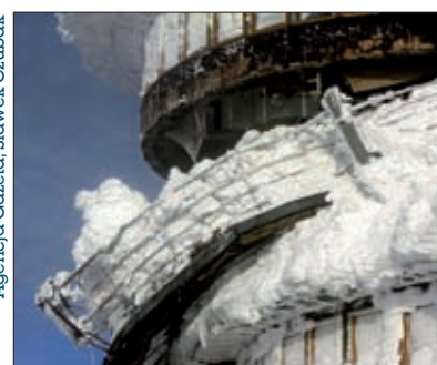
Fot. 5 | Zniszczenia jednego z dysków obserwacyjnych IMGW na Śnieżce, marzec br.
