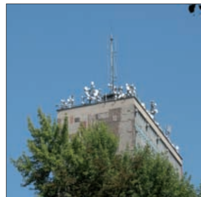
Fot. 7 | Anteny CLR na budynku
