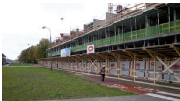
Fot. 2 | Zadaszenie drogi komunikacyjnej
