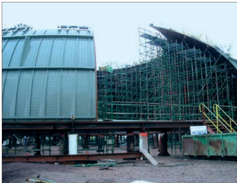
Fot. 2 | Pierwszy etap montażu obrazujący zagęszczenie elementów
