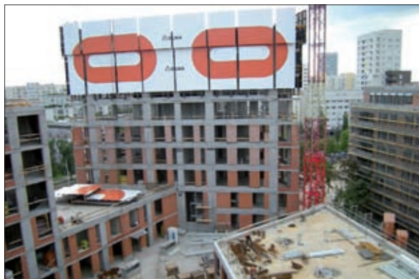
Fot. 3 | Zapory przeciwko nagłym podmuchom wiatru
