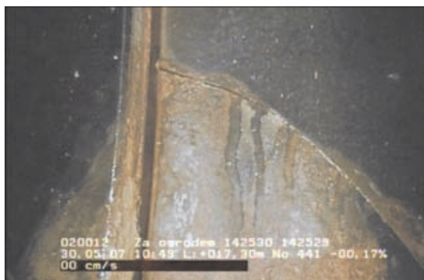
Fot. 3 | Przykład uszkodzenia BAM – uszkodzenie spoiny
