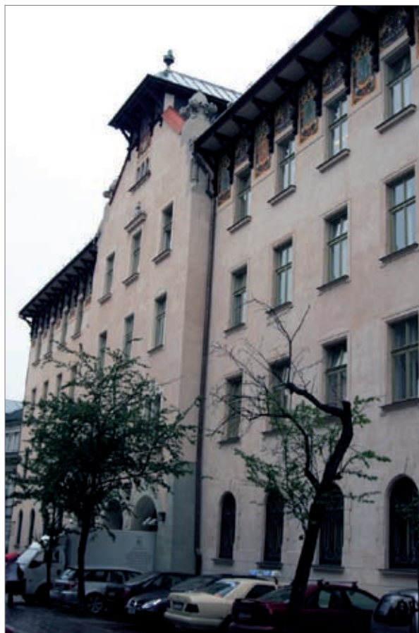
Fot. 5 | Kraków, fasada pałacu Wielopolskich od strony ul. Poselskiej
