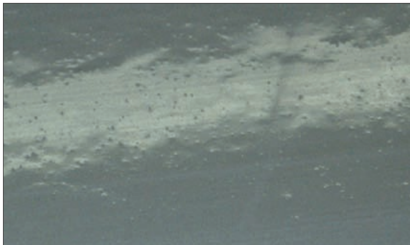
Fot. 2 | Skutki złego odpowietrzenia żywic
