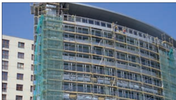
Fot. 1 | Prawidłowy montaż rusztowań
