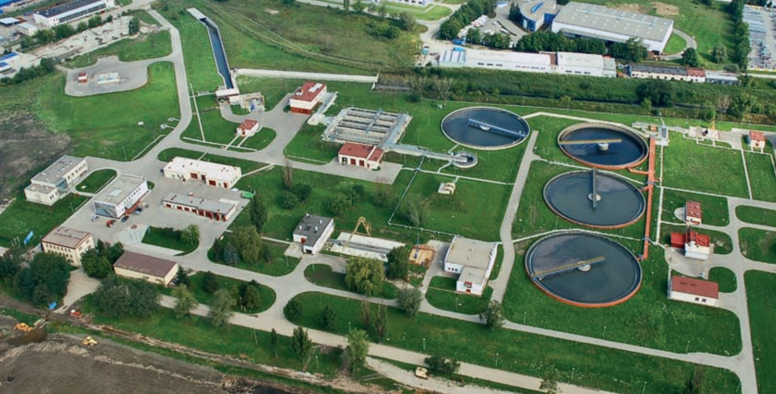
Fot. 1 | Oczyszczalnia Płaszów II – część mechaniczna
