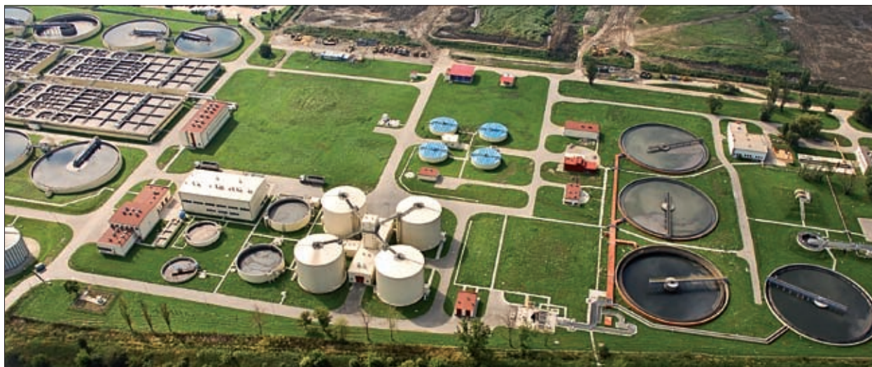
Fot. 3 | Oczyszczalnia – część osadowa
