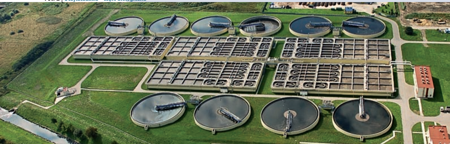
Fot. 2 | Oczyszczalnia – część biologiczna
