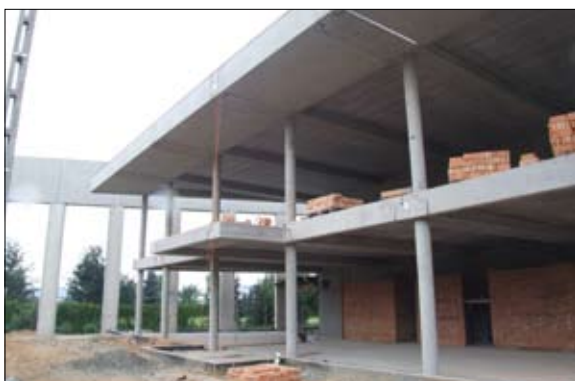
■ Szkielet części biurowej podczas montażu. Widoczne m.in. płyty dachowe o gładkiej powierzchni od spodu.
