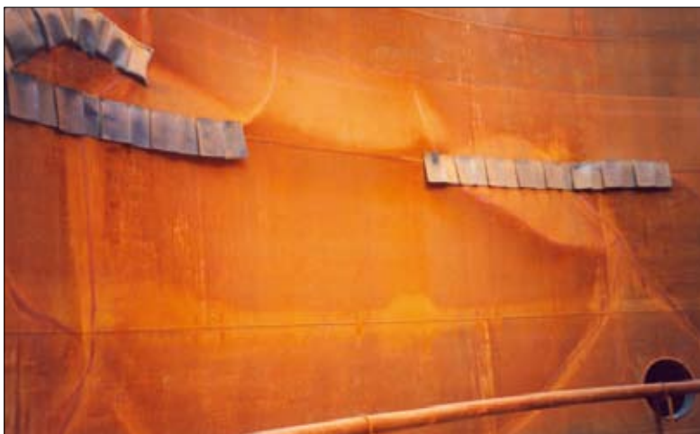
Fot. 5 | Fartuchy gumowe ograniczające wypływ wody na odcinkach przewidywanych pęknięć blach podczas rozciągania hydraulicznego
