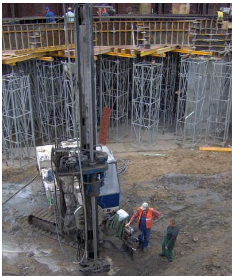
Budowa tunelu pod czynną linią kolejową we Włocławku, konstrukcja trasy tranzytowej al. Królowej Jadwigi. Wzmacnianie słabonośnego podłoża gruntowego palami w technologii jet grouting
