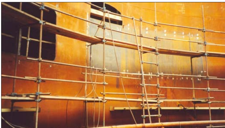
Fot. 6 | Wymiana blach płaszczu w dwupłaszczowym zbiorniku uszkodzonym podczas próby wodnej
