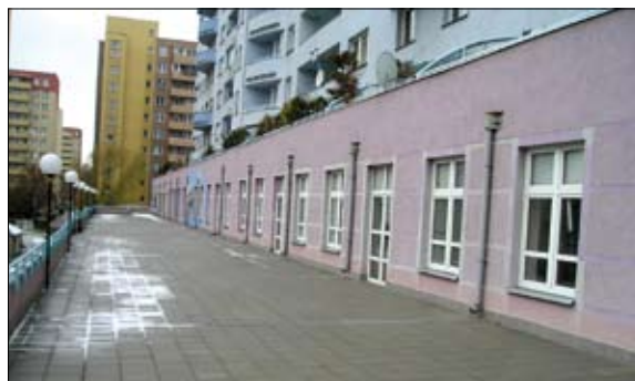
Biura MOIB (widok z tarasu I piętra budynku przy ul. 1 Sierpnia 36 B)
