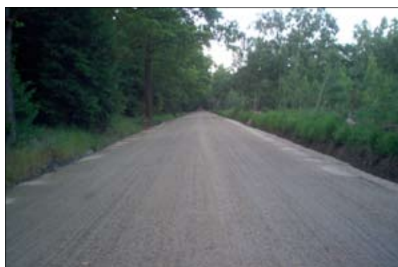
■ Budowa drogi leśnej w Nadleśnictwie Piaski w rejonie Ostrzeszowa. Wykonano podbudowę o grubości 40 cm przy udziale spoiwa Silment CQ-25 w ilości 7–8% do masy gruntu. Wykonawca – Budromos. Magazyn Autostrady nr 5/2007, „Silment Q-25 w praktyce – drogi leśne”, str. 80–82, www.autostrady.elamed.pl
