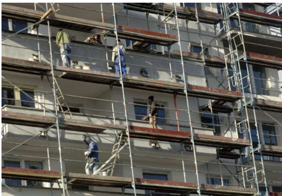
Ocieplanie nowego budynku
