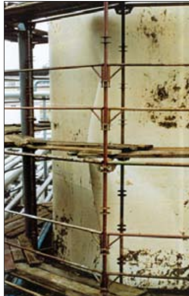
Fot. 7 | Deformacje płaszczu zbiornika
