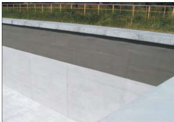
Fot. 1 | Zbiornik zabezpieczony powłokami mineralnymi
