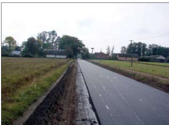
■ Budowa drogi wiejskiej na Mazowszu pomiędzy wsiami Płaczewo i Bielawy. Wykonano podbudowę o grubości 30 cm przy udziale spoiwa Silment CQ-25 w ilości 6–7% do masy gruntu. Wykonawca – Polski Recykling sp. z o.o. Magazyn Infrastruktura nr 5/2008, „4 kilometry w 4 dni”, str. 29–31, www.inframedia.pl
