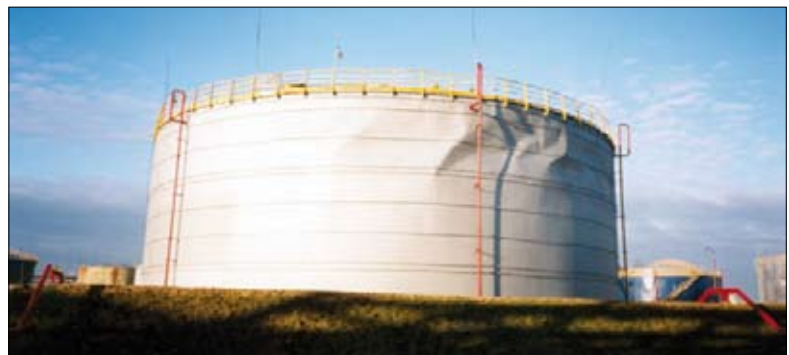
Fot. 3 | Deformacje płaszczu zbiornika V = 10 tys. m 3 uszkodzonego nadciśnieniem
