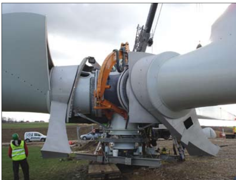
Fot. 1 | Montaż łopaty wimika turbiny wiatrowej do piasty na farmie wiatrowej Kisielice
