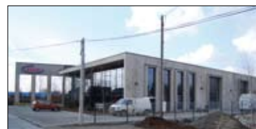
■ Systemowe rozwiązanie dostosowane do indywidualnych wymagań. Na pierwszym planie panele ściennie z elewacyjną warstwą betonową. W tle zmontowana z prefabrykatów kolumnada.
