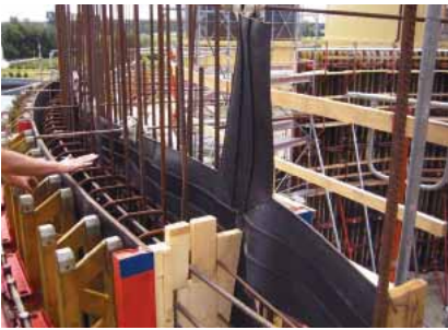
Fot. 3. Ściany zbiornika żelbetowego – uszczelnienie przerwy roboczej wewnętrzną taśmą BESAPLAST
