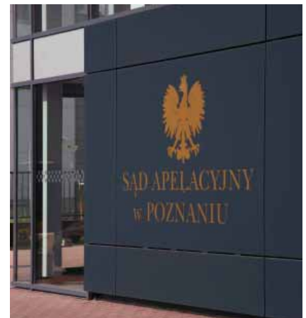
Fot. 2. Godło i napis wykonane techniką sitodruku na szklanym panelu
