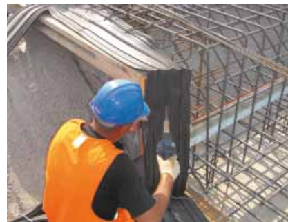
Fot. 2. Zgrzewanie taśm BESAPLAST na oczyszczalni ścieków
