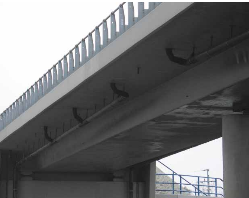
Fot. 2. Kosztowny system odwodnienia obiektu mostowego
