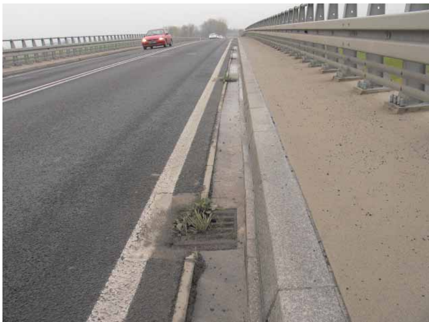
Fot. 4. Przykład zaniedbania administratora mostu – niesprawny system odwodnienia
