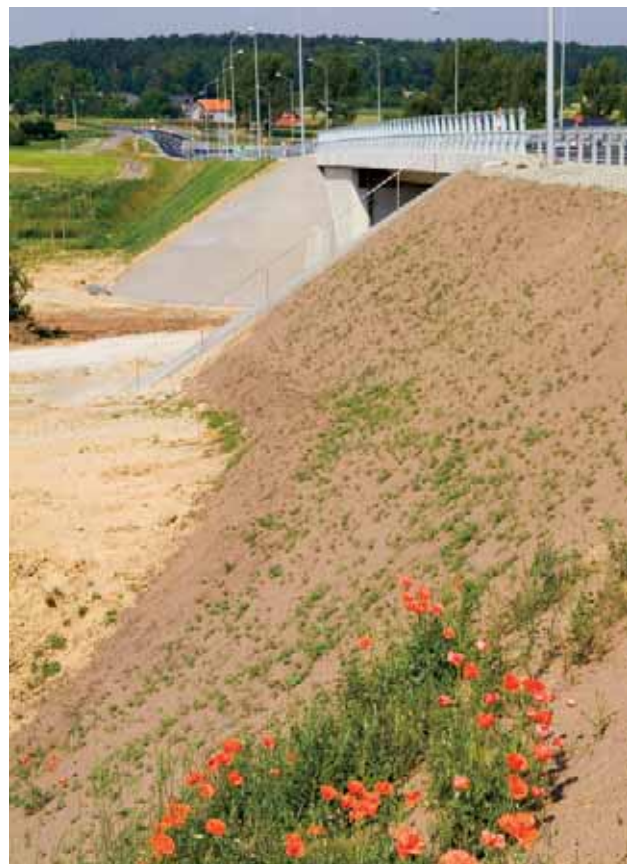
Fot.3. Obwodnica miasta Szubin; inwestor: GDDKiA; główny wykonawca: Skanska S.A.; fot. archiwum Skanska S.A.
