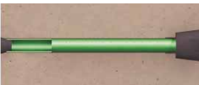
Rys. 4. Uszczelnienie przejścia ściągu przez ścianę zbiornika – rurka K 22 zamknięta korkami z betonu architektonicznego, zamontowanymi za pomocą kleju A+B
