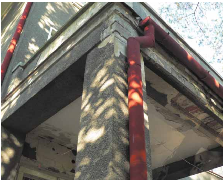
Fot. Błędy w projektowaniu balkonu spowodowały zacieki, zniszczenia krawędzi oraz silne przecieki na styku balkonu z ścianą
