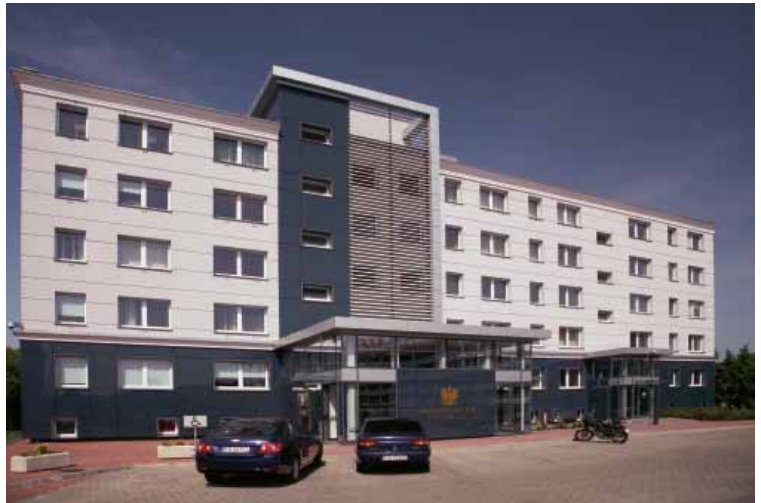
Fot. 1. Sąd Apelacyjny w Poznaniu. Parter i część środkowa – zastosowano StoVerotec Glas
