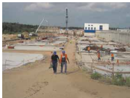
Fot. 1. Oczyszczalnia ścieków w Łodzi – uszczelnienia BETOMAX Polska
