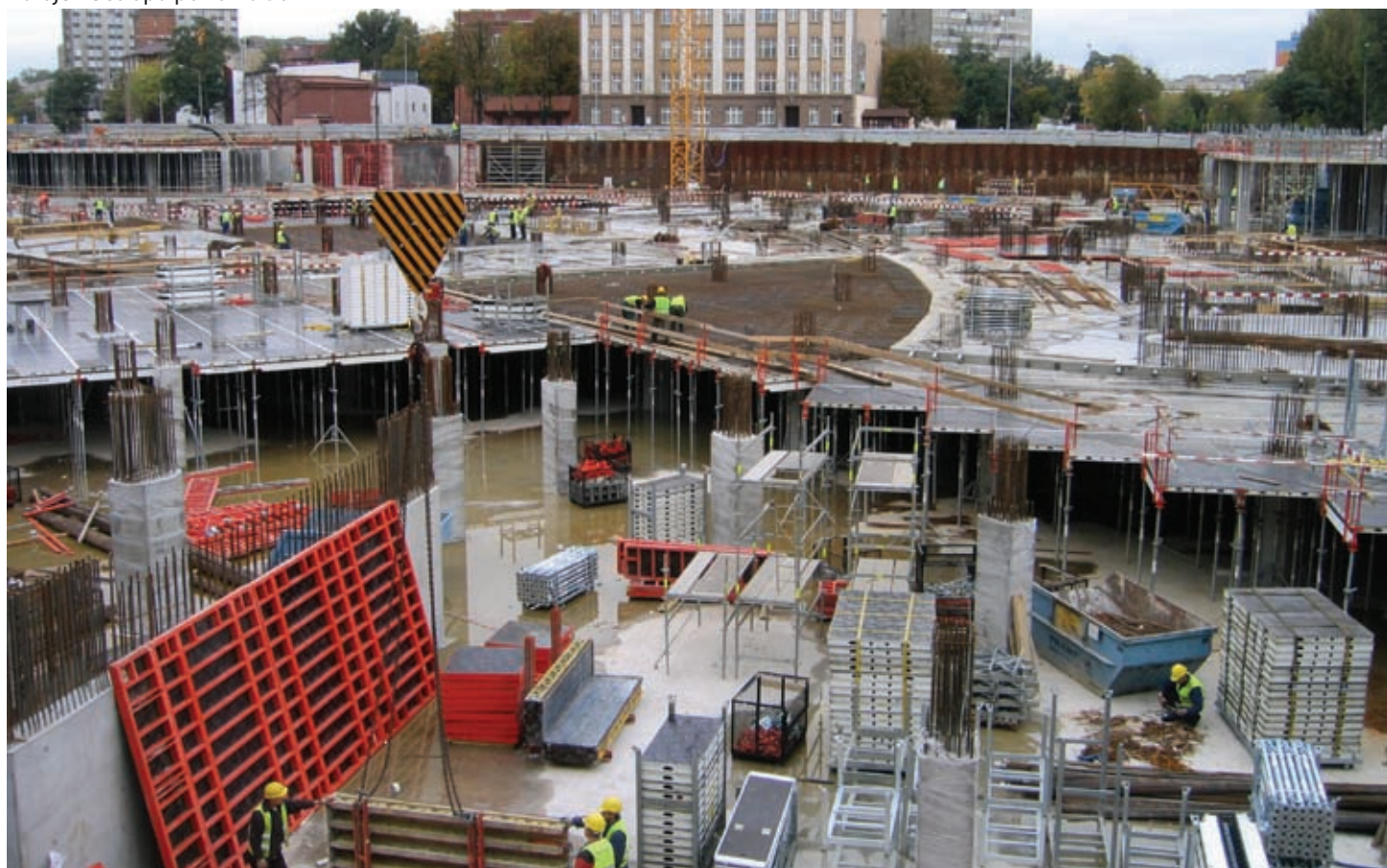
Zbrojenie stropu poziomu B01
