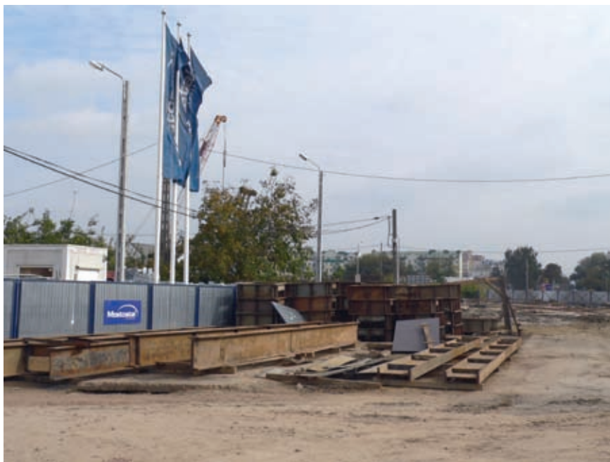
Budowa obwodnicy Warszawy
