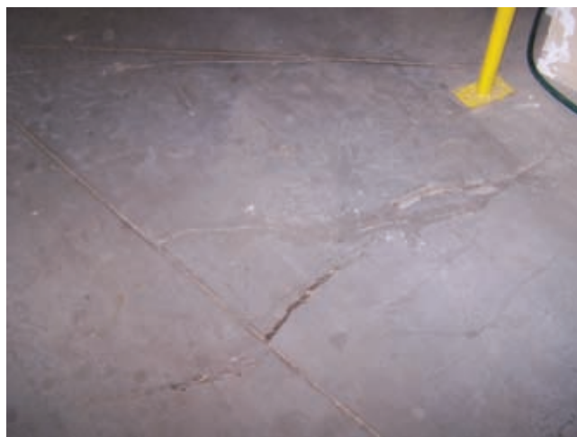
Fot. 2. Pęknięcia posadzki spowodowane osiadaniem podłoża gruntowego
