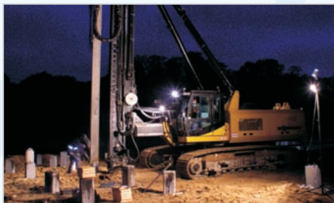
Autostradowa Obwodnica Wrocławia - estakady dojazdowe MA21
