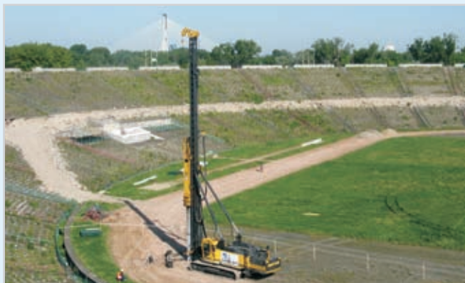
Warszawa - Stadion Narodowy - palowanie testowe
