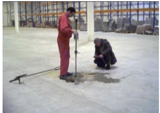
Fot. 1. Badanie kontrolne podłoża gruntowego
