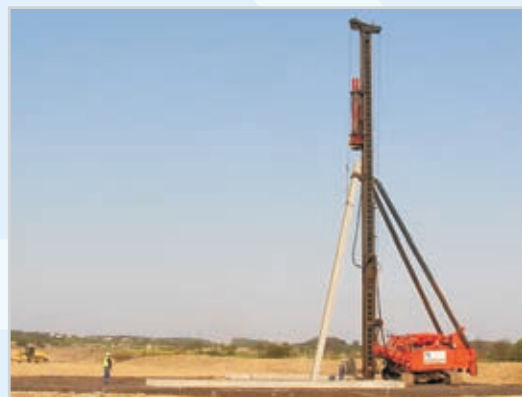
Autostrada A1 - odcinek Świerkły-Gorzyczki
