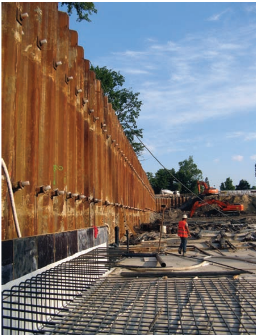
Zbrojenie płyty fundamentowej pod budynkiem wieży
