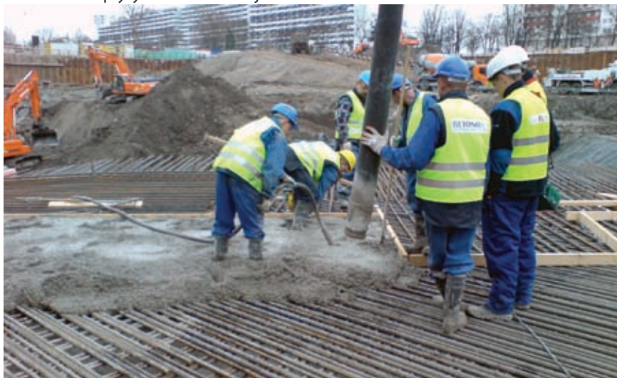
Betonowanie płyty fundamentowej
