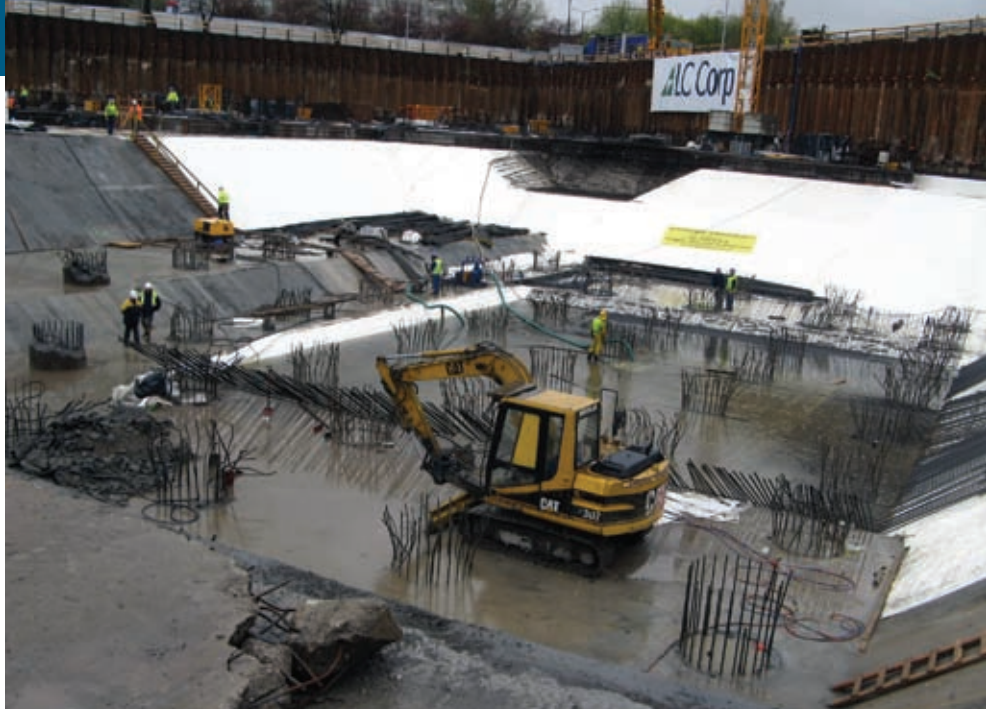
Układanie izolacji przeciwwodnej Preprufe pod płytą fundamentową
