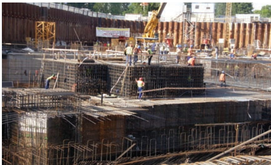
Zbrojenie płyty fundamentowej pod Wieżą, kształtowanie zagłębień na podszybia wind
