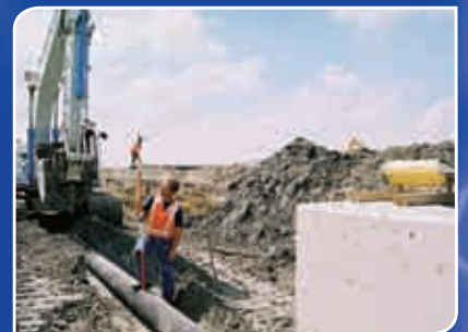
● Prace liniowe i kanalizacyjne
