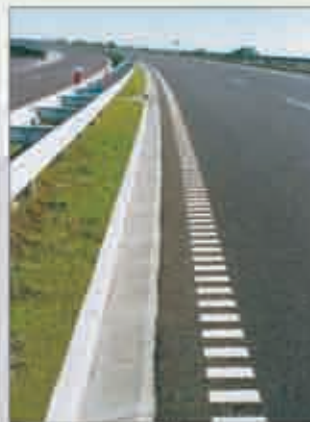
Płyta ściekowa typ trójkątny
