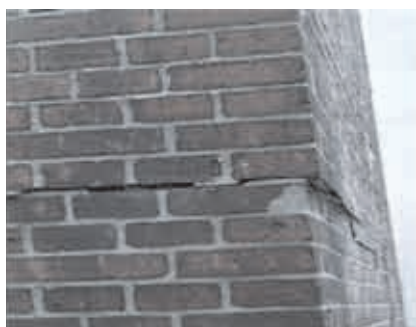
Rys. 3. Przesunięcie poziome ściany cokołu
