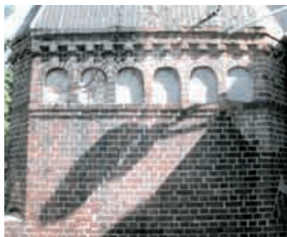
Rys. 2. Zarysowania ścian cokołu kominu
