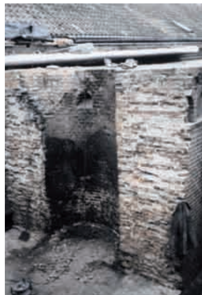
Rys. 4. Widok cokołu kominą podczas rozbiórki
