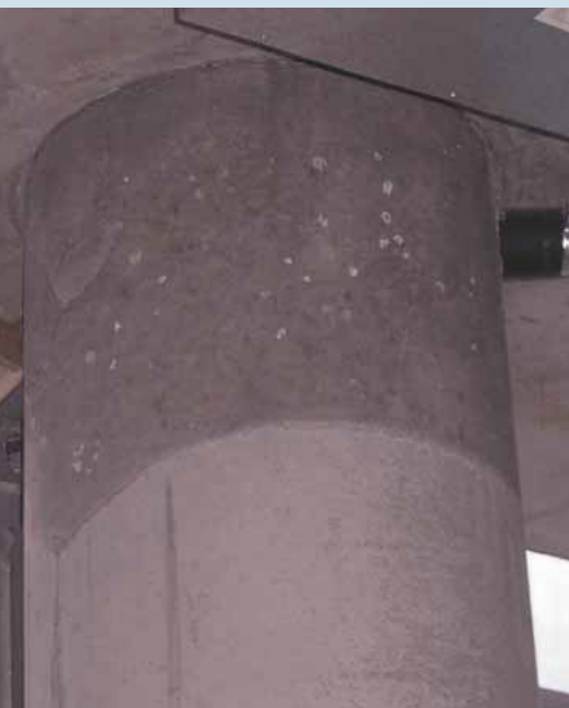
Fot. 16. Zmiany barwy wynikające z różnego czasu rozdeskowania
