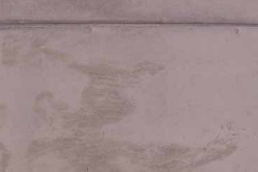
Fot. 15. Plamy powstałe w skutek zaschnięcia mleczka cementowego na powierzchni deskowania
