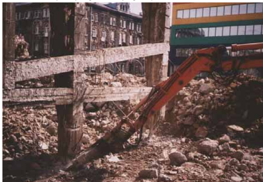
Fot. 4. Zmiżdżony dolny fragment skrajnego słupa
