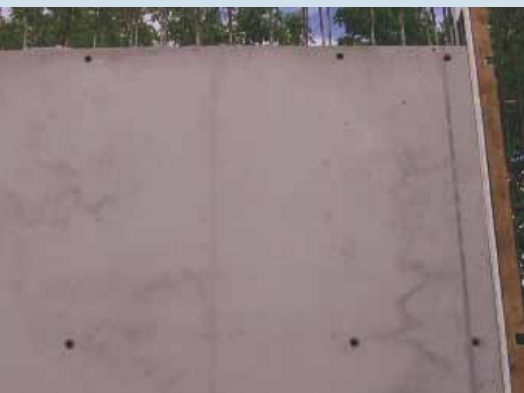
Fot. 12. Efekt nierównomiernego nałożenia środka antyadhezyjnego, tzw. chmurki
