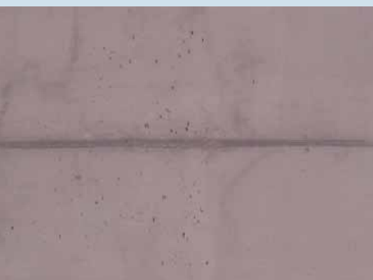
Fot. 13. Nieciągłości struktury w postaci pęcherzy powietrza wynikające z nieprawidłowego zagęszczenia
