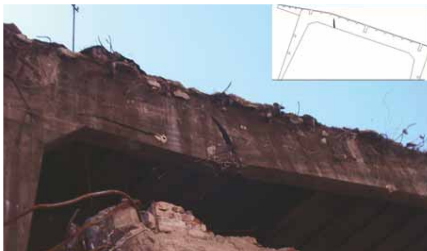
Fot. 6. Zarysowanie rygli w końcowym procesie „kładzenia” ram
