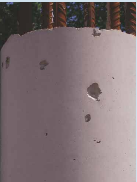
Fot. 13. Nieciągłości struktury w postaci pęcherzy powietrza wynikające z nieprawidłowego zagęszczenia
