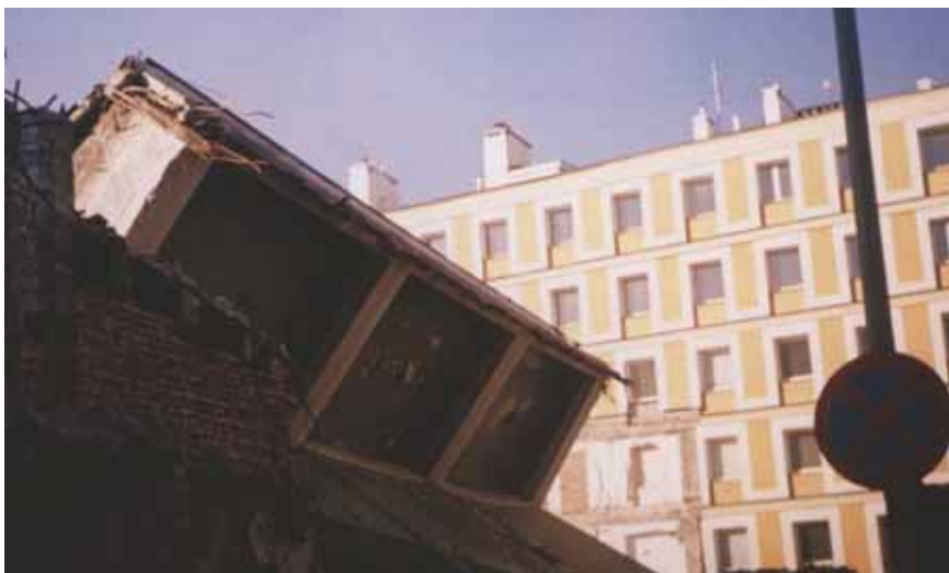
Fot. 7. Widok leżących ram od strony ul. Okrzei
