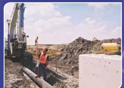
● Prace liniowe i kanalizacyjne
