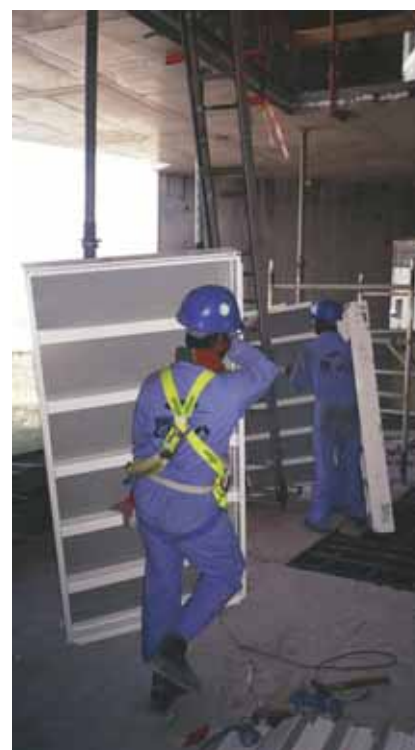
Fot. Prace nad deskowaniem
