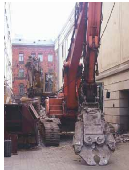
Fot. 1. Koparka uzbrojona w kleszcze
