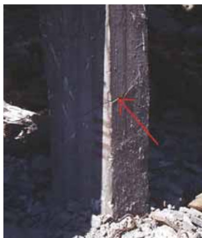
Fot. 5. Tworzenie się w słupie przegubu plastycznego
