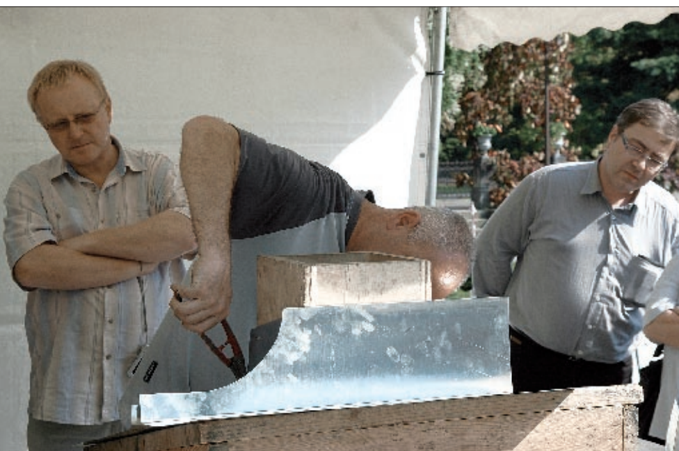
Fot. Wykonanie obróbek komina
