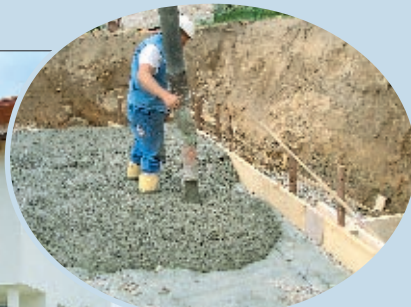
Fot. 6. Płyta denna na gruncie, dom jednorodzinny Linzerberg w Austrii (fibrobeton C25/30)
