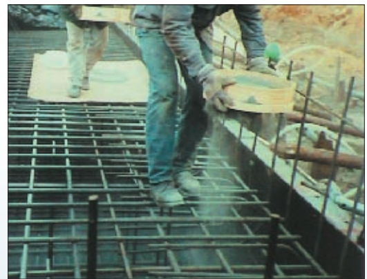
Fot. 1. Wykonywanie posypki
