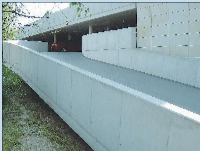
Fot. 2, 3, 4 Przykłady wykorzystania betonu wysokich wytrzymałości (B60) na budowie Świątyni Opatrzności Bożej w Warszawie
