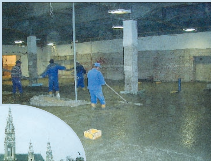
Fot. 5. Posadzki w piwnicach – Austria – ratusz w Wiedniu (fibrobeton C25/30)
