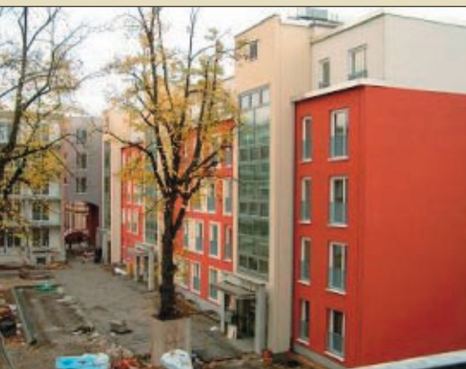
Budynek w standardzie pasywnym, Frakfurt. Pow.: 14767 m 2 ; zapotrzebowanie na ciepło do ogrzewania: 15 kWh/(m 2 •rok)
