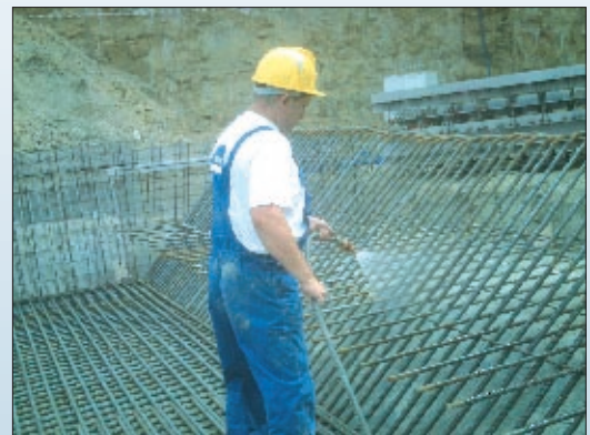
Fot. 2. Utwardzanie Hydrostopu przez zraszanie na „skosach”
