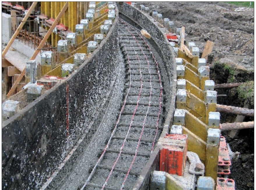
Fot. 2. ogrzewanie powierzchni bieźni
