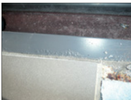
Fot. 2. Pierwsze wizualne objawy korozji obróbek blacharskich, por. fot. 3 i 4
