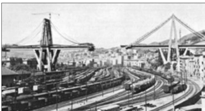
Fot. 3. Montaż cięgien podwieszających na pylonie centralnym (sekcja S2) oraz gotowa konstrukcja pylonu wschodniego (sekcja S3) [3]
