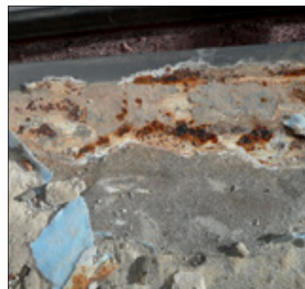
Fot. 4. Korozja obróbek widoczna po wykonaniu odkrywki, opis w tekście
