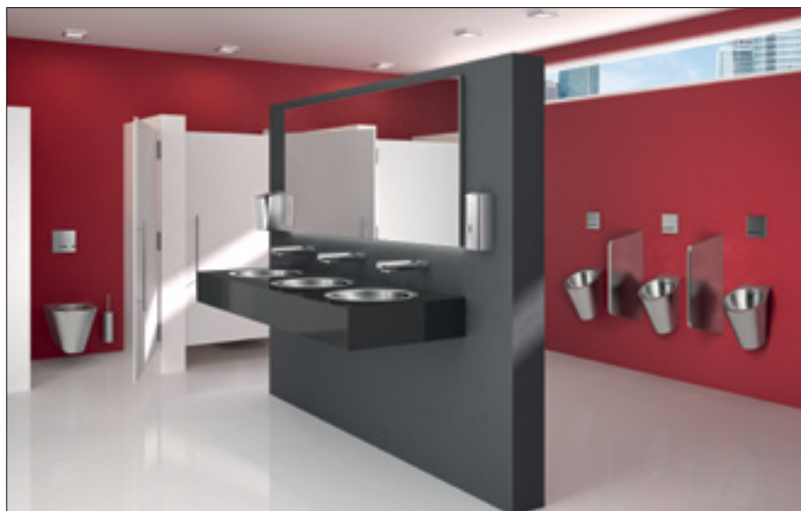
Fot. 1. Przykład instalacji w galerii handlowej
