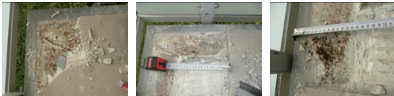
Fot. 1. Korozja obróbek widoczna po wykonaniu odkrywki – opis w tekście
