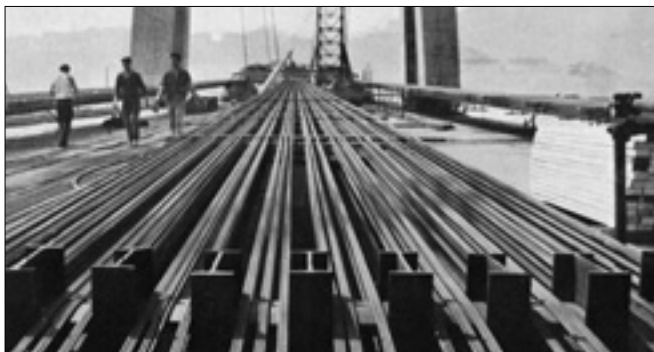
Fot. 2. Tymczasowe sprężenie zewnętrzne podtrzymujące wsporniki w czasie budowy [3]
