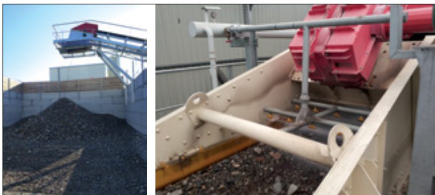
Fot. 2. Pranie gruntu
