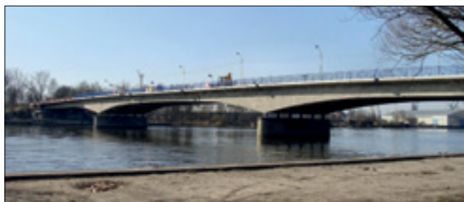
Fot. 13. Widok mostu Clowego w Szczecinie
