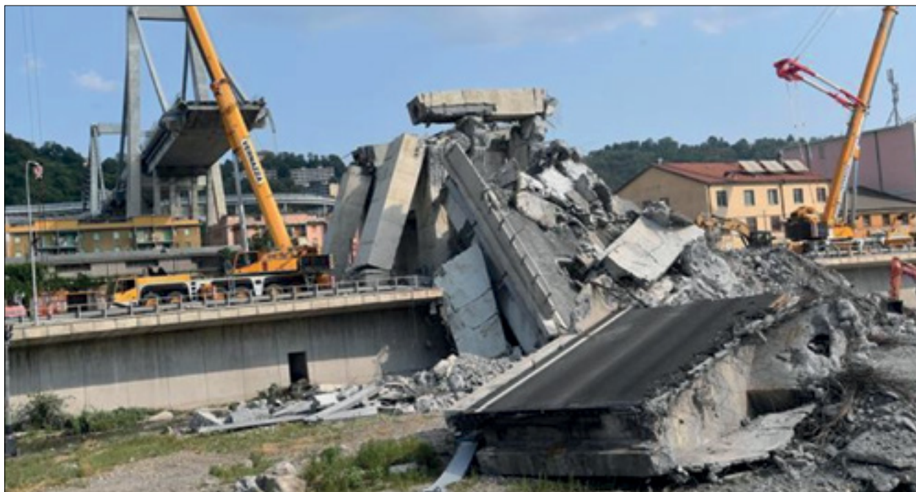
Fot. 7. Widok zniszczonej konstrukcji [5]
