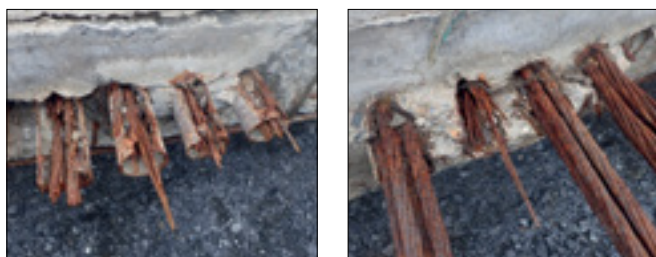
Fot. 12. Katastrofa kładki Troja w Pradze. Zerwane kable sprężające w środkowym przekroju głównego przęsła (www.uschovna.cz)
