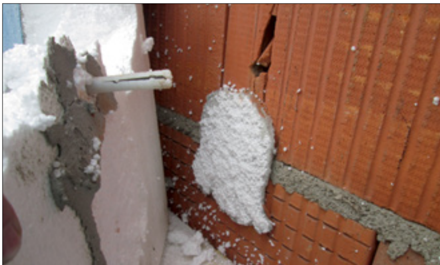
Fot. 2. Uszkodzenie podłoża (pustaka ceramicznego) przez wiercenie z uderem
