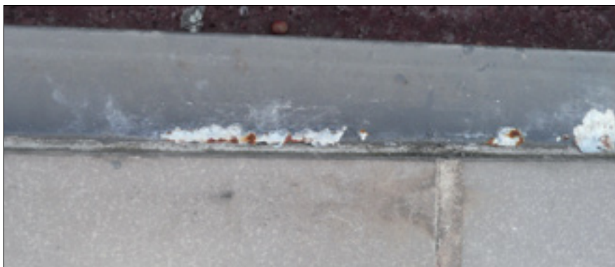
Fot. 3. Widok zewnętrzny okapu balkonu diagnozowanego ze względu na korozję obróbek, opis w tekście
