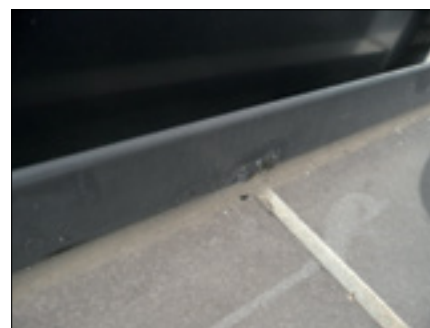
Fot. 2. Pierwsze wizualne objawy korozji obróbek blacharskich, por. fot. 3 i 4
