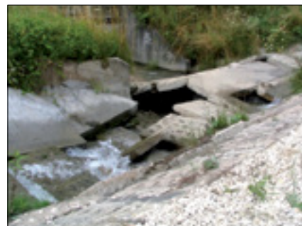
Fot. 9, 10. Uszkodzenie rowu na skutek przebicia hydraulicznego i wyporu wywołanego zakolmatowaniem geowłókniny
