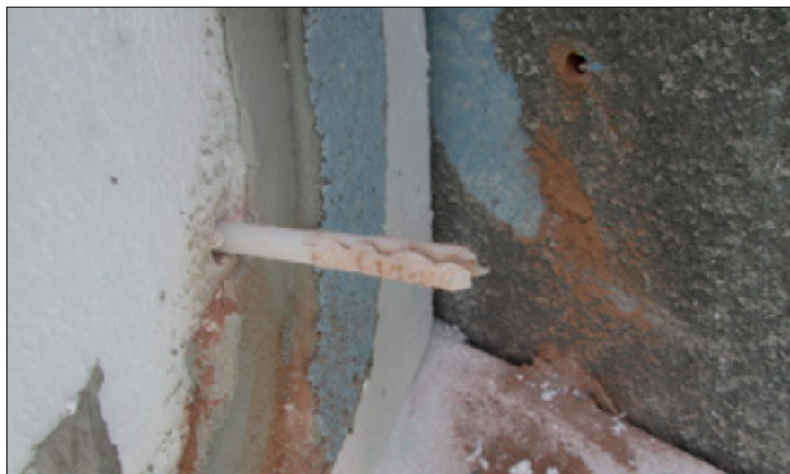
Fot. 3. Brak dostosowania średnicy wiertła do średnicy łącznika
