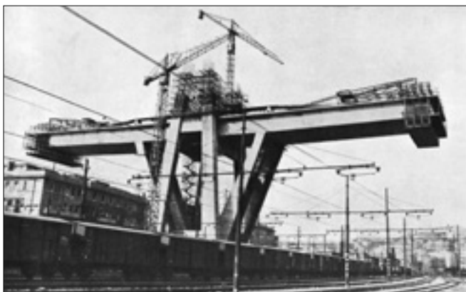
Fot. 1. Budowa części wspornikowej przęseł metodą betonowania wspornikowego [3]
