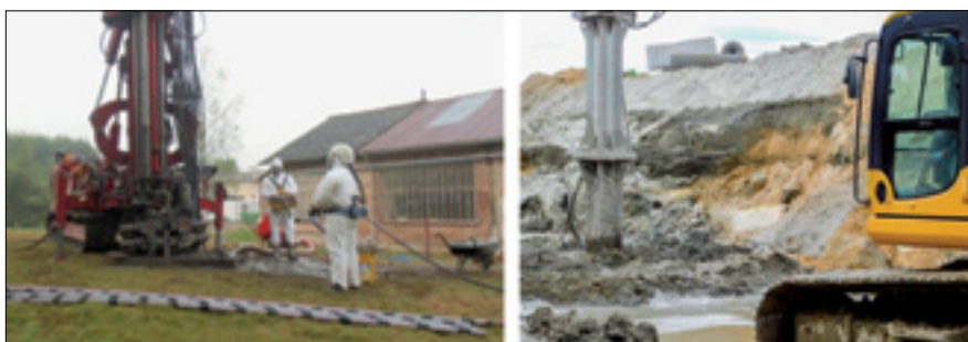
Fot. 3. Proces stabilizacji
