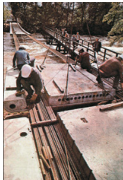
Fot. 9. Montaż segmentów prefabrykowanych typu DS-Lv [6], [11]
