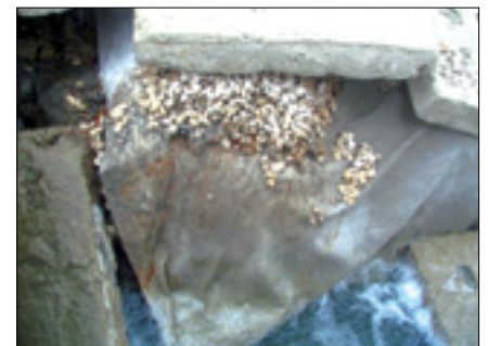
Fot. 9, 10. Uszkodzenie rowu na skutek przebicia hydraulicznego i wyporu wywołanego zakolmatowaniem geowłókniny
