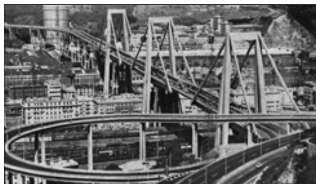
Fot. 5. Widok wiaduktu pod koniec lat 60. XX w. [3]
