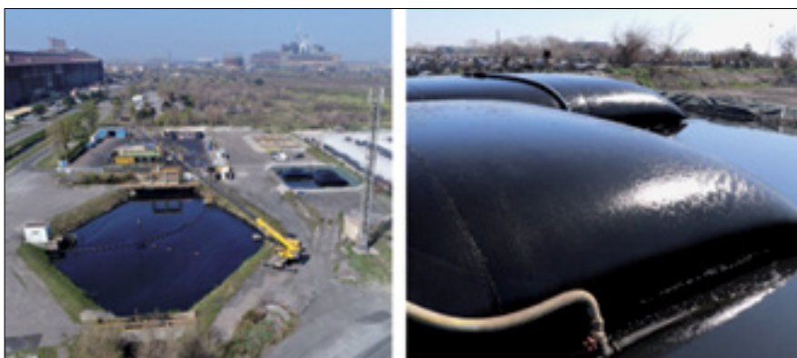
Fot. 4. Minimalizacja kubatury/masy odpadu za pomocą geotube
