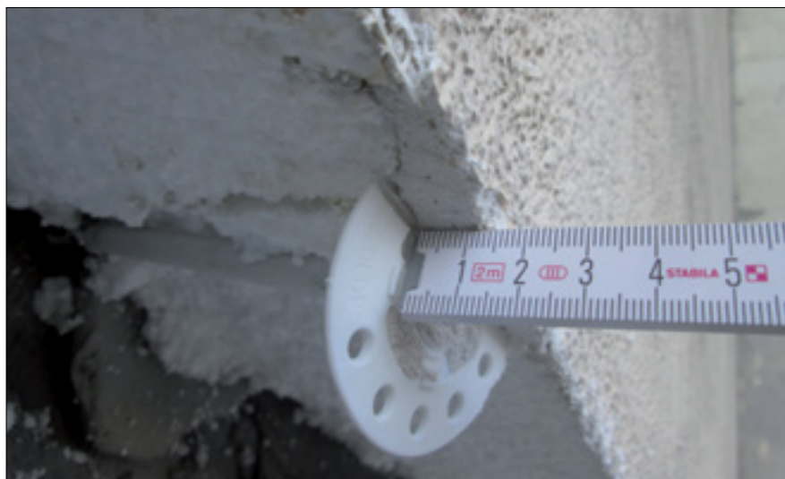
Fot. 1. Łącznik nadmiernie zagłębiony w termoizolacji, a talerzyk zaspachlowany grubą warstwą kleju
