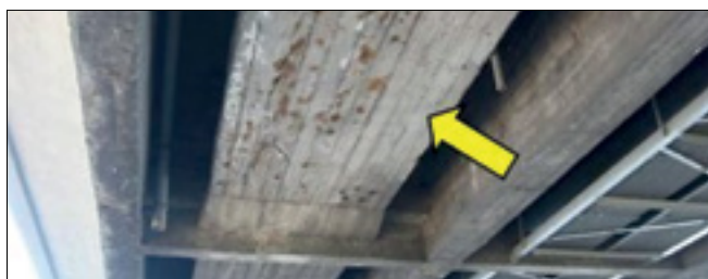
Fot. 14. Widok taśmy betonowej osłaniającej kable zewnętrzne w moście Clowym (fot. K. Żółtowski)
