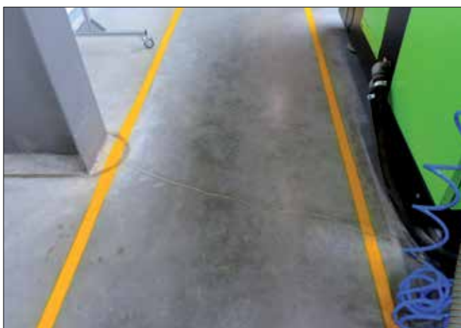
Fot. 6. Naprawa pęknięć posadzki betonowej za pomocą żywicy epoksydowej
