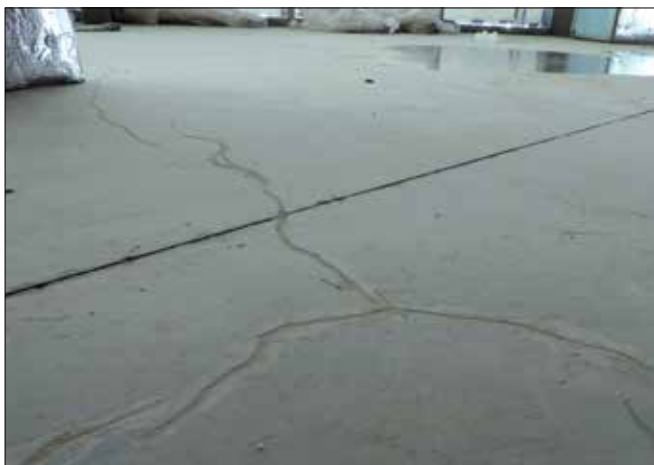
Fot. 4. Rysy (pęknięcia) podkładu fibrobetonowego pod płytki wypełnione żywicą epoksydową
