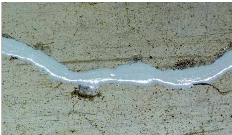
Fot. 2. Przykład zastosowania wyrobu iniekcyjnego zawierającego spoiwo polimerowe (żywica epoksydowa)
