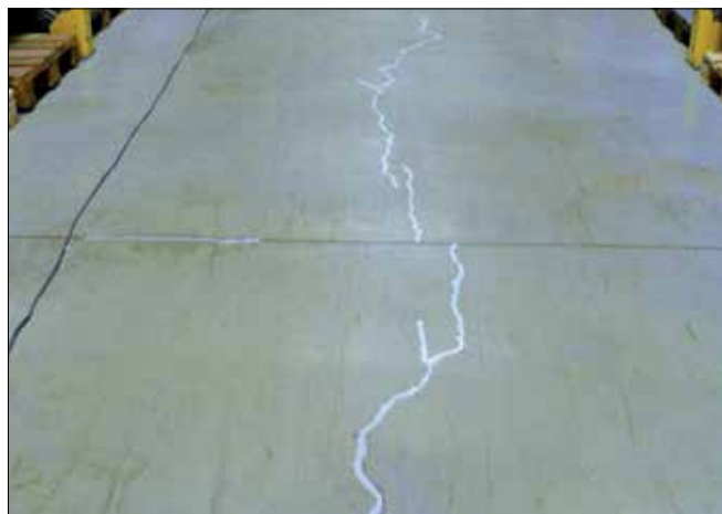
Fot. 5. Rysy (pęknięcia) posadzki w technologii DST wypełnione żywicą epoksydową
