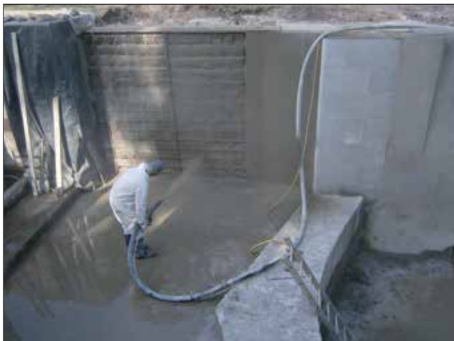
Fot. 4. Wykonywanie torkretowania
