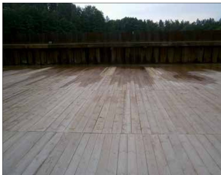
Fot. 7. Gotowa drewniana obudowa poszuru
