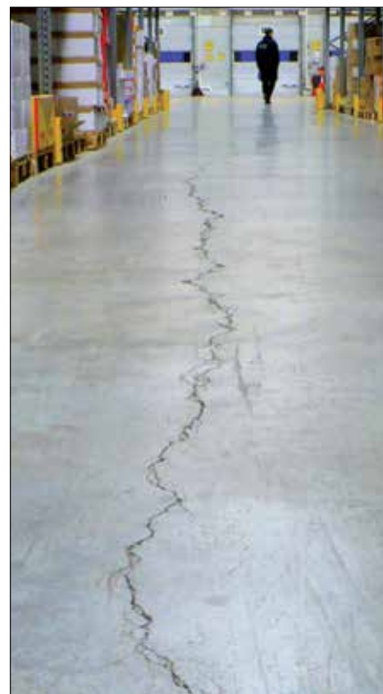
Fot. 1. Rysy (pęknięcia) płyty betonowej posadzki w magazynie
