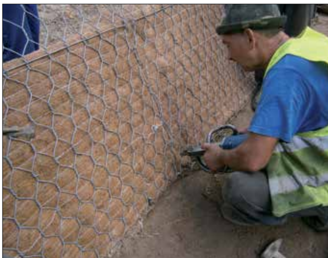
Fot. 5. Wykonywanie zabezpieczeń w systemie green terramesh
