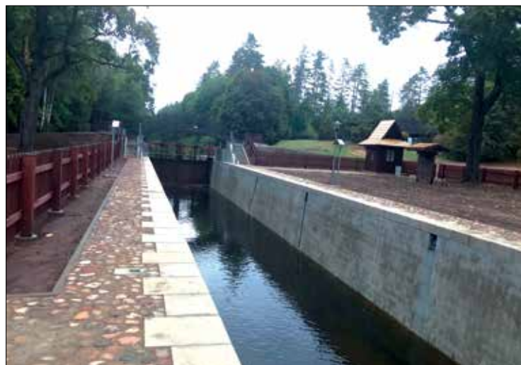
Fot. 8. Komora śluzy, w oddali widać wrota górne
