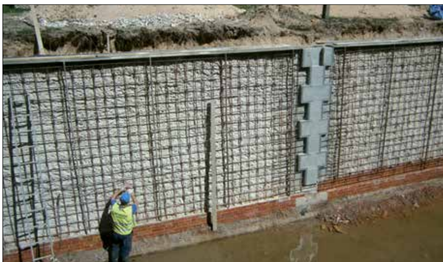
Fot. 3. Przygotowywanie siatki zbrojeniowej przed torkretowaniem na ścianie komory śluzy
