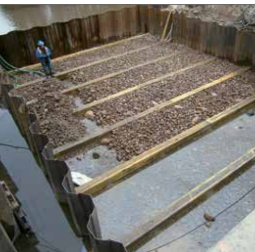
Fot. 2. Wykonywanie narzutu kamiennego w dnie awanportu dolnego śluzy
