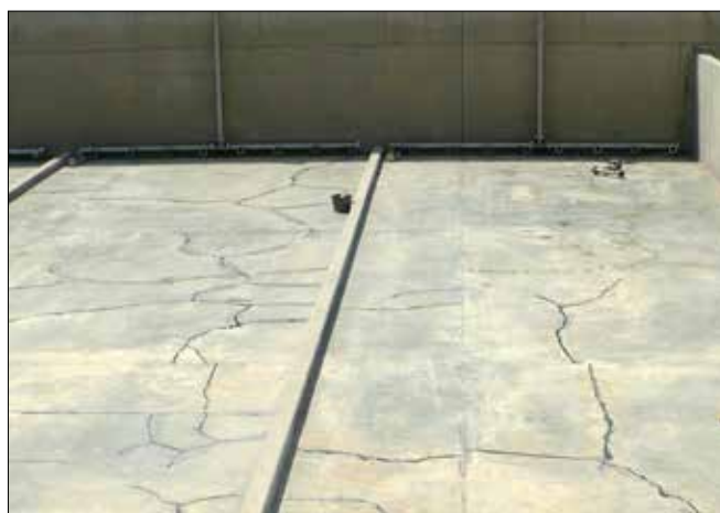
Fot. 7. Iniekcja pęknięć płyty zbiornika
