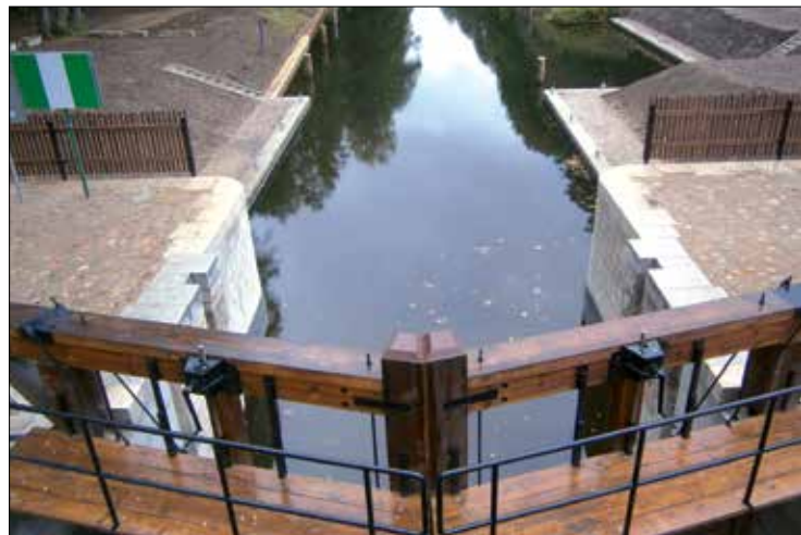
Fot. 6. Widok na głowę dolną oraz awanport dolny śluzy
