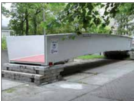
Fot. 3. Prototyp kładki pieszo-rowerowej Fobridge o konstrukcji warstwowej ( https://ctwt.pg.edu.pl )
