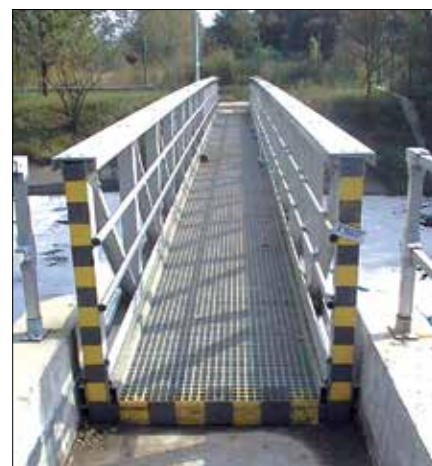
Fot. 1. Pierwszy polski obiekt mostowy z kompozytów FRP – kładka z kształtowników pultruzyjnych w Łodzi przez Ner (fot. W. Karwowski)
