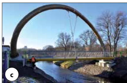
Fot. 2. Kładki pieszo-rowerowe holenderskiego systemu InfraCore w ciągu trasy Green Velo w woj. warmińsko-mazurskim: a) gmina Lelkowo, b) gmina Kiwity, c) gmina Gołdap ( http://mostykompozytowe.pl )
