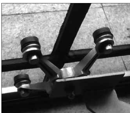
Fot. 1. Rotule do punktowego mocowania szkła (fot. autora)
