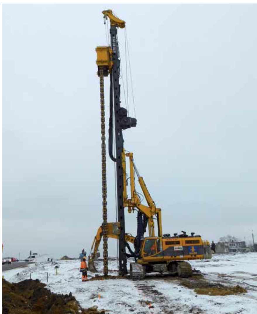
Fot. 15. Narzędzie TFoW zainstalowane na uniwersalnej palownicy umożliwiające wykonywanie ścian przy istniejących obiektach lub w granicy działki
