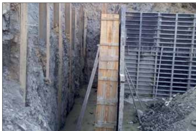
Fot. 1. Ścianka berlińska i mur oporowy
