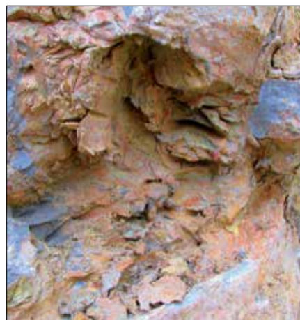
Fot. 4. Słabo wymieszany ropy – w szarym kolorze ślady zaczynu cementowego
