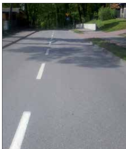
Nawierzchnia po 8 latach eksploatacji
