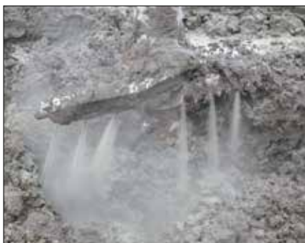
Fot. 7. Mieszadło DSM z dyszami iniekcyjnymi
