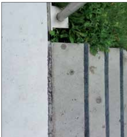
Fot. 4, 5. Schody na gruncie. Widoczna dylatacja między biegiem a spocznikiem
