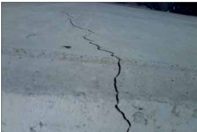
Fot. 5. Pęknięcie muru oporowego
