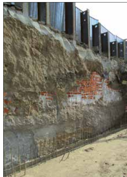
Fot. 14. Ściana zabezpieczająca wykop wykonana w technologii ciągłego mieszania, widoczne resztki starych murów
