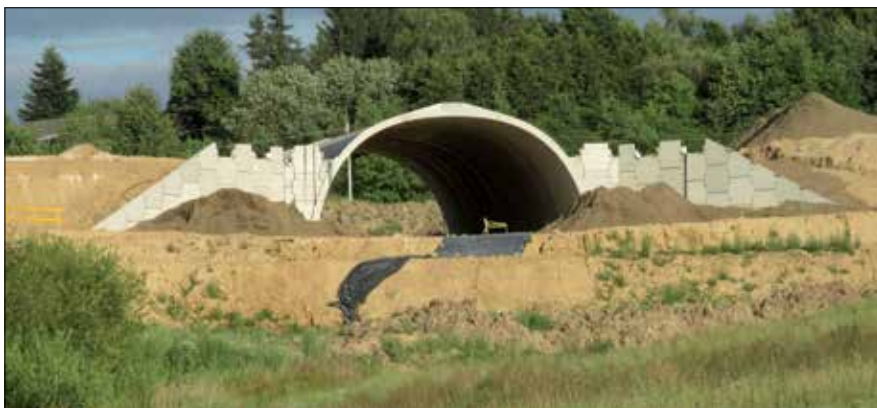
Fot. 13. Przejście pod wysokim nasypem z podłożem wzmocnionym ciągłymi ścianami
