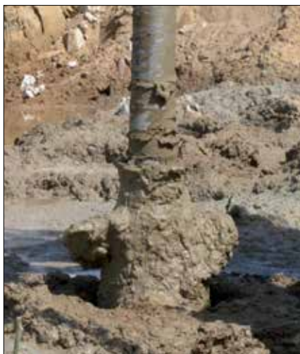
Fot. 3. Mieszadło oklejone niewymieszanym gruntem spoistym
