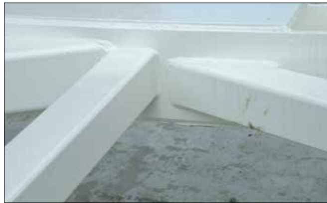
Fot. 12. Brak osiowości wspawania słupka i krzyżulców dźwigara
