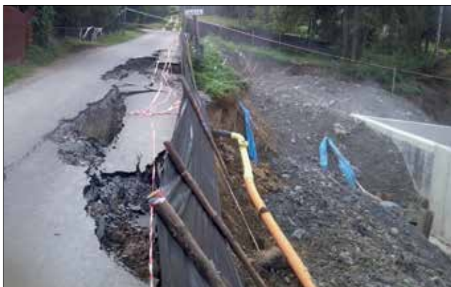
Fot. 7. Oberwanie drogi, między drzewami po prawej stronie okresowy ciek wodny
