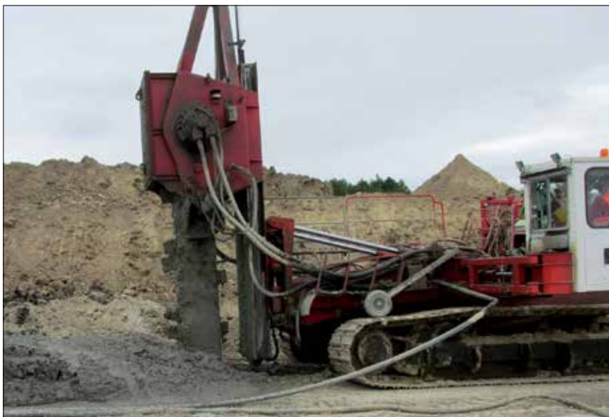
Fot. 12. Maszyna w trakcie wykonywania wzmocnienia podłoża wysokiego nasypu
