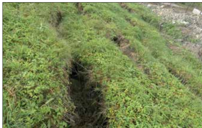
Fot. 8. Oberwanie gruntu powyżej muru
