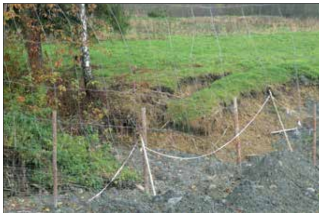
Fot. 6. Okresowy ciek wodny powyżej muru oporowego
