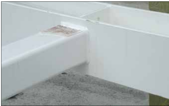
Fot. 11. Mimośród słupka kratownicy
