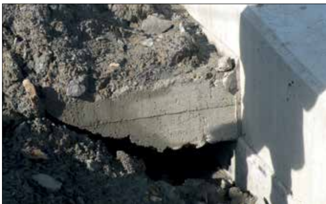
Fot. 3. Brak zagęszczenia zasypki muru oporowego pod płytą odciążającą
