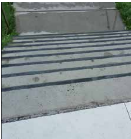
Fot. 4, 5. Schody na gruncie. Widoczna dylatacja między biegiem a spocznikiem
