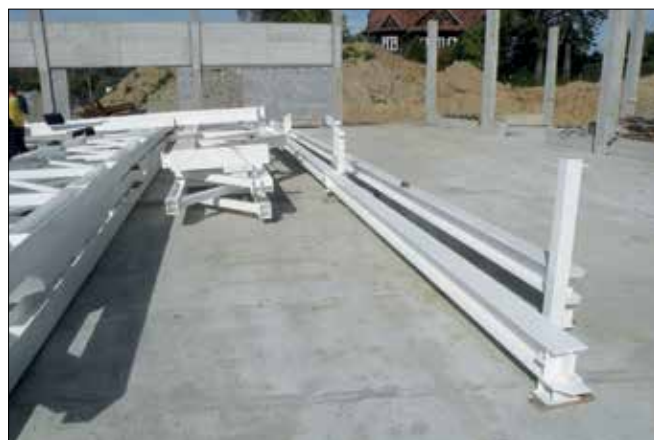
Fot. 10. Elementy stalowe konstrukcji dachu
