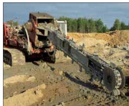
Fot. 10. Maszyna do wykonywania ciągłych ścian z gruntobetonu
