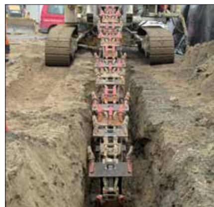
Fot. 11. Trenczmikser z mieczem w rowku prowadzącym
