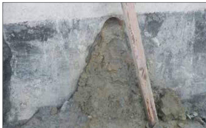
Fot. 4. Gлина wypływająca z otworów odpływowych muru oporowego
