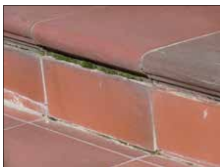
Fot. 1. Uszkodzenia płytek podstopnic i stopnic zwykle mają kilka przyczyn
