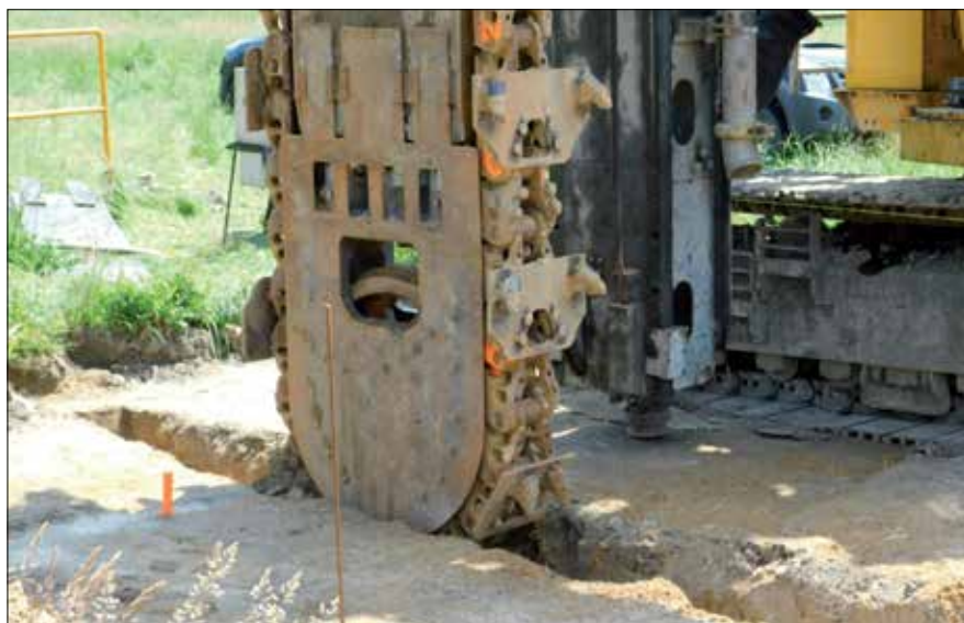
Fot. 16. Miecz z łańcuchem osadzony na klasycznej palownicy. Narzędzie zagłębia się pionowo w grunt przy wykonywaniu obudowy wykopu
