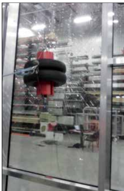
Fot. 4. Ściana osłonowa, zachowanie się szyby po uderzeniu oponą 50 kg
