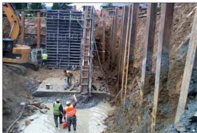
Fot. 2. Ścianka berlińska i mur oporowy
