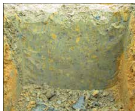
Fot. 8. Przekrój przez ścianę wykonaną trenczmikserem
