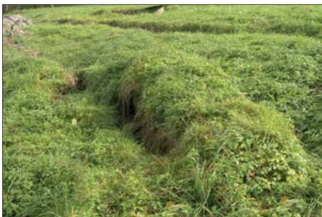
Fot. 9. Oberwanie gruntu powyżej muru
