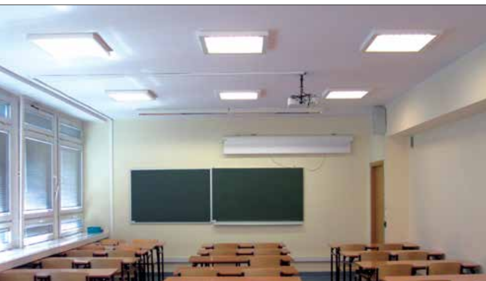
Fot. 2. Sala oświetlona lampami LED
