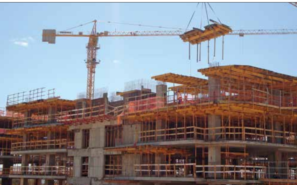
Fot. 3. Deskowanie stropu – stolik VR – Ulma
