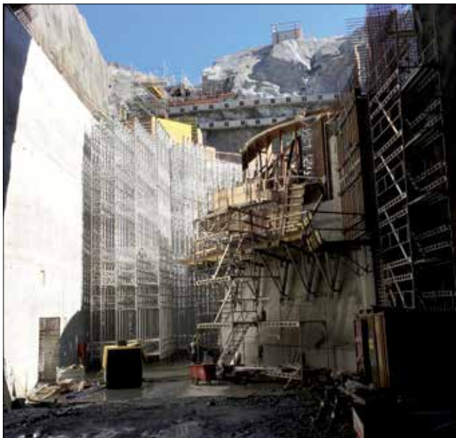
Fot. 4. Rusztowania wsporcze Titan Megashore. Budowa elektrowni wodnej Vamma, Norwegia
