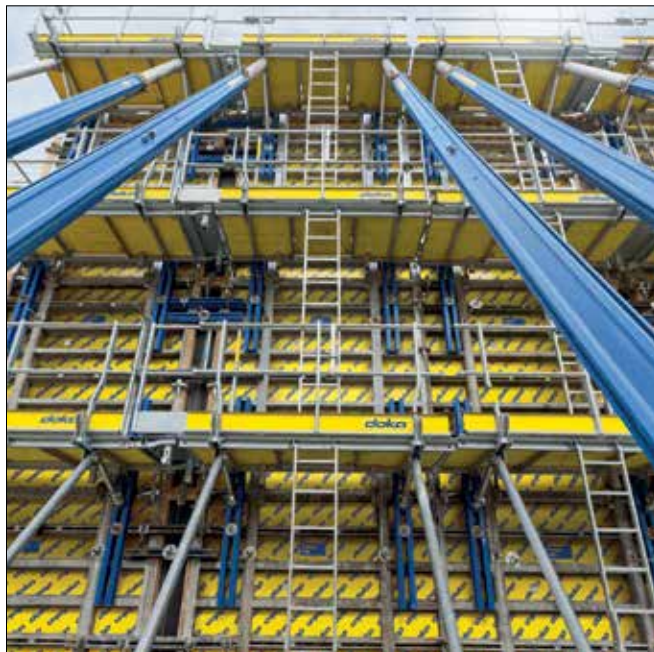
Fot. 5. Deskowanie firmy Doka: Framax XLife z pomostami Xsafe Plus
