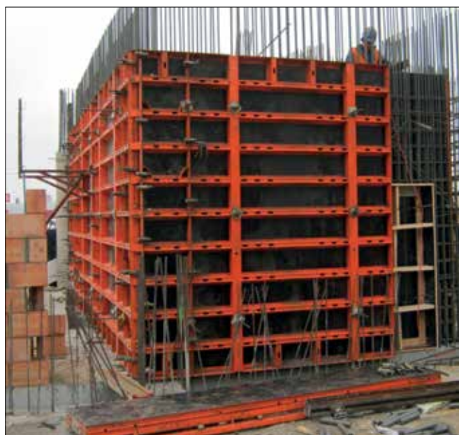
Fot. 1. System deskowań ściennych Alfa – Palisander
