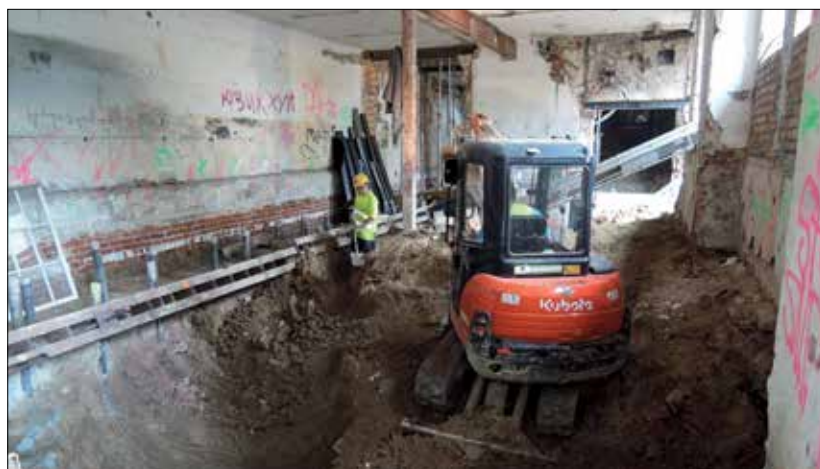
Fot. 8 | Roboty ziemne wewnątrz obiektu
