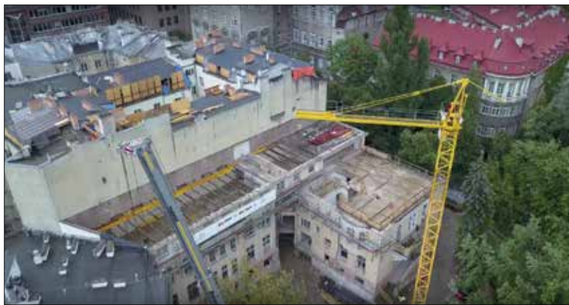
Fot. 2 | Budowa siedziby (widok z drona)
