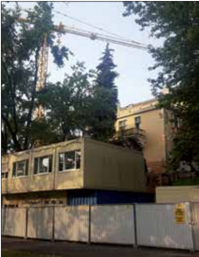
Fot. 3 | Zaplecze budowy – widok od strony ul. Spacerowej
