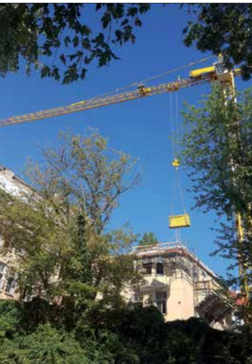
Fot. 7 | Prace montażowe
