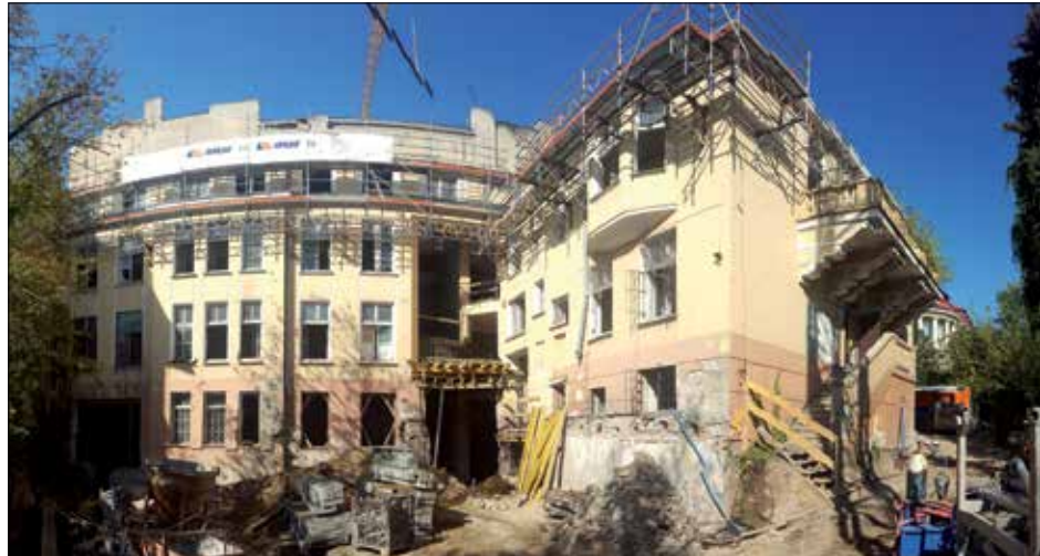
Fot. 5 | Rusztowania wiszące
