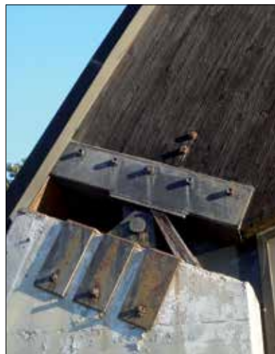
Fot. 2 | Widoczne początkowe oznaki korozji biologicznej strefy podporowej łuku z drewna klejonego i zniszczone biologicznie oparcie belki na murze (źródło własne)
