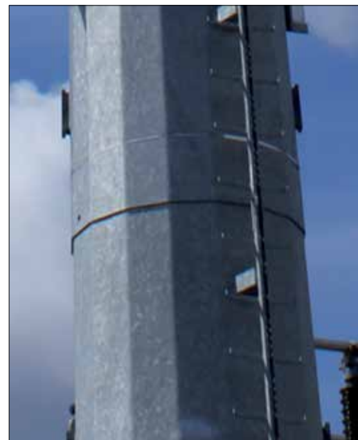
Fot. 3 | Połączenie zaciskowe trzonów [5]
