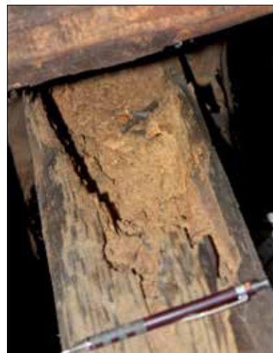
Fot. 1 Porażenie/uszkodzenie drewna przez drobnoustroje i techniczne szkodnika drewna (źródło własne)
