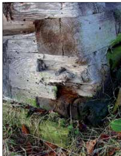
Fot. 1 Porażenie/uszkodzenie drewna przez drobnoustroje i techniczne szkodnika drewna (źródło własne)
