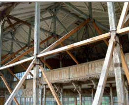
Fot. 3 | Użycie drewna litego do zabezpieczenia konstrukcji (źródło własne)
