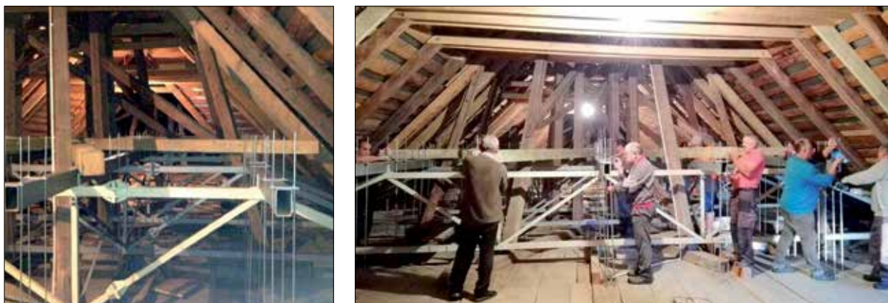
Fot. 4 | Stalowe konstrukcje wsporcze przejmujące/wspomagające pracę elementów drewnianych (źródło własne)
