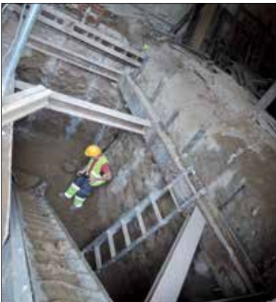
Fot. 10 | Prace budowlane wewnętrzne
