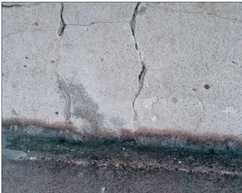
Fot. 1 Uszkodzone (zarysowane) tynki tradycyjne; bezkrytyczna naprawa, np. poprzez wykonanie warstwy wzmacniającej z siatką, jest niedopuszczalna
