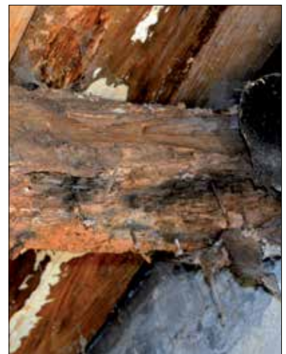
Fot. 2 | Widoczne początkowe oznaki korozji biologicznej strefy podporowej łuku z drewna klejonego i zniszczone biologicznie oparcie belki na murze (źródło własne)
