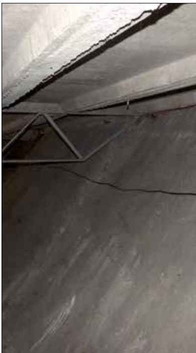
Fot. 2 | Widoczne uskoki na wierzchniej stronie płyt dachowych
