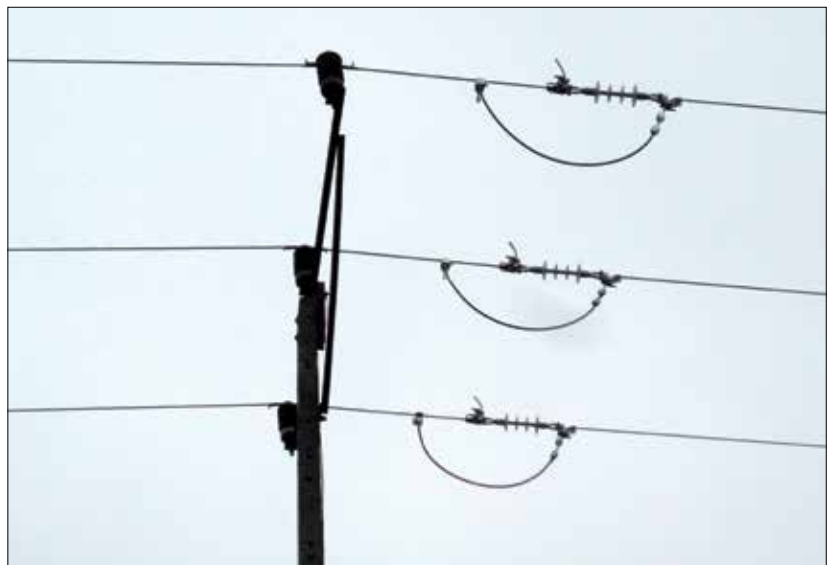
Fot. 2 | Słup P wg LSN, układ płaski po adaptacji w stanie „mostki zapięte”
