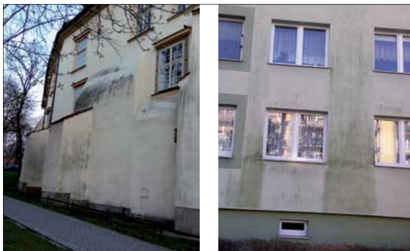
Fot. 1 | Typowe skutki oddziaływania wody opadowej na tynk
