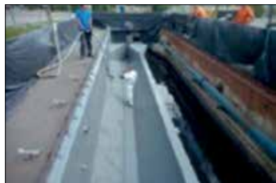
Fot. 1 | Aplikacja powłoki MasterSeal M 689 wewnątrz piaskownika przy oczyszczalni ścieków komunalnych (udostępnione przez ELIN Andrzej Juszcak)
