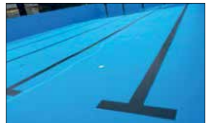
Fot. 6 | Niecka basenu kąpielowego wykończona alifatyczną powłoką polimocznikową MasterSeal M 699 (udostępnione przez PPHU Superbau)
