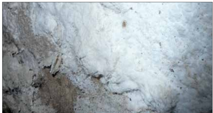
Fot. 6 | Skorupy solne na powierzchni muru, taki stan nierzadko wymaga zastosowania tynków odsalających
