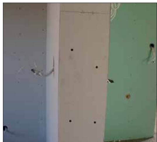
Fot. 1 Ściana wykonana z różnych płyt g-k
