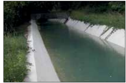
Fot. 4 | Izolacja w kanale irygacyjnym
