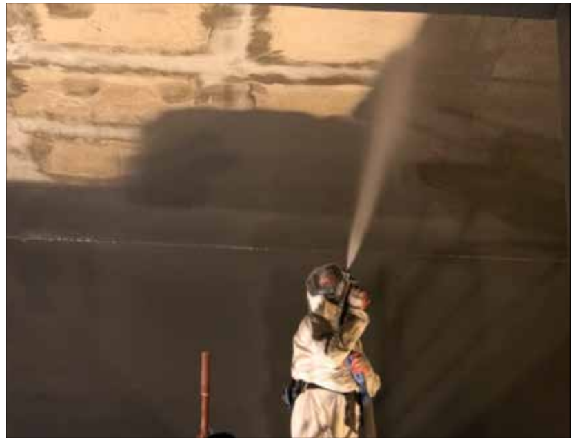
Fot. 5 | Powłoka polimocznikowa na wewnętrznych powierzchniach zbiornika wody (udostępnione przez DUKO Engineering)
