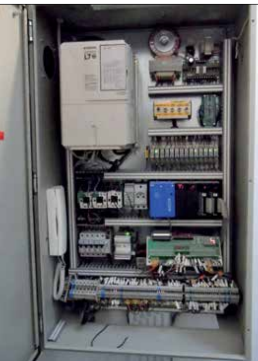
Fot. 1 | Nowoczesna tablica sterowa wyposażona w regulator częstotliwości
