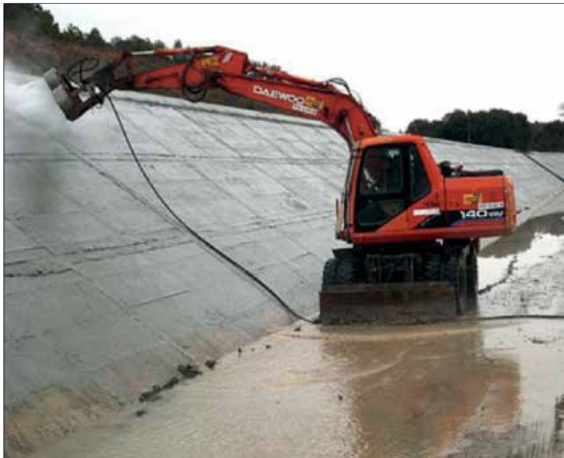
Fot. 3 | Przygotowanie podłoża
