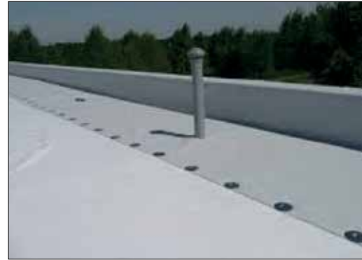
Fot. 12 | Powierzchnia dachu z mnogością detali
