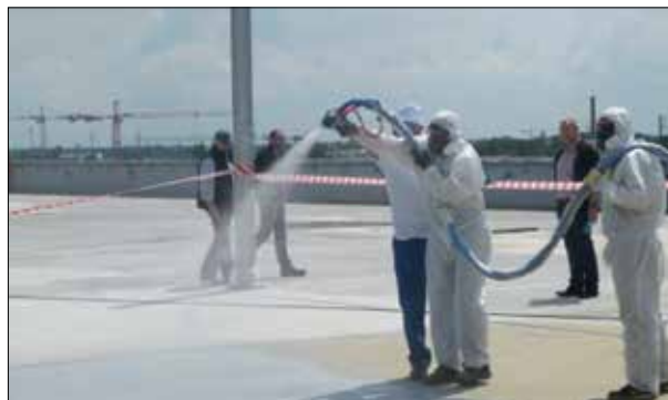
Fot. 2 Prace wykończeniowe żywicą polimocznikową w technologii Over Spray
