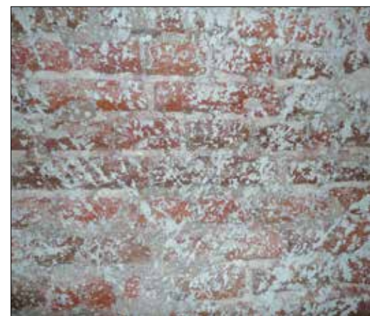
Fot. 4 | Poprawnie wykonana półkryjąca obrzutka pod tynk renowacyjny
