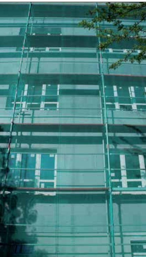
Fot. 3 | Wykonywanie ocieplenia ścian pod osłoną siatek
