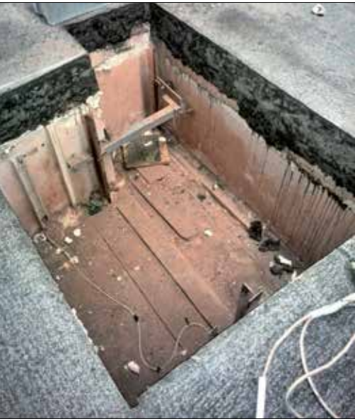
Fot. 3 | Dobudowa przystanku do istniejącego dźwigu
