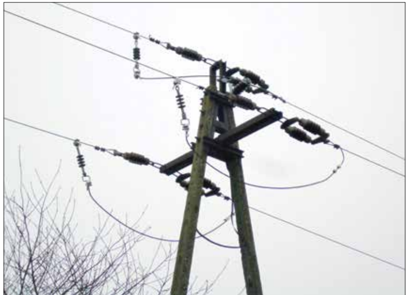
Fot. 1 | Słup OA wg LSN, układ trójkątny po adaptacji w stanie „mostki rozpięte”, separatory WSM wpięte
