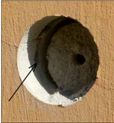
Fot. 5 | Skutek pominięcia obrutki w systemie tynków renowacyjnych
