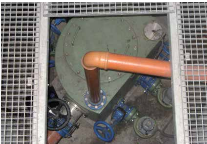
Fot. 3 | Komora przepompowni ze wstępną separacją – tłoczni
