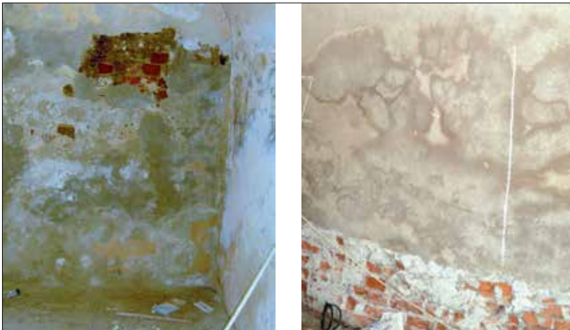
Fot. 3 | Tradycyjny tynk narażony na oddziaływanie wilgoci (pod różnymi postaciami) oraz krystalizację soli szybko ulega destrukcji
