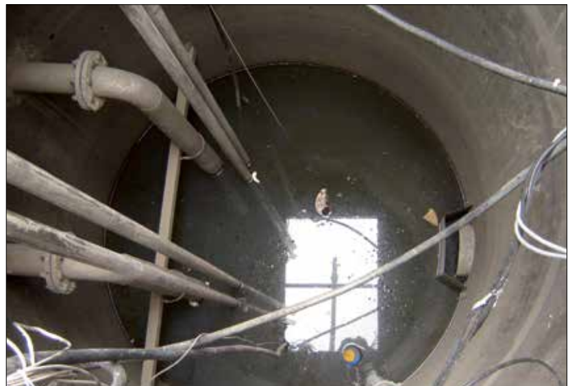
Fot. 2 | Typowe rozwiązanie pompowni ścieków z pompami zatapialnymi
