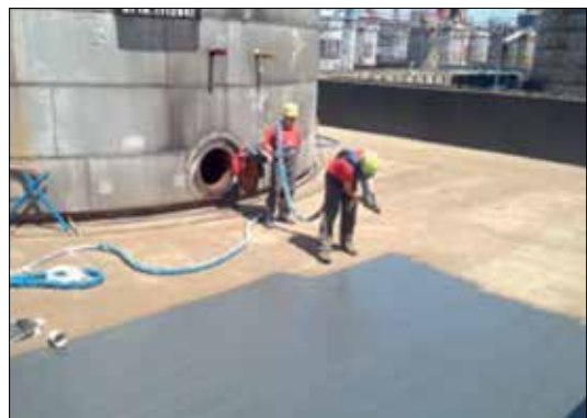
Fot. 9 | Przykładowa realizacja natrysków w technologii MasterSeal M 689 (udostępnione przez ERAL Usługi Techniczne)
