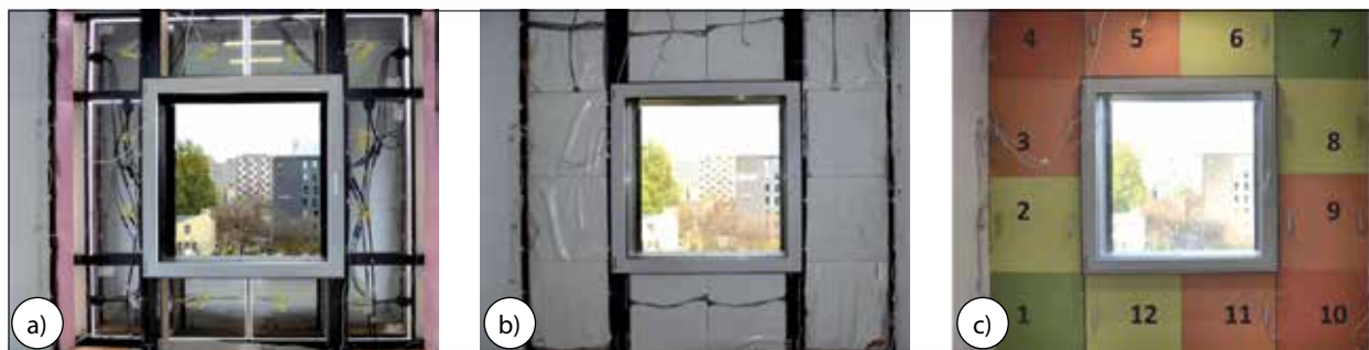
Fot. 1 Struktura ściany z pokazaniem poszczególnych jej warstw: a) powłoka zewnętrzna, b) kompozyty izolacyjne, c) powierzchnia wewnętrzna
