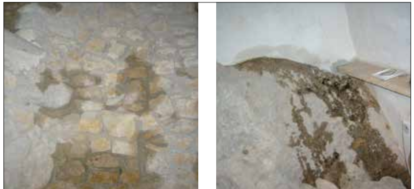
Fot. 2 | Przeziąkanie wód opadowych przez ścianę
