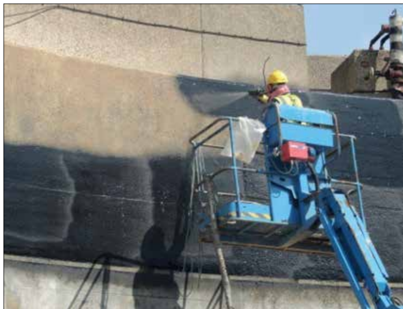
Fot. 8 | Aplikacja powłoki polimocznikowej w oczyszczalni
