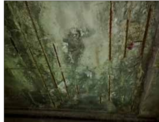
Fot. 3 | Braki otuliny na spodniej warstwie płyty
