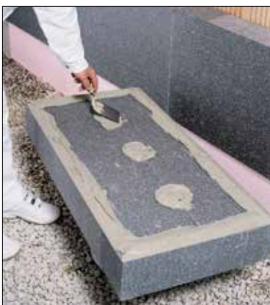
Fot. 2 | Nakładanie kleju na płytę styropianową metodą obwodowo-punktową
