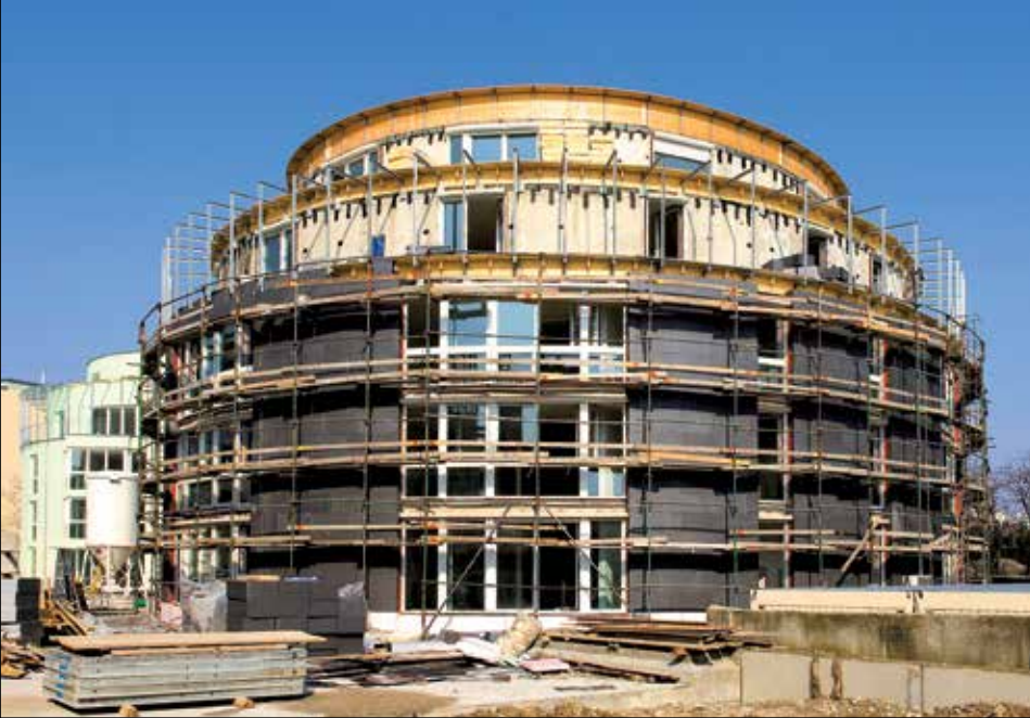
Fot. 1 | Ocieplanie fasady szarym styropianem
