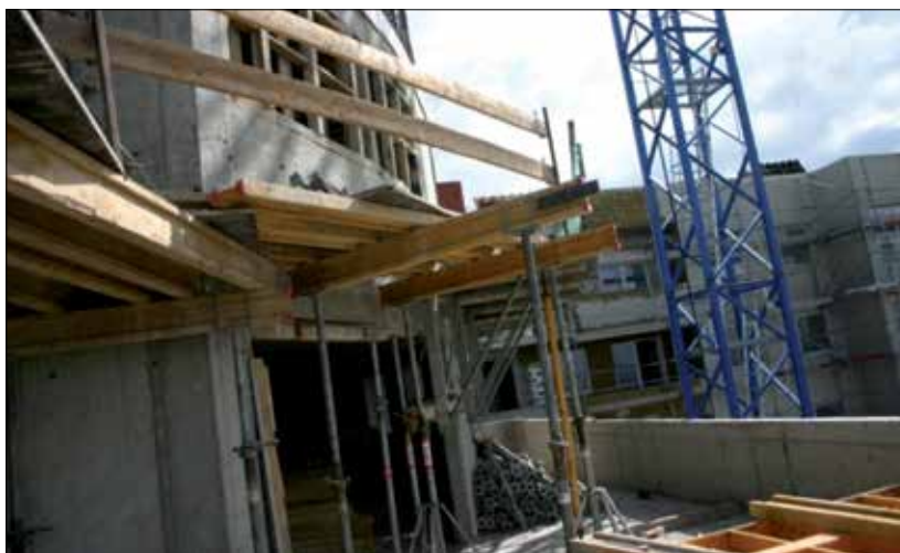
Fot. 1 | Pozorne zabezpieczenie przed upadkiem
