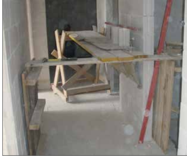
Fot. 5 | Brak rusztowania nie jest przeszkodą
