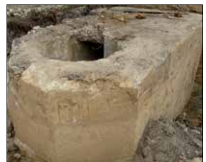
Fot. 11 | Odkryty podczas robót ziemnych w „ślądzie” torowiska schron bojowy typu Ringstand z czasów II wojny światowej
