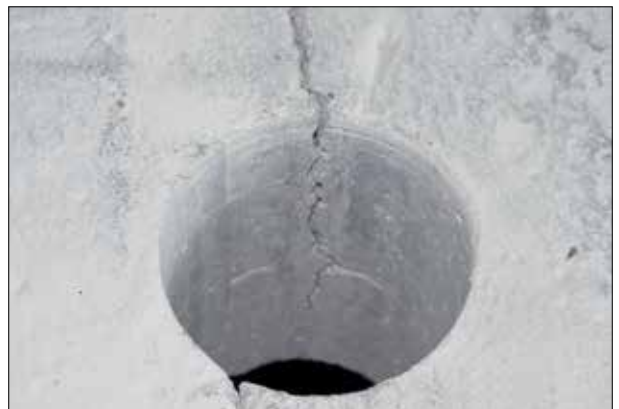
Fot. 2 | Brak pielęgnacji betonu spowodował rażące rysy skurczowe w stropie betonowym
