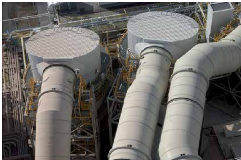
Fot. 5 | Kanały spalin z TWS odprowadzające mokre spaliny z absorberów do przewodów spalin w kominie
