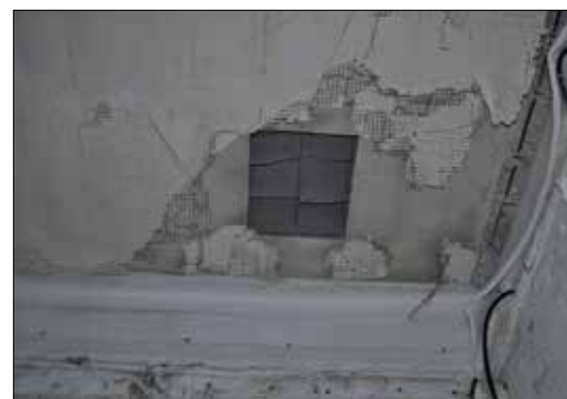
Fot. 1c | Strop jak na fot. 1a po 120 min oddziaływania standardowego. Widok od strony nagrzewanej (od strony pieca). Widoczne odpadnięcie dolnych ścianek pustaków
