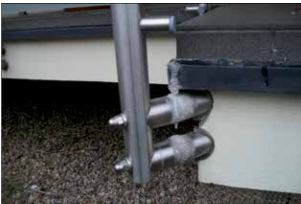
Fot. 1 | Płytki w obszarach zewnętrznych wymagają zastosowania pełnego systemu i wodoszczelności wszystkich styków
