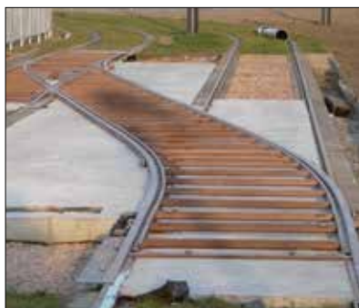
Fot. 14 | Tymczasowy rozjazd nakładkowy umożliwiający prowadzenie ruchu wahadłowego na wybranym odcinku bez konieczności używania pętli
