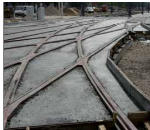
Fot. 1 | Rozjazd tramwajowy po zabetonowaniu wraz z przytwierdzeniami na prowadnicach
