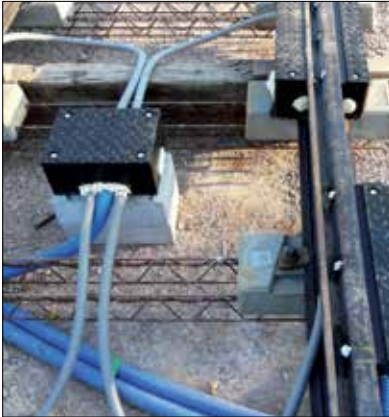
Fot. 2 | Elementy smarownicy torowej (widoczne otwory smarujące w szynach – białe punkty) przed zabetonowaniem warstwy podbudowy
