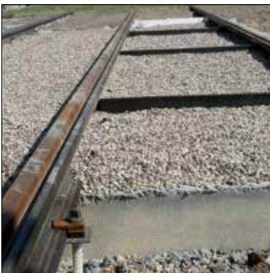
Fot. 3 | Konstrukcja torowiska przygotowana do wykonania zabudowy trawiastej (widoczna warstwa filtracyjna na płycie podbudowy, na dalszym planie już wykonana zabudowa trawiasta)
