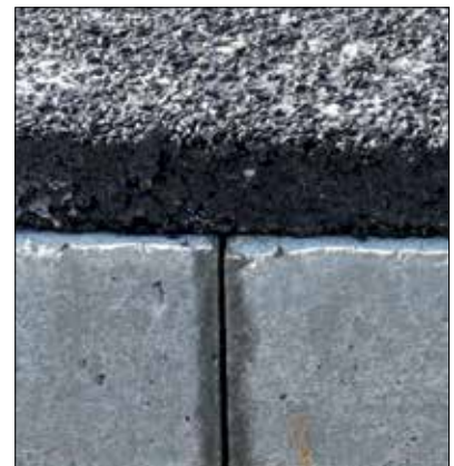
Fot. 5 | Warstwa ścieralna z asfaltu lanego na betonowej warstwie zabudowy torowiska (widoczna nacięta szczelina na skurczu)
