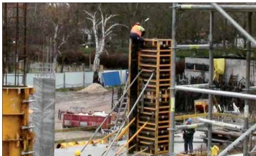
Fot. 4 | Brak sprzętu jest przyczyną niebezpiecznego zachowania
