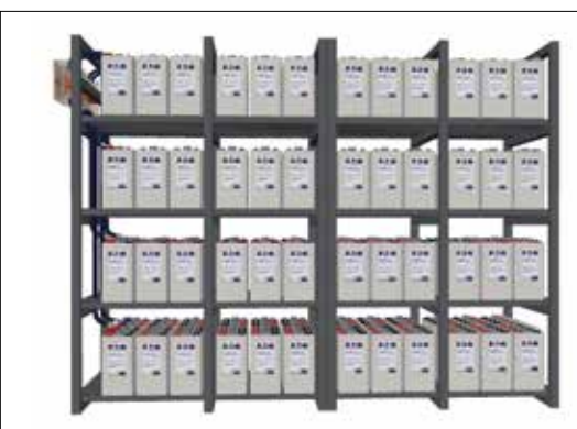
Fot. 2 | Bateria akumulatorów [16]
