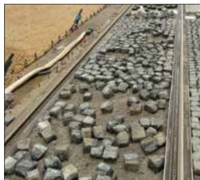
Fot. 9 | Uszkodzona zabudowa z kostki kamiennej przez zgarniacz tramwaju (roboty prowadzone podczas ruchu liniowego tramwajów)
