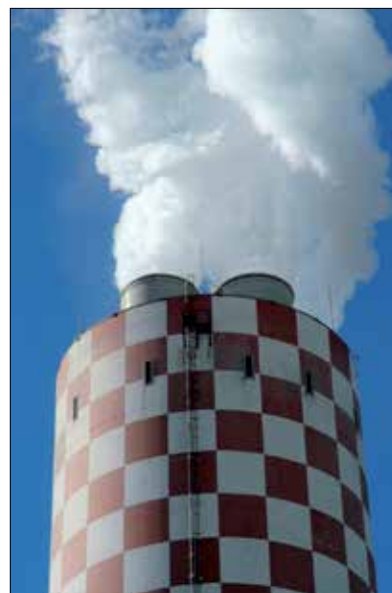
Fot. 2 | Wierzchołkowa partia żelbetowego kominu sześcioprzewodowego H = 150 m. Widoczne wyloty przewodów spalin z TWS
