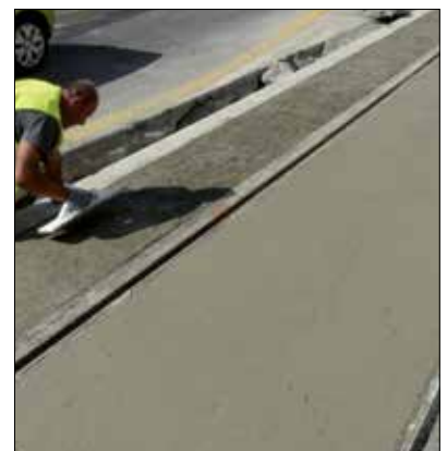
Fot. 7 | Wykonywanie zabudowy torowiska – warstwy ścieralnej z betonu cementowego
