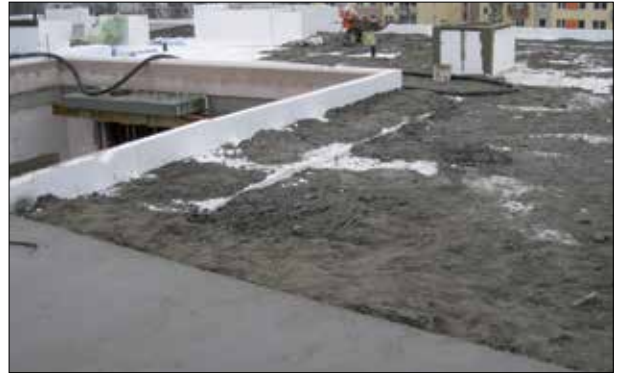
Fot. 2 | Przy okazji betonowania wykonawca wprowadza do stropodachu wodę a następnie całość uszczelni papą zgrzewalną
