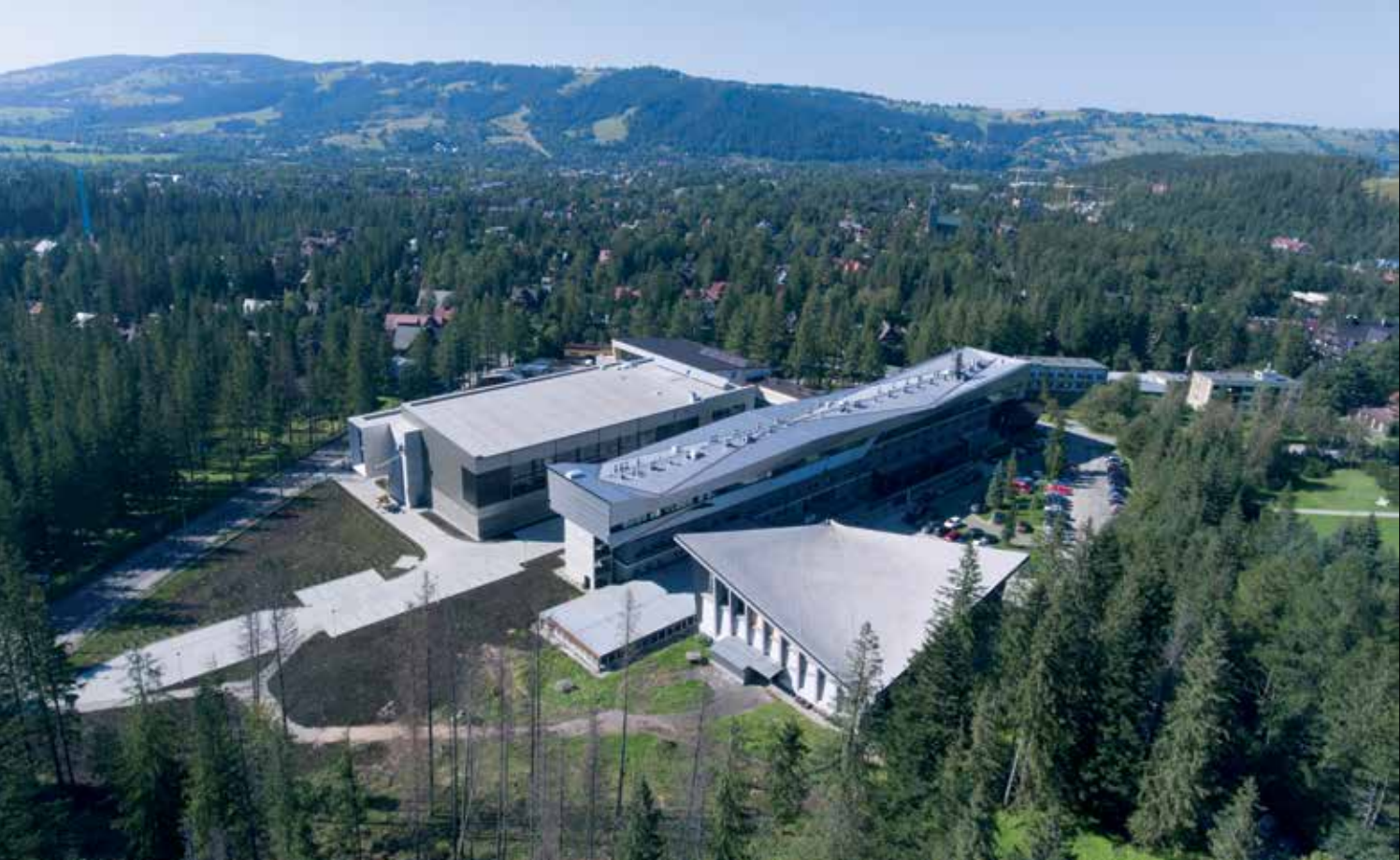
Fot.1 | Hala sportowa w Centralnym Ośrodku Sportu – Ośrodku Przygotowań Olimpijskich w Zakopanem
