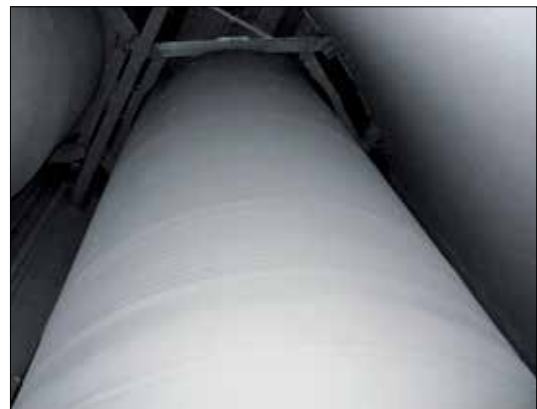
Fot. 3 | Przewód spalin z TWS w kominie sześcioprzewodowym
