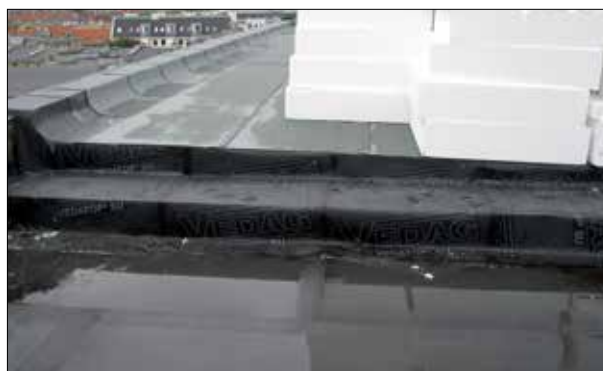
Fot. 5 | Warunkiem prawidłowego wykonania stropodachu pełnego jest wbudowanie termoizolacji w stanie suchym – w przypadku przerw roboczych należy termoizolację zabezpieczyć
