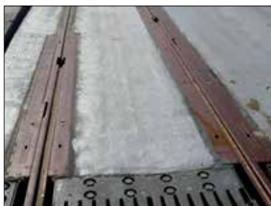
Fot. 15 | Dylatacja mostowa. Przyrząd wyrównawczy torowy umożliwiający przemieszczenie w nieciągłości toków szynowych o wartości ok. 600 mm (długość mostu między dylatacjami 795 m). Zastosowane niesymetryczne przyrządy wyrównawcze w tokach jednego toru w celu zachowania prowadzenia zestawu kołowego za pomocą jednej szyny w miejscu nieciągłości przyległej szyny
