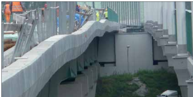
Fot. 13 | Po lewej: deformacja mostu tramwajowego – konieczna korekta niwelety torów, po prawej: most drogowy
