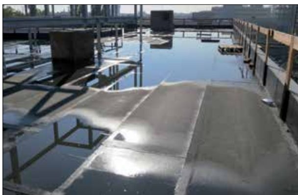
Fot. 4 | Podczas budowy papa paroizolacyjna pełni funkcję papy wstępnego krycia
