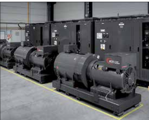
Fot. 4 | Dynamiczne zasilacze RUPS firmy IEM Power Systems. Po lewej stronie urządzenia zasobnik energii kinetycznej z kołem zamachowym, po prawej – prądnicą synchroniczną [13]
