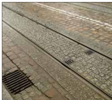
Fot. 8 | Zabudowa torów i jezdni z kostki kamiennej ze skrzynkami odwadniającymi zabudowę torowiska i rowki szyn
