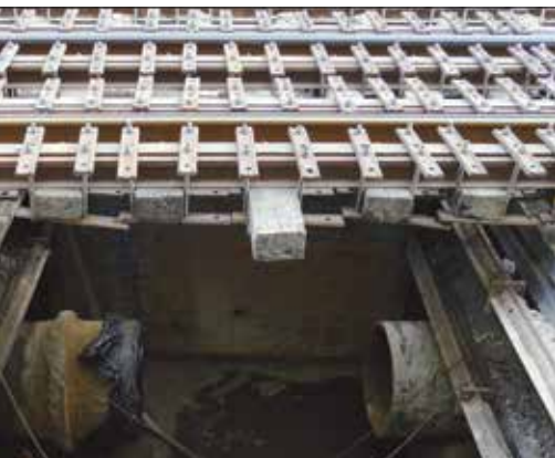
Fot. 12 | Renowacja przewodu wodociągowego pod czynnymi torami tramwajowymi z konstrukcją odciążającą
