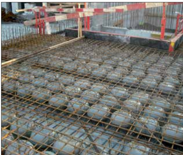
Fot. 3 | Strop żelbetowy z wypełnieniami typu cobiax
