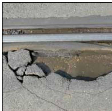
Fot. 6 | Zabudowa torowiska w postaci płyty z betonu cementowego i asfaltu lanego (uszkodzenia po trzech latach intensywnego obciążenia autobusowego)
