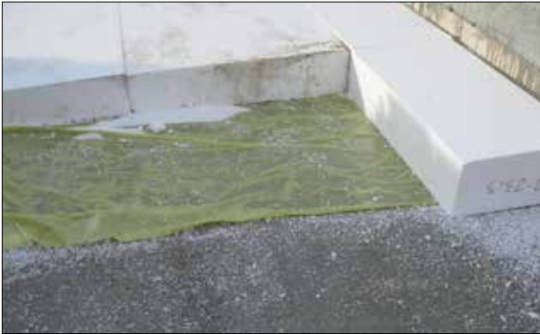
Fot. 1 | Folia PE nie zabezpieczy przed degradacją termoizolacji stropodachu niewentylowanego w warunkach budynku mieszkalnego
