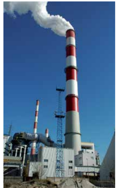
Fot. 4 | Jednoprzewodowy komin żelbetowy H = 196,5 m z wykładziną wewnętrzną z piankowego szkła borokrzemianowego zaaplikowaną na wewnętrzną powierzchnię trzonu
