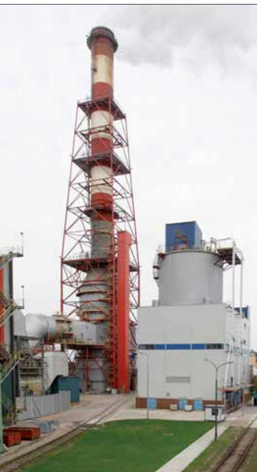
Fot. 1 | Komin mokry z przewodem spalin z TWS (H = 78,5 m, D = 7,0 m) posadowionym na absorberze
