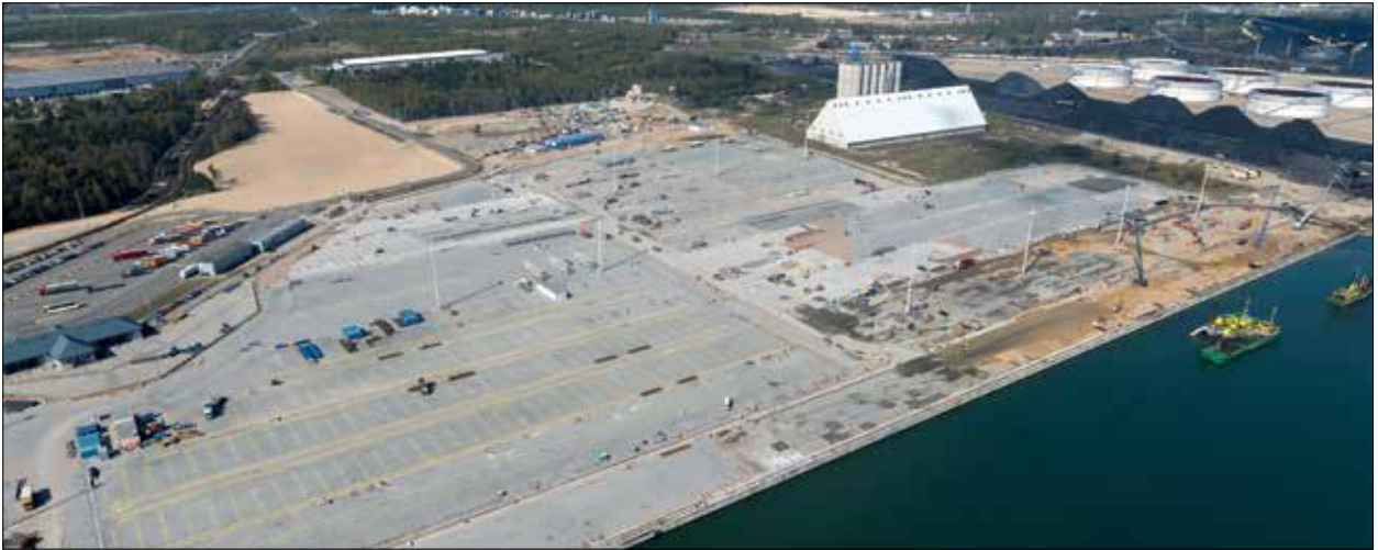
Fot. 4 | Terminal Kontenerowy DCT2 w Gdańsku
