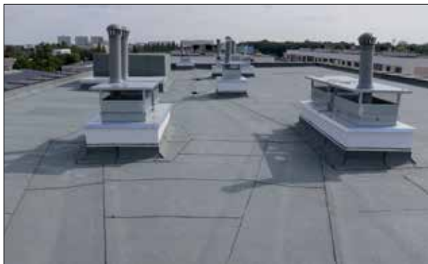
Fot. 3 | Spadki stropodachu pełnego prawidłowo kształtuje się w warstwie termoizolacji
