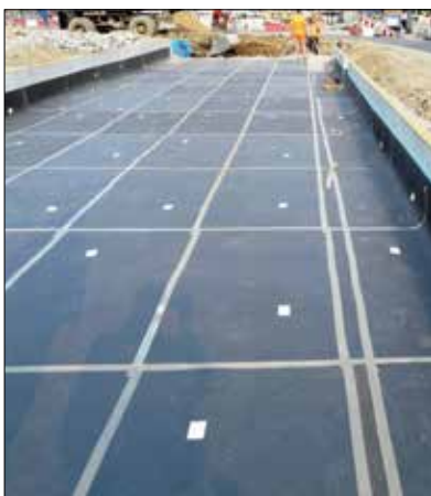
Fot. 10 | Mata wibroizolacyjna przygotowana do wykonania na niej betonowej płyty podbudowy torowiska
