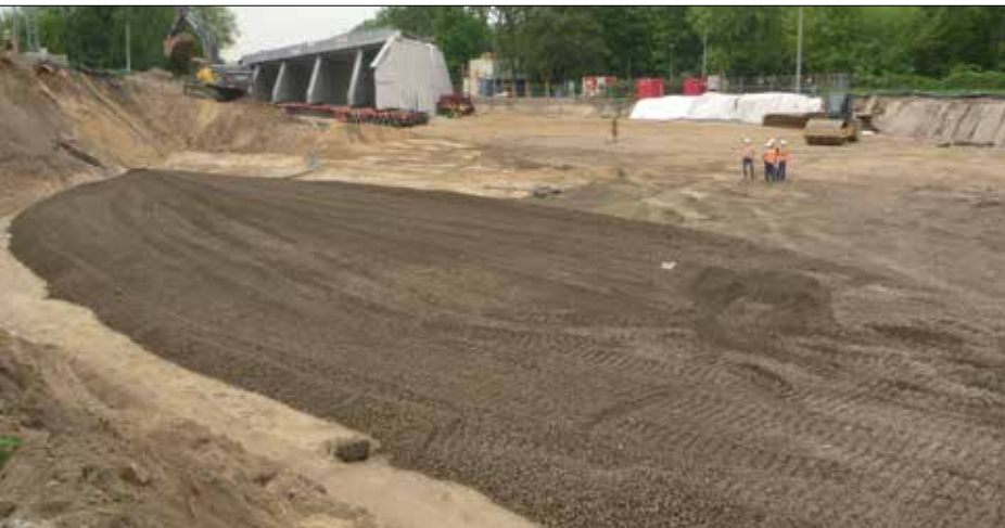
Fot. 4 | Przygotowanie miejsca docelowego i drogi tymczasowej przed transportem tunelu TK-1
