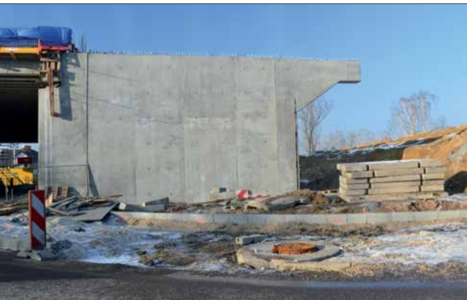
Fot. 1 | Obiekt mostowy wykonany w całości przed wykonaniem nasypów
