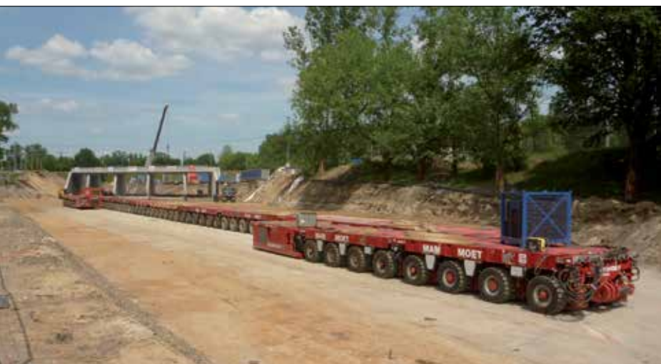
Fot. 5 | Demobilizacja sprzętu firmy Mammoet. Na pierwszym planie wózki SPMT w miejscu prefabrykacji tunelu TK-1, w oddali tunel w miejscu docelowym
