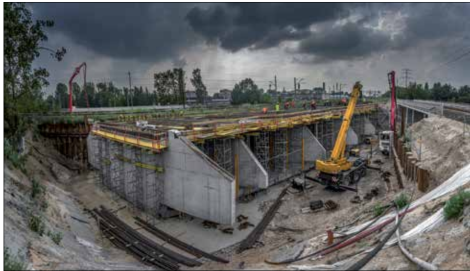
Fot. 3 | Tunel TK-2 w trakcie budowy w miejscu tymczasowym (fot. T. Mościcki)
