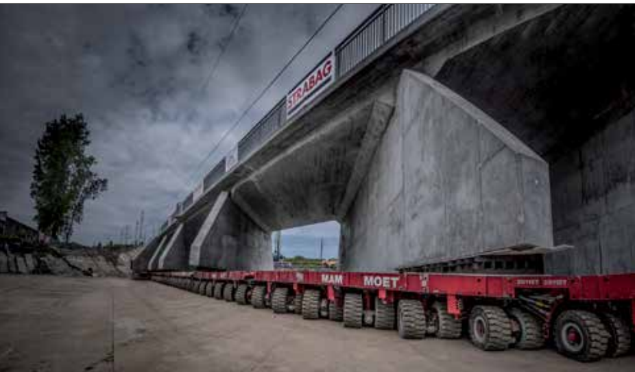
Fot. 1 | Tunel TK-1 oparty na wózkach SPMT (fot. T. Mościcki)
