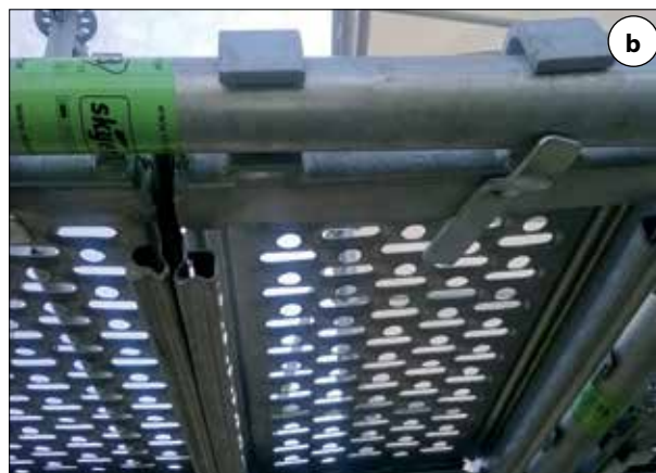
Fot. 2 | Informacja o posiadanym certyfikacie bezpieczeństwa „B” umieszczana na elementach rusztowań modułowych SKYER: a) oznakowanie stojaka – rok produkcji 05; b) oznakowanie podestu – rok i oznaczenie producenta
