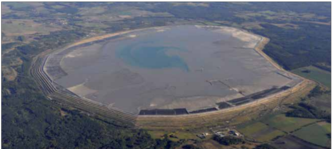
Fot. 1 Ogólny widok Obiektu Unieszkodliwiania Odpadów Wydobywczych „Żelazny Most” w Rudnej
