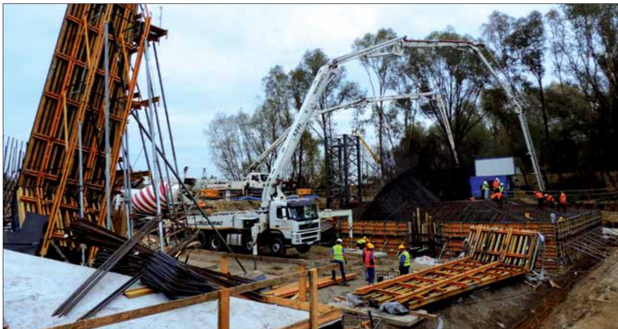
Fot. 1 | Deskowanie używane na budowie mostu Tadeusza Mazowieckiego w Rzeszowie (fot. S. Słonina)
