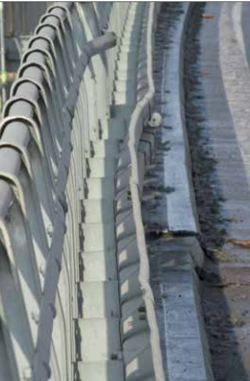
Fot. 3 | Przykład przemieszczenia podpory wiaduktu prostopadle do osi drogi
