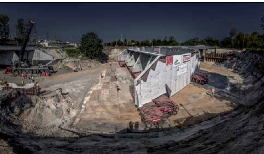
Fot. 2 | Tunel TK-2 w trakcie transportu (fot. T. Mościcki)
