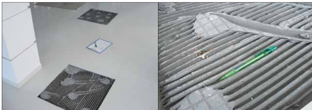
Fot. 2 i 3 | Płyty wielkoformatowe bezwzględnie wymagają przyklejenia na pełne podparcie. Pokazany błąd (przyklejanie na grzebieniu) jest niedopuszczalny (fot. Atlas)
