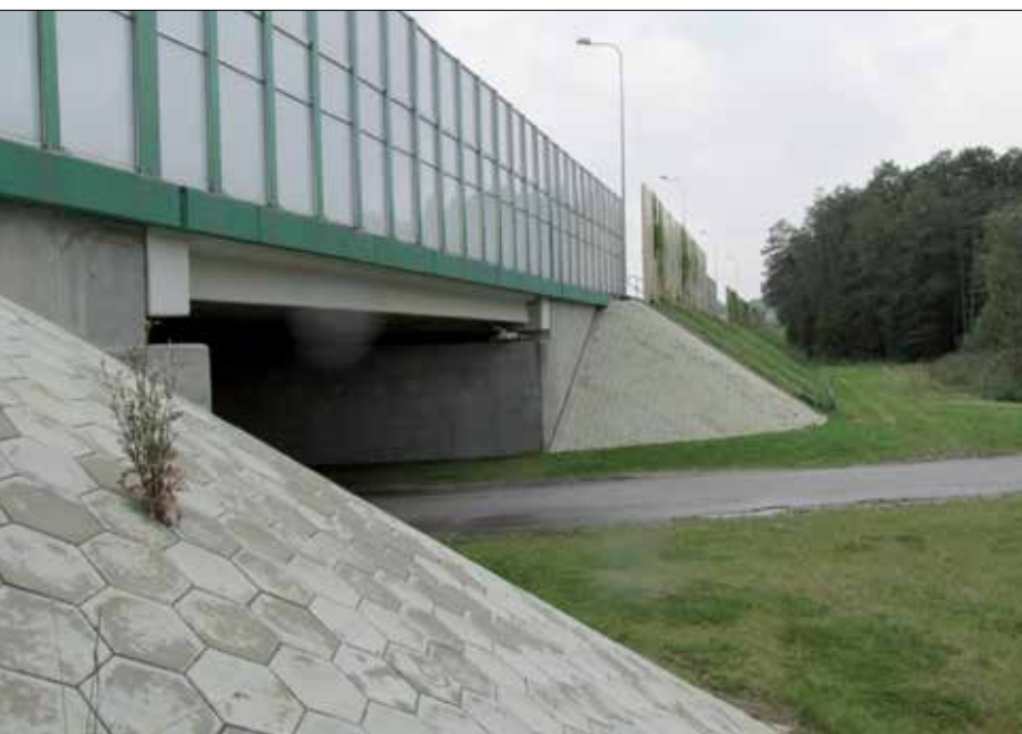
Fot. 4 | Obiekt wykonywany metodą półkową w trudnych warunkach
