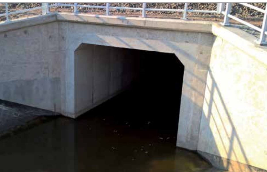
Fot. 6 | Przepust wbudowany w nasyp
