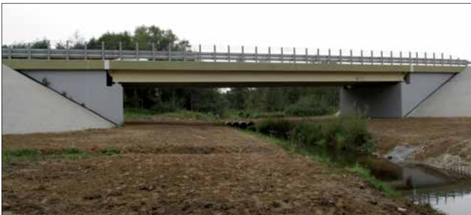
Fot. 2 | Most posadowiony na palach
