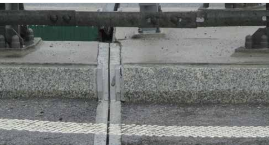
Fot. 5 | Zaciśnięta dylatacja wiaduktu
