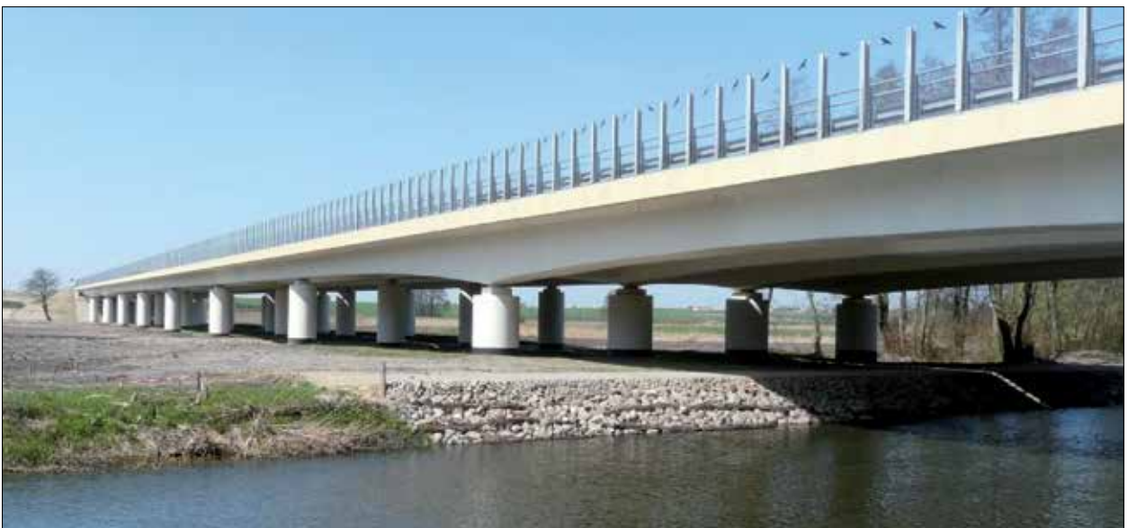
Fot. 4 | Obiekt E1 w ciągu DK-10 (obwodnica Stargardu Szczecińskiego), zrealizowana estakada (fot. Stanisław Wardzała)
