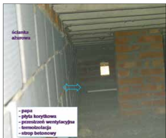
Fot. 1 Wentylowany dach płaski
