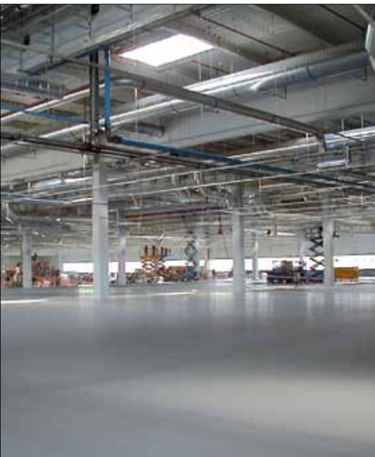
Fot. 1 Przykład posadzki mineralnej wykonanej w technologii suchej posypki DST (fot. autor)
