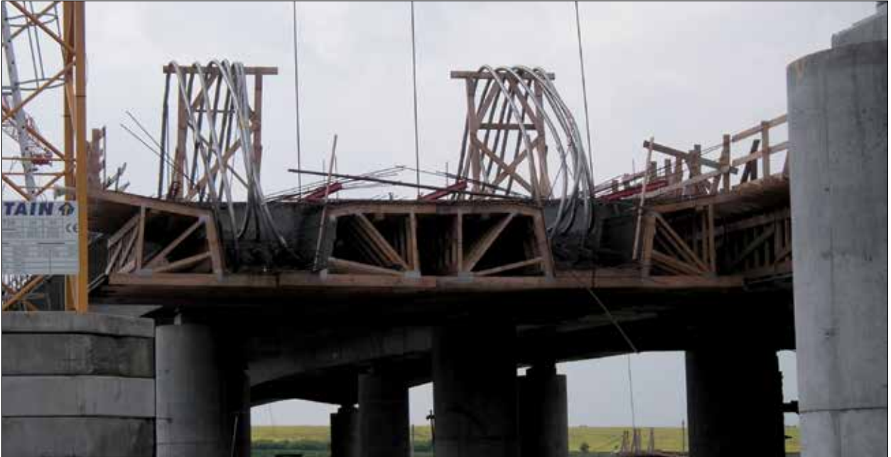
Fot. 3 | Obiekt E1 w ciągu DK-10 (obwodnica Stargardu Szczecińskiego). Styk technologiczny, widoczne wygięcie kabli przeprowadzanych wg zasady „na zakład”, ok. 50% kabli było łączonych w styku technologicznym (fot. Stanisław Wardzała)
