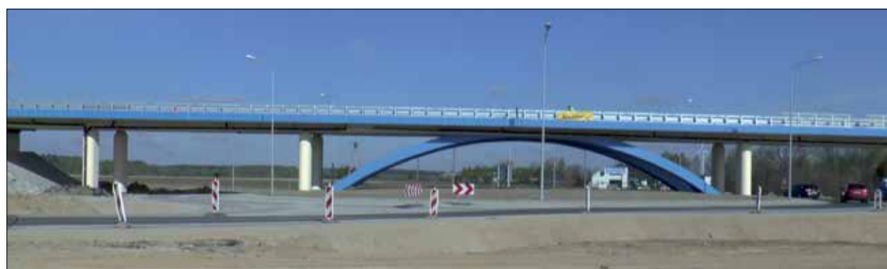
Fot. 2 | Obwodnica Bełchatowa, wiadukt WA-4 (fot. Piotr Szaro)
