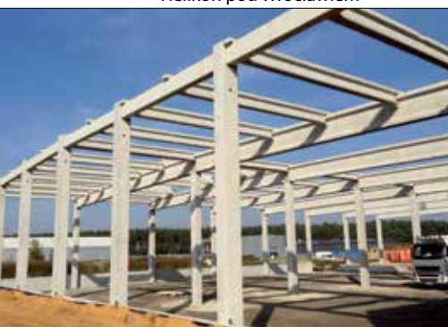
Fot. 2 | Budowa prefabrykowanej hali Helikon pod Wrocławiem
