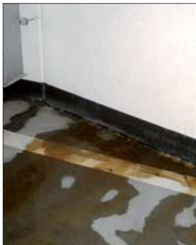
Fot. 5 | Wyciek wody z połączenia ściana garażu- płyta denna
