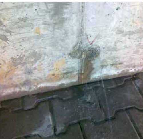
Fot. 2 | Intensywny wyciek wody gruntowej z korka szalunkowego
