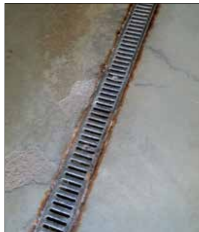
Fot. 6 | Ślady korozji rusztu wskazują na długotrwałe zaleganie wody w linii koryta
