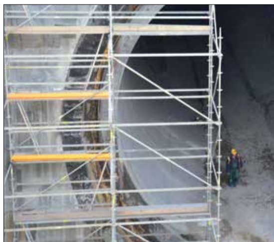
Fot. 6 | Specjalna konstrukcja stalowa w miejscu wejścia tarczy do komory odbiorczej
