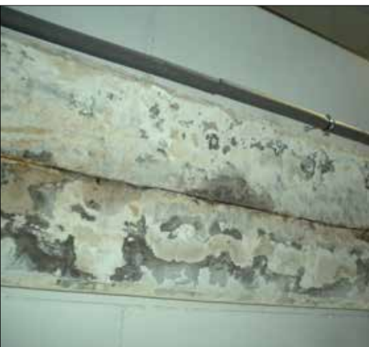
Fot. 1 | Wycieki wody z dylatacji konstrukcyjnej stropu
