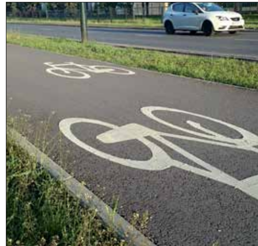
Fot. 1 | Asfaltowa nawierzchnia drogi rowerowej
