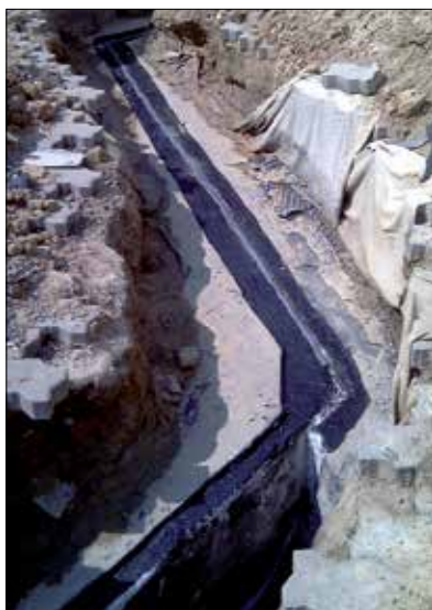
Fot. 12 | Dylatacja konstrukcyjna
