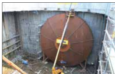
Fot. 6 | Specjalna konstrukcja stalowa w miejscu wejścia tarczy do komory odbiorczej
