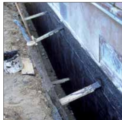
Fot. 16 | Odkrywka strefy ścian fundamentowych i wykonanie izolacji
