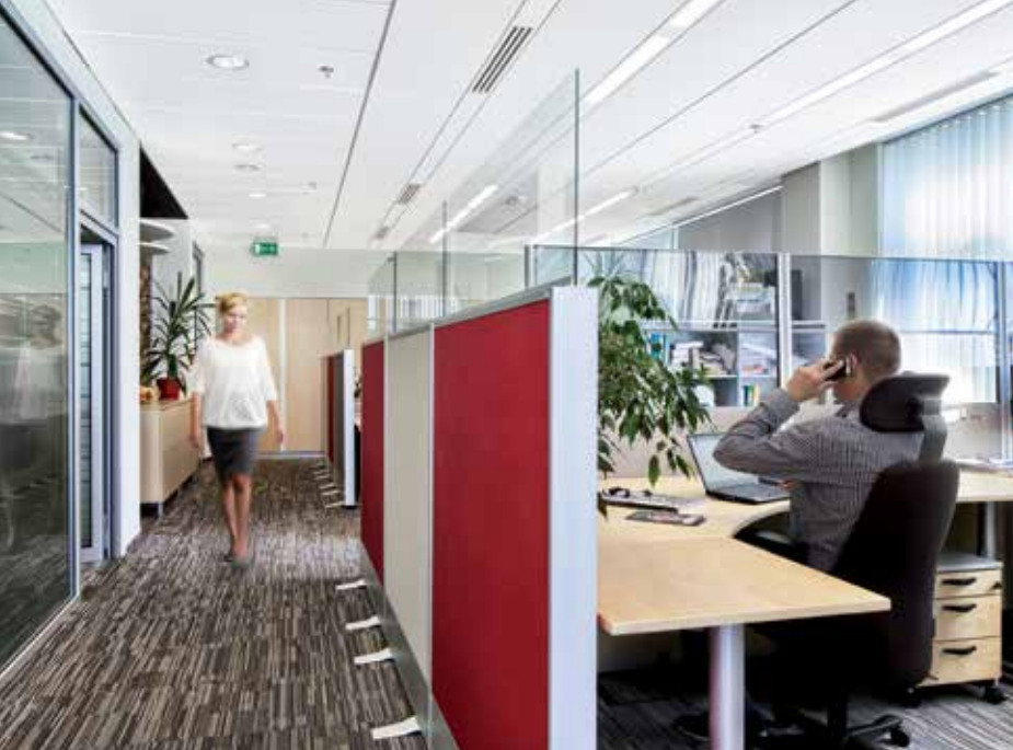
Fot. 3 | Małe biuro typu open space. Chłonność akustyczna odniesiona do powierzchni podłogi waha się w przedziale 1,3–1,7 (dla zakresu częstotliwości 500–2000 Hz). Materiały dźwiękochłonne o współczynniku \alpha_w \geq 0,90 rozmieszczone na suficie, częściowo na ścianach oraz na wolno stojących ekranach (fot. Ecophon)
