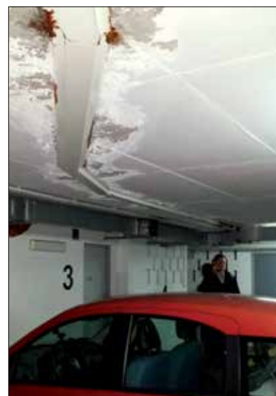
Fot. 9 | Wyciek soli budowlanych na pojazdy – prowizoryczne zabezpieczenie
