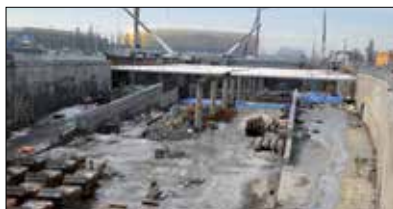
Fot. 8 | Konstrukcja dojazdów do tunelu
