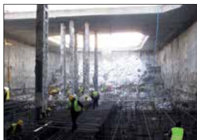
Fot. 9 | Płyta denna kotwiona w najgłębszej części dojazdów do tunelu
