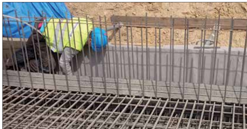
Fot. 1 | Montaż produktu Hydrostop-Mata Penetrująca
