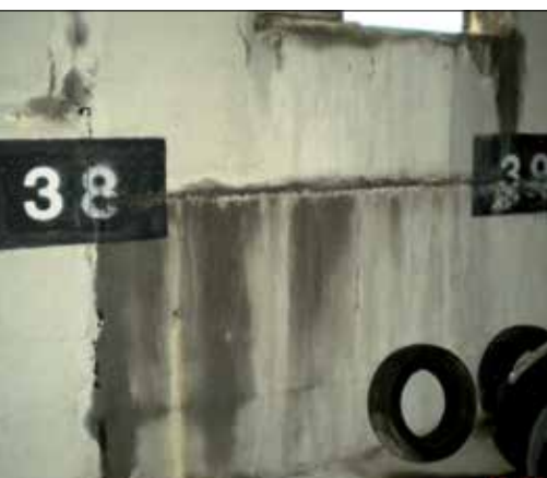
Fot. 4 | Przenikanie wody przez tzw. szew roboczy w ścianie
