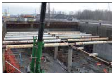
Fot. 10 | Po prawej stronie rozpory opierają się jeszcze na ścianie szczelinowej i jednocześnie widoczne jest zbrojenie dodatkowej ściany osłonowej
