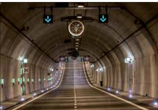
Fot. 1 | Widok gotowego tunelu (fot. A. Ceyrowski)
