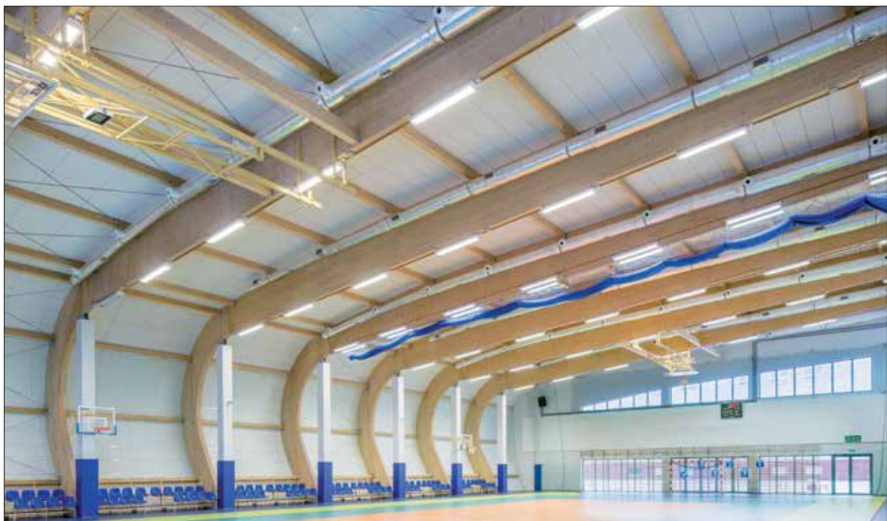
Fot. 2 | Gminna hala sportowa w Bezedach. Przykład hali sportowej spełniającej wymagania normy. Materiały dźwiękochłonne rozmieszczone między dźwigarami i płatwiami z drewna klejonego oraz na ścianie szczytowej pomieszczenia (fot. Ecophon)
