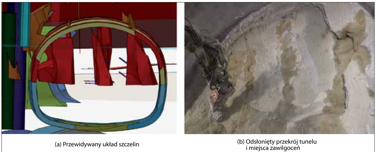
Rys. 10 | Porównanie prognozowanego układu szczelin w płaszczu ochronnym tunelu z sytuacją rzeczywistą. Największe ryzyko stwarzały szczeliny w piaskach i żwirach, występujące poniżej poziomu wody gruntowej, a najmniejsze soczewki niezwiązanego gruntu, całkowicie otoczone materiałem Soilcrete i zlokalizowane powyżej poziomu wody gruntowej
