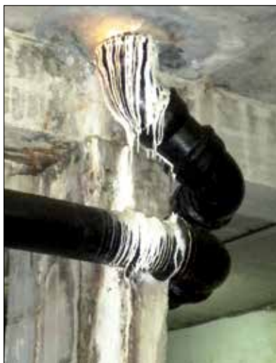
Fot. 10 | Brak szczelności tzw. rurażu
