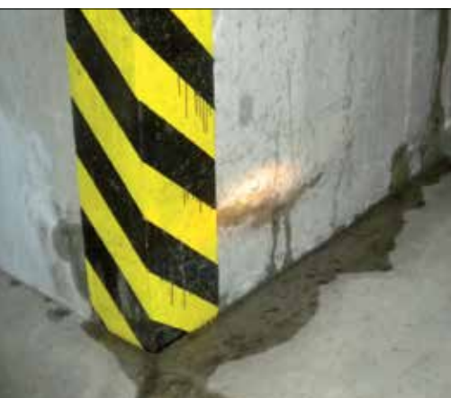
Fot. 3 | Wyciek wody z rysy w ścianie żelbetowej
