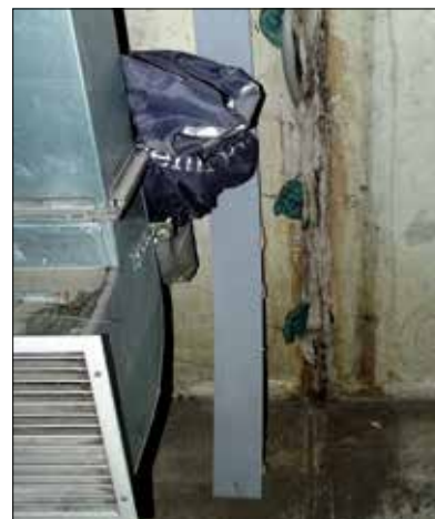
Fot. 15 | Wypukane przez zgromadzoną wodę uszczelnienie masą szczeliny dylatacji od wewnątrz
