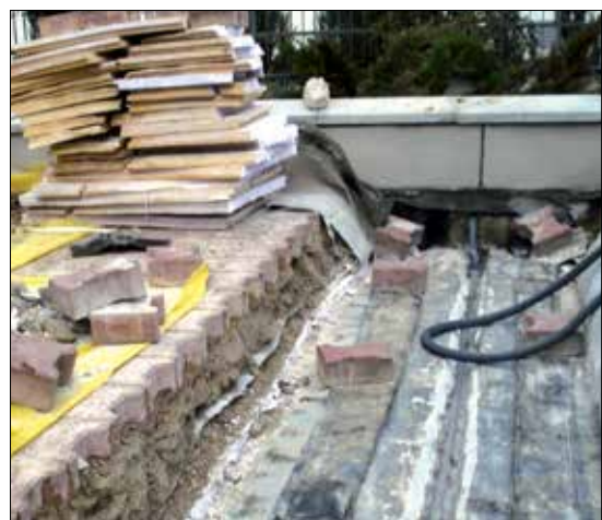
Fot. 11 | Dylatacja konstrukcyjna – naprawa od naporu wody
