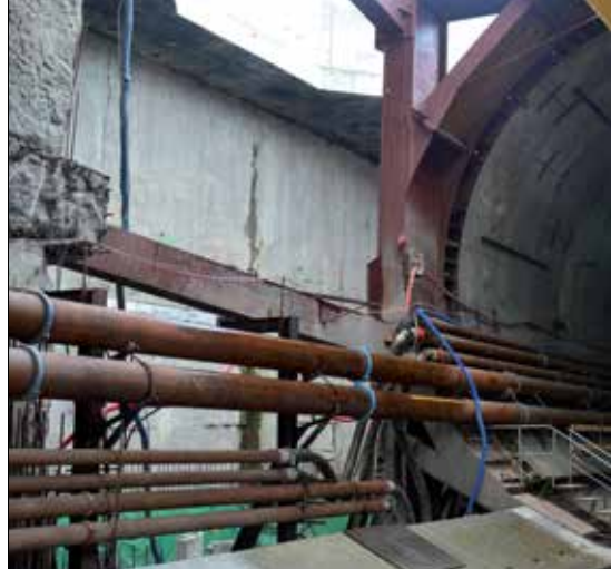
Fot. 3 | Początkowy fragment obudowy z ramą stalową umożliwiającą start pracy tarczy
