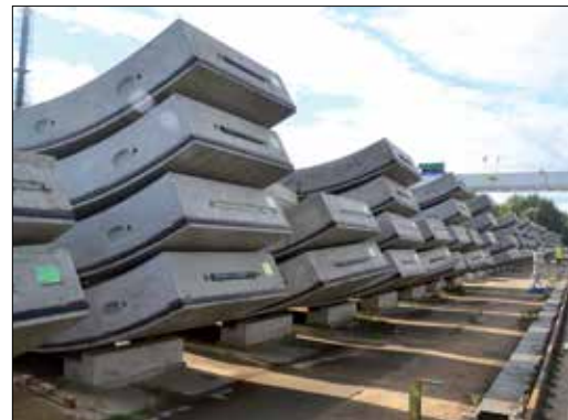
Fot. 2 | Prefabrykowane elementy obudowy tunelu, widoczna wielkość elementów w porównaniu z człowiekiem
