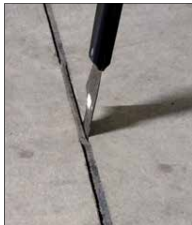
Fot. 7 | Rozszczelnione dylatacje
