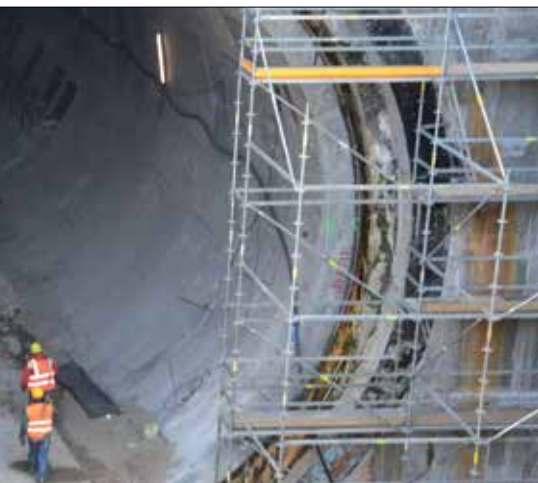
Fot. 10 | Po prawej stronie rozpory opierają się jeszcze na ścianie szczelinowej i jednocześnie widoczne jest zbrojenie dodatkowej ściany osłonowej
