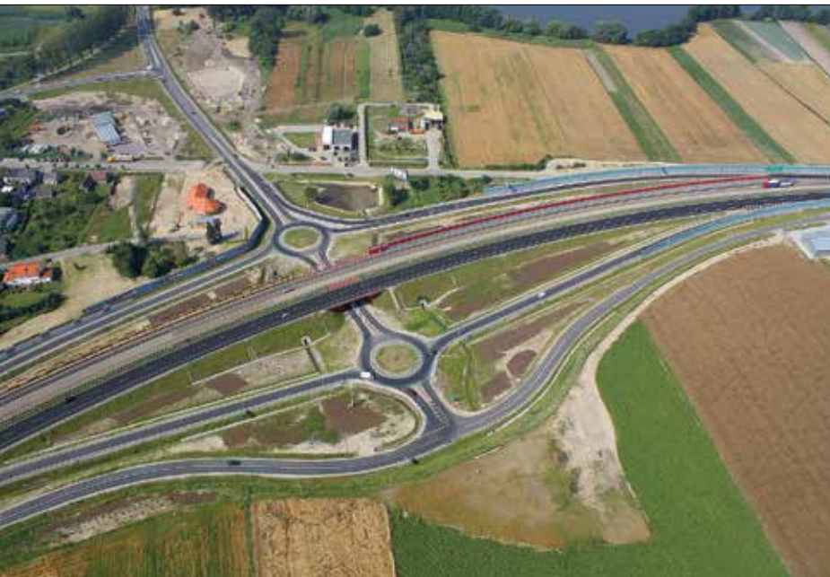
Węzeł na drodze ekspresowej S11 Poznań–Kórnik (fot. Artur Gajdziński/archiwum Transprojektu Warszawa)
