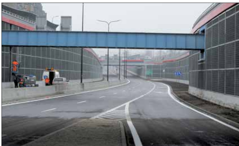
Fot. 6 | Ściany oporowe dojazdu do tunelu i innych obiektów inżynierskich
