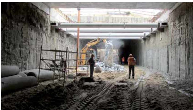
Fot. 5 | Otwór technologiczny w stropie tunelu w czasie budowy służący do ewakuacji urobku
