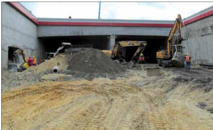
Fot. 4 | Wjazd do tunelu w czasie budowy
