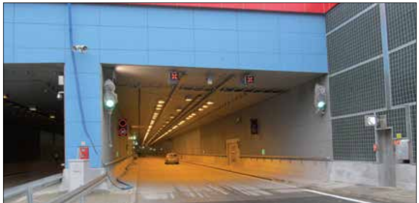
Fot. 1 | Portal wjazdowy do tunelu od strony Katowic
