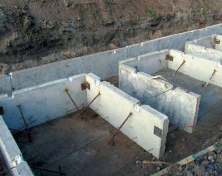
Fot. 7 | Murki prowadzące ścian teowych
