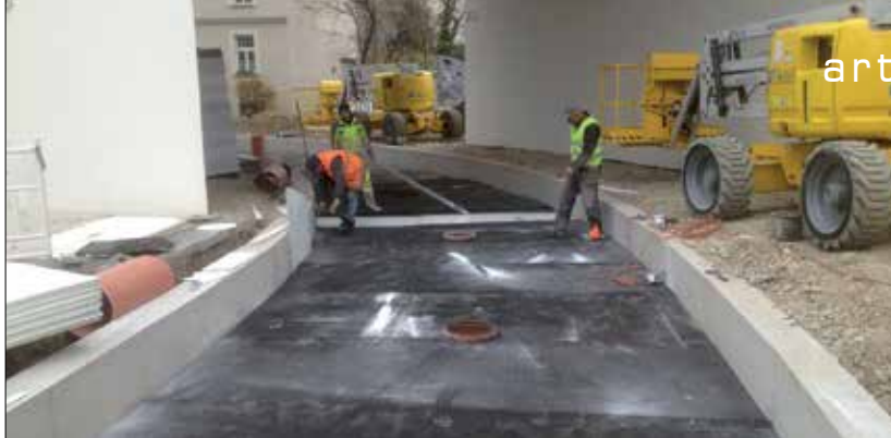
Fot. 1 Widok ogólny konstrukcji w trakcie montażu mat
