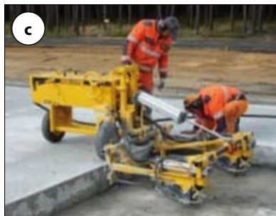
Fot. 2 | Wymiana płyty betonowej nawierzchni: a) nacięcie uszkodzonej płyty; b) mechaniczne usuwanie betonu; c) wiercenie otworów pod kotwy i dyble; d) wbudowywanie mieszanki betonowej (archiwum TPA)
