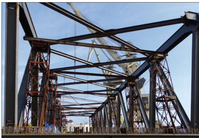
Fot. 3 | Scalanie konstrukcji stalowej
