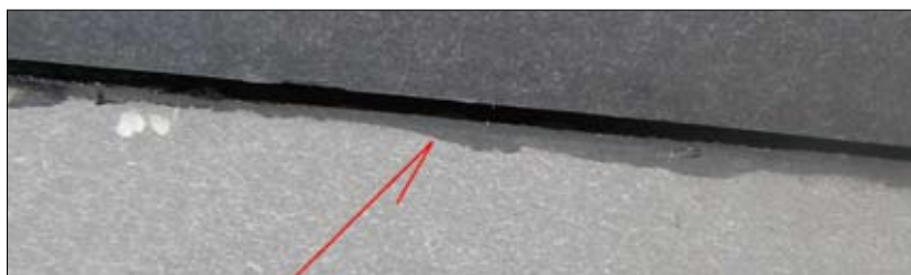
Fot. 3 | Fragment płyt włóknisto-cementowych, których krawędzie poddano obróbce niewłaściwymi narzędziami
