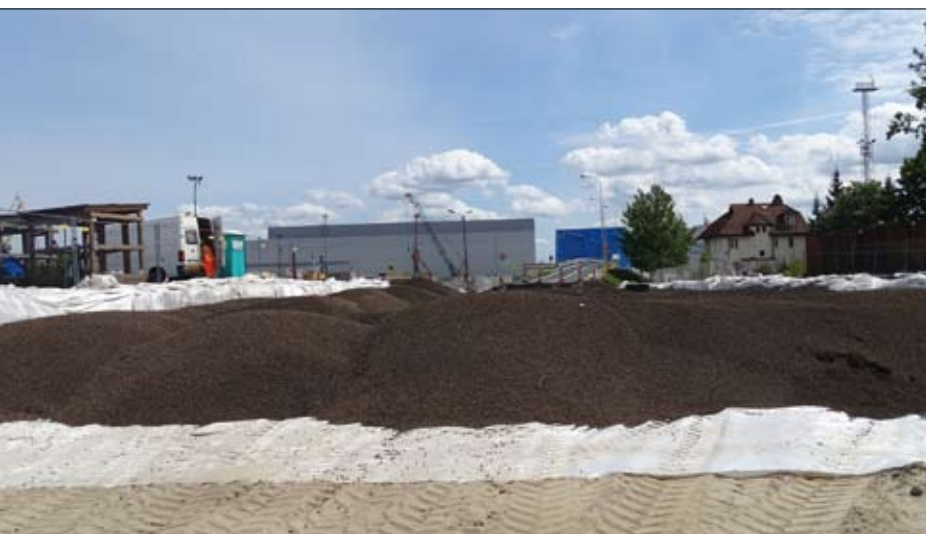
Fot. 5 | Etap II – realizacja drogi dojazdowej za pomocą materaca z keramzytu
