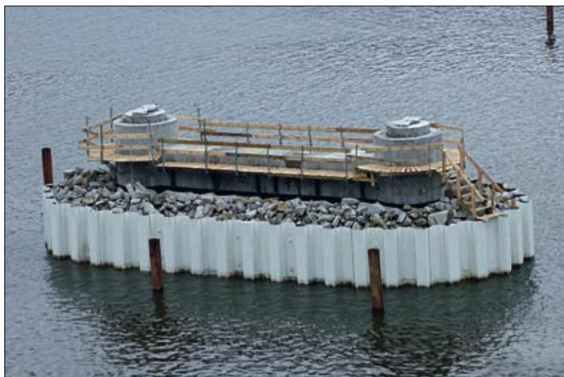
Fot. 2 | Gotowa podpora nurtowa z widocznymi ściankami szczelnymi i narzutem kamiennym
