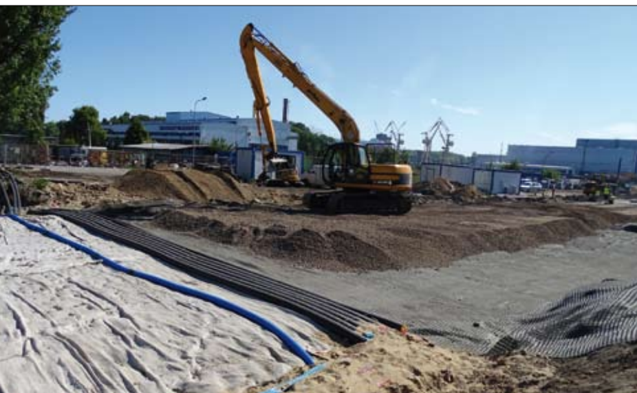
Fot. 6 | Układanie materaca z kruszywa łamanego w geosiatce na materacu z keramzytu w geotkaninie
