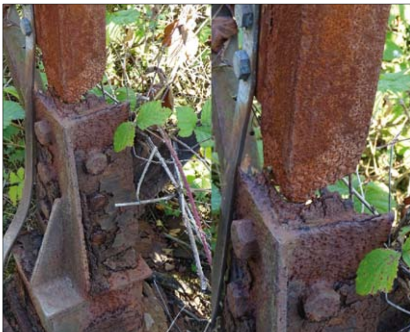
Fot. 1 | Uszkodzenia słupa serii Sc120
