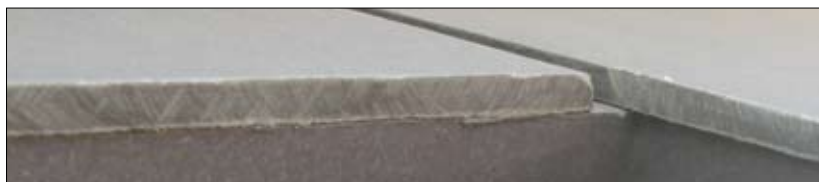
Fot. 2 | Niewłaściwe cięcie płyt włóknisto-cementowych powodujące uszkodzenie krawędzi okładzin
