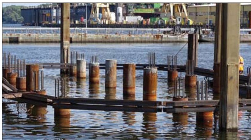
Fot. 1 | Podpora nurtowa – widok wykonanych pali Tubex oraz zamontowanego kleszcza
