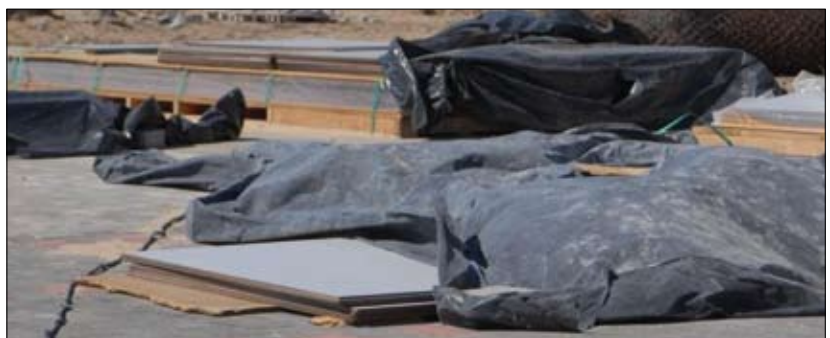
Fot. 1 | Niewłaściwe składowanie płyt HPL na placu budowy
