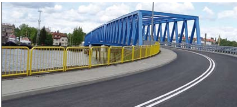
Fot. 7 | Droga dojazdowa do Mostu Brdowskiego
