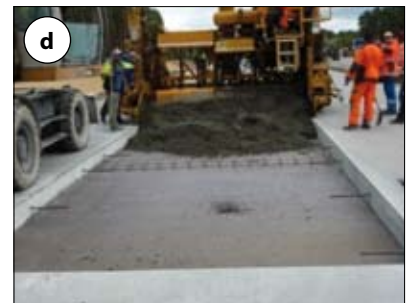
Fot. 2 | Wymiana płyty betonowej nawierzchni: a) nacięcie uszkodzonej płyty; b) mechaniczne usuwanie betonu; c) wiercenie otworów pod kotwy i dyble; d) wbudowywanie mieszanki betonowej (archiwum TPA)
