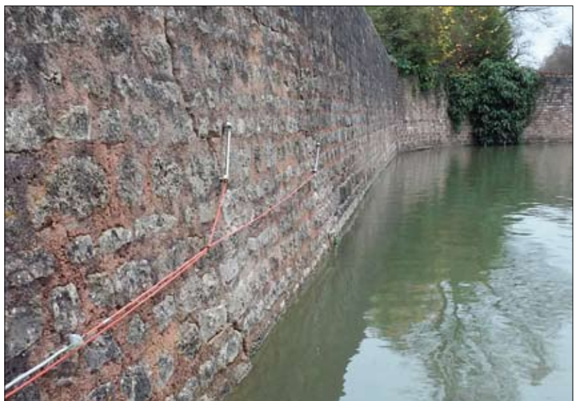
Fot. 4 | Zastosowanie monitoringu światłowodowego w zamku we Francji
