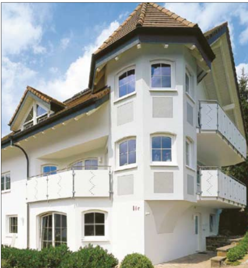
Fot. 2 | Elewacja budynku jednorodzinnego z zastosowaniem systemu Sto Solar (Stühlingen, Niemcy) [4]
