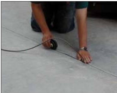
Fot. 1 | Wypełnianie szczelin skurczowych (fot. autor)
