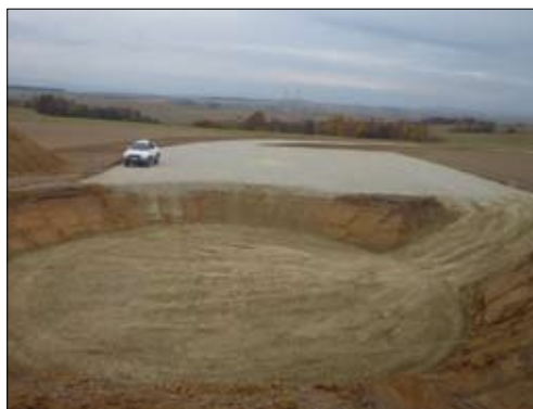
Fot. 3 | Przygotowany dojazd wraz z placem montażowym oraz wykopem pod fundament. W wykopie podłoże przygotowane pod maszynę wykonującą wzmocnienie podłoża kolumnami DSM
