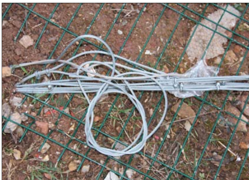
Fot. 4 | Stan lin odciągów w zakotwieniu po awarii
