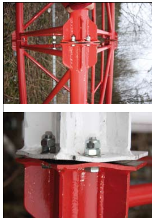
Fot. 2 | Uszkodzone połączenia kołnierzowe
