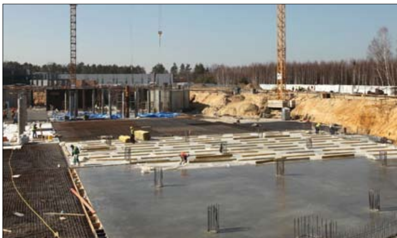
Pielęgnacja płyty betonowej poprzez przykrywanie warstwami mat i folii
