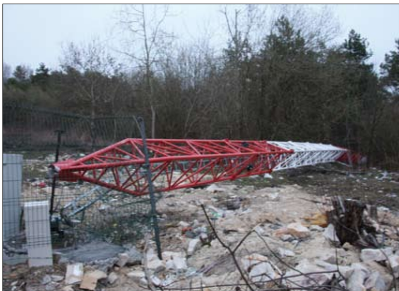
Fot. 1 | Aluminiowy maszt telekomunikacyjny M100F o wysokości 80,0 m tuż po katastrofie
