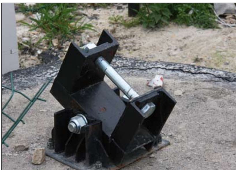
Fot. 5 | Stan podpory masztu po awarii
