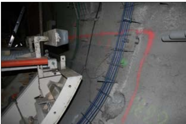
Fot. 3 | Pomiar temperatury i naprężeń w sekcji tunelu wraz z pomiarem odkształceń w świeżym betonie (ciepło/wycofania/konwergencja) (archiwum Cementys®)
