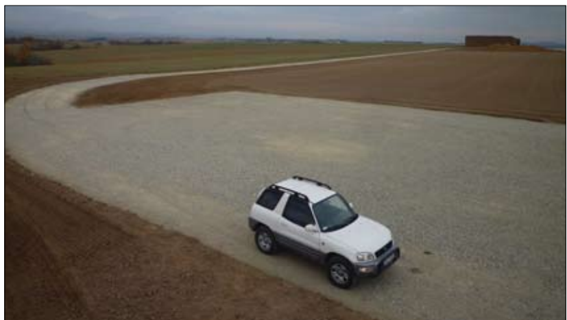
Fot. 2 | Przygotowany dojazd wraz z placem montażowym
