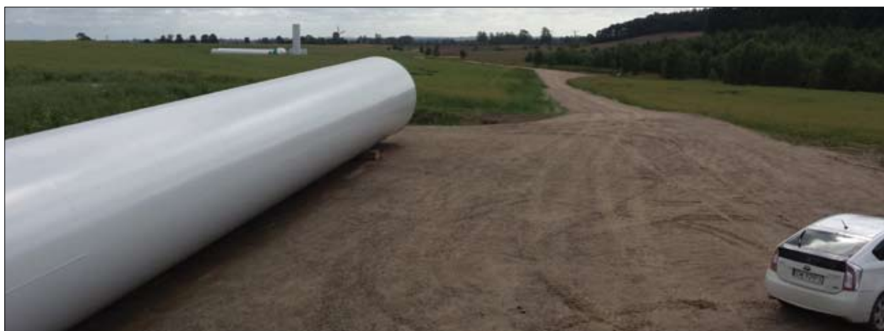
Fot. 5 | Plac montażowy ze składowanym segmentem wieży
