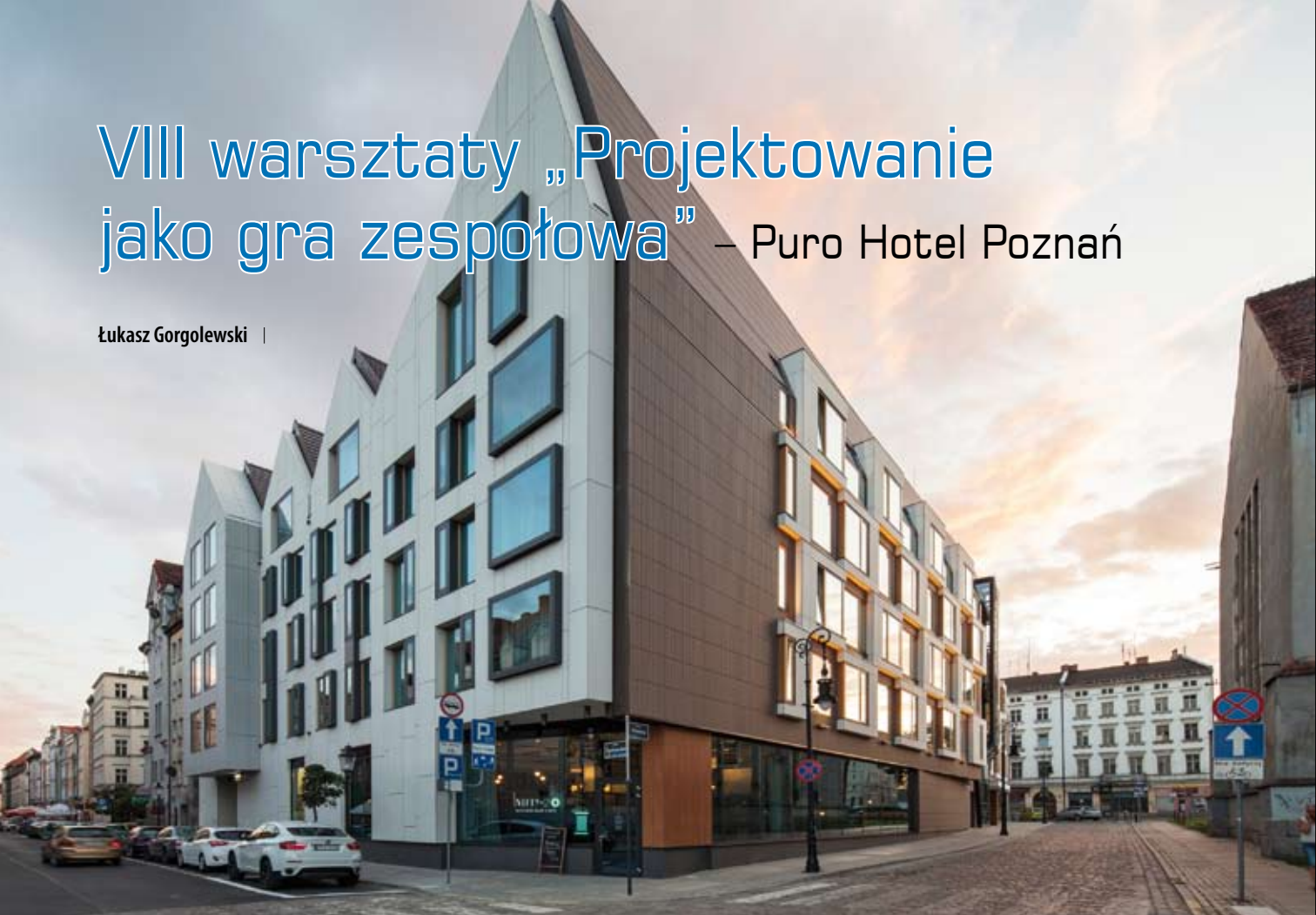
Fot. 1 | Puro Hotel Poznań – elewacje ul. Żydowskiej/Stawnej, po prawej dawna synagoga (fot. A. Grzegorzczak FOTOARCHITEKTURA)
