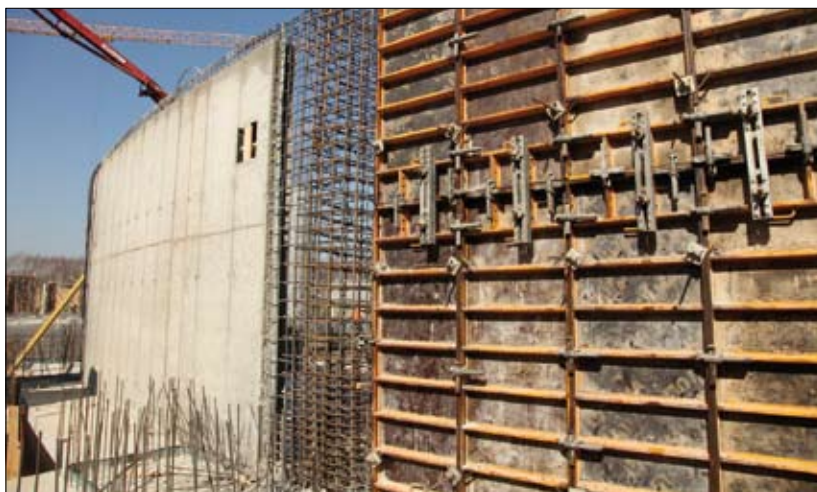
Szalunki ścienne łączone ściągami B15
