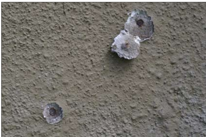
Fot. 4 | Korozja gwoździ stalowych przytrzymujących siatkę zbrojeniową [1]
