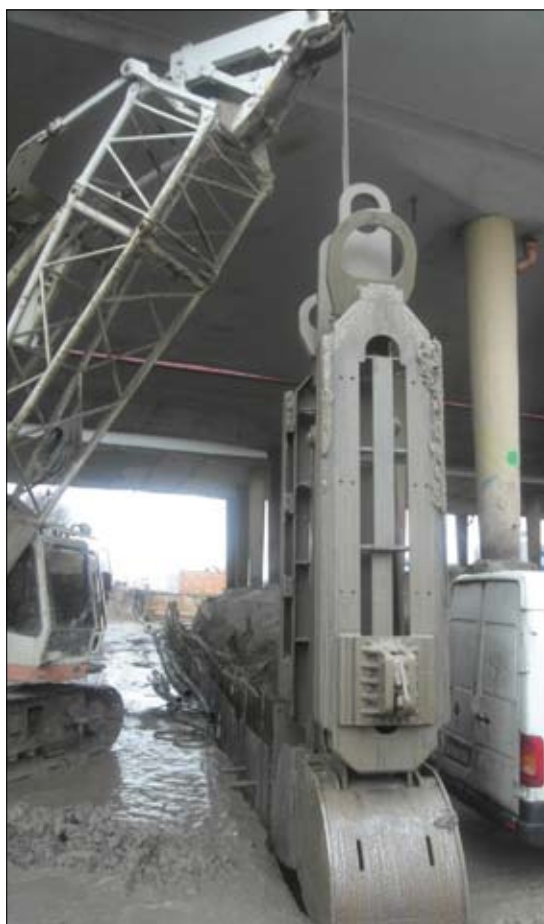
Fot. 2 | Głębienie ścian szczelinowych pod wiaduktem
