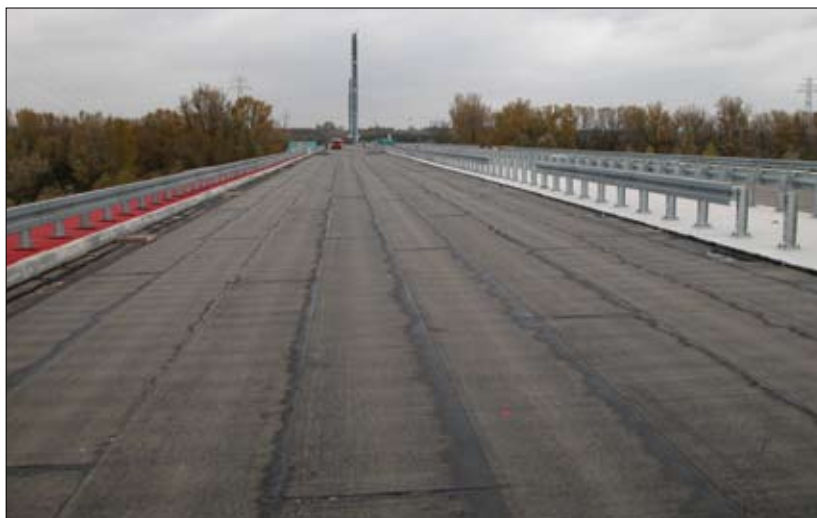
Fot. 1 | Dobrze wykonana izolacja na moście
