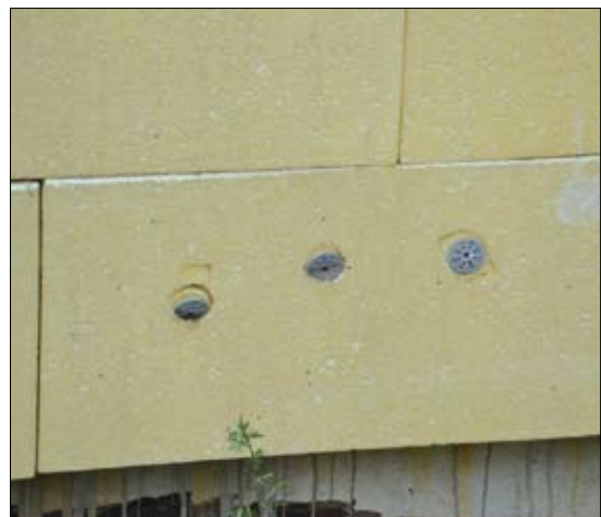
Fot. 3 | Niewłaściwe mocowanie płyt styropianowych za pomocą kołków [1]
