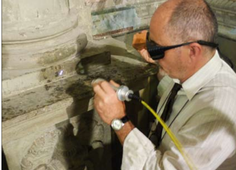
Fot. 2 | Czyszczenie fragmentu zabrudzonego detalu gzymsu przenośnym laserem EOS Combo włoskiej firmy El.En.Group.
