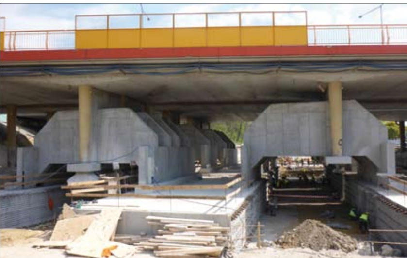
Fot. 3 | Wiadukt po rozbiórce fundamentów
