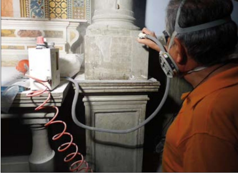
Fot. 1 | Precyzyjne tzw. mikropiaskowanie za pomocą urządzenia firmy Sandblasting Unit
