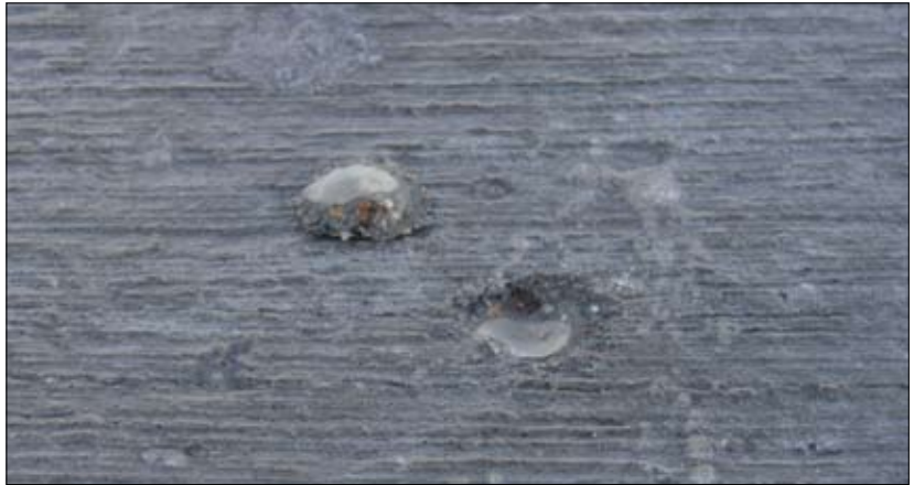
Fot. 1 Efekt zastosowania niemrozoodpornego kruszywa w betonie o dobrej, trwałej matrycy cementowej
