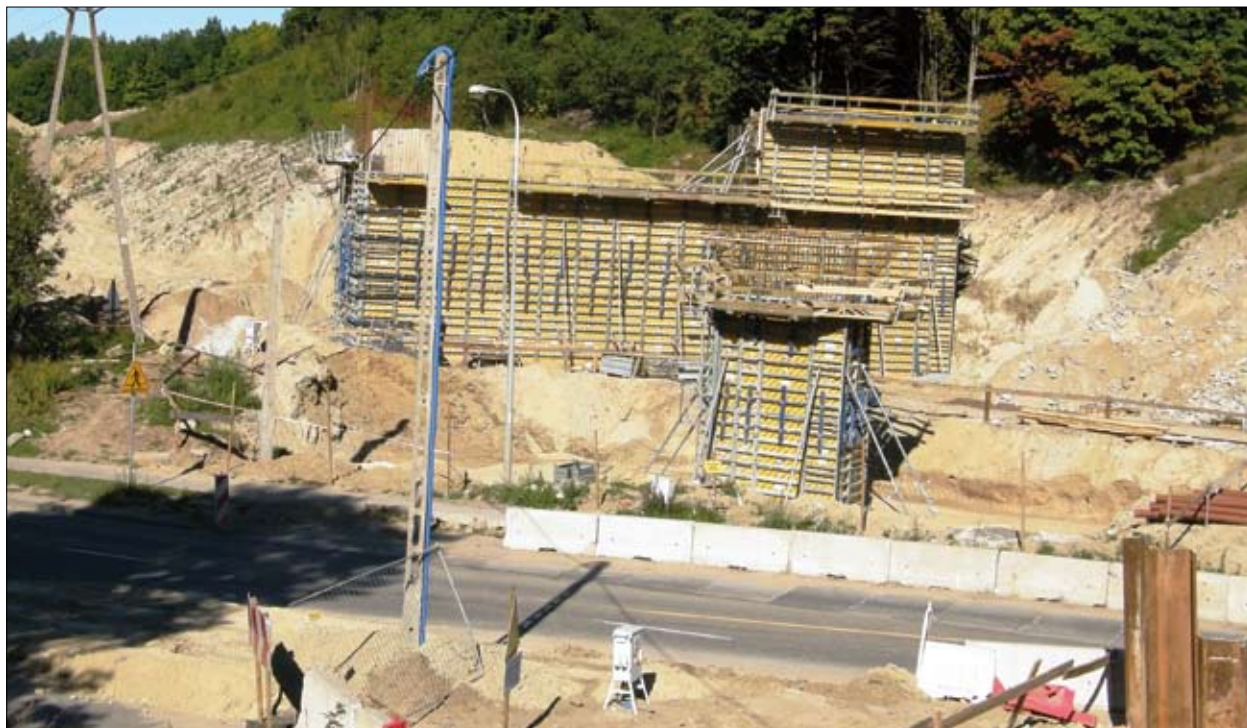
Budowa nasypu kolejowego i wiaduktu nad ul. Rakoczego pod przystanek PKM Brętowo (2013 r.)
