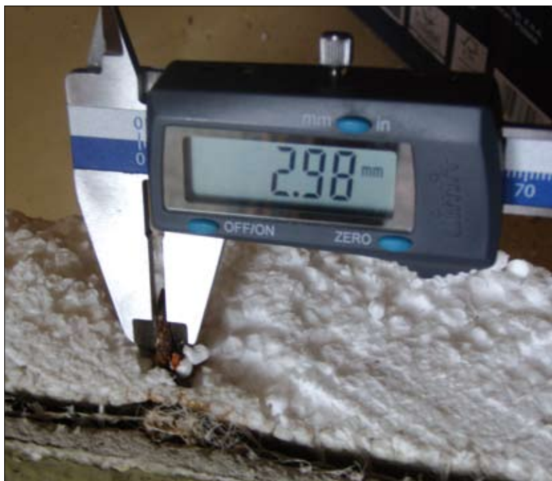
Fot. 5 | Korozja gwoździ stalowych przytrzymujących siatkę zbrojeniową [1]
