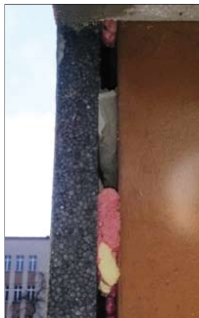
Fot. 2 | Niewłaściwe mocowanie płyt styropianowych bez klejenia obwodowego [1]
