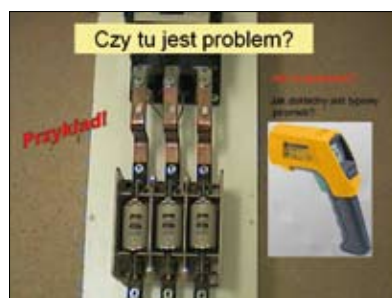
Rys. 2 | Który z bezpieczników jest najcieplejszy? [2]
