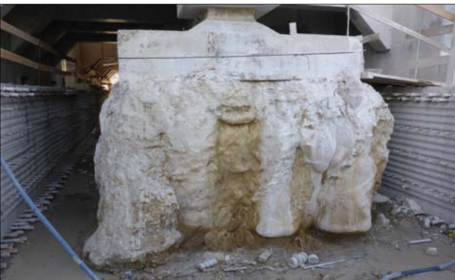
Fot. 1 | Bryła scalonego gruntu pod fundamentem po jego odkopaniu. Z boku widoczne odcinki stropu tunelu wieńczące ściany szczelinowe, powyżej tarcze transferowe
