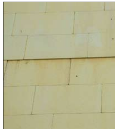
Fot. 1 | Brak jednolitej płaszczyzny płyt stropianowych wskutek braku odpowiedniego przygotowania podłoża ściennego (nierówności) [1]
