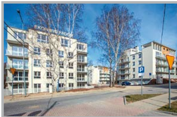
Kompleks budynków przy ul. Suwalskiej. Projektant: Armand Skowroński, Pracownia Projektowa „VEGA-ART” w Zielonej Górze. Wykonawca: Przedsiębiorstwo Budowlane „EKONBUD-FADOM” L.E. Jarząbek w Zielonej Górze. Kierownik budowy: Karol Malinowski (fot. archiwum Lubuskiej Izby Budownictwa)
