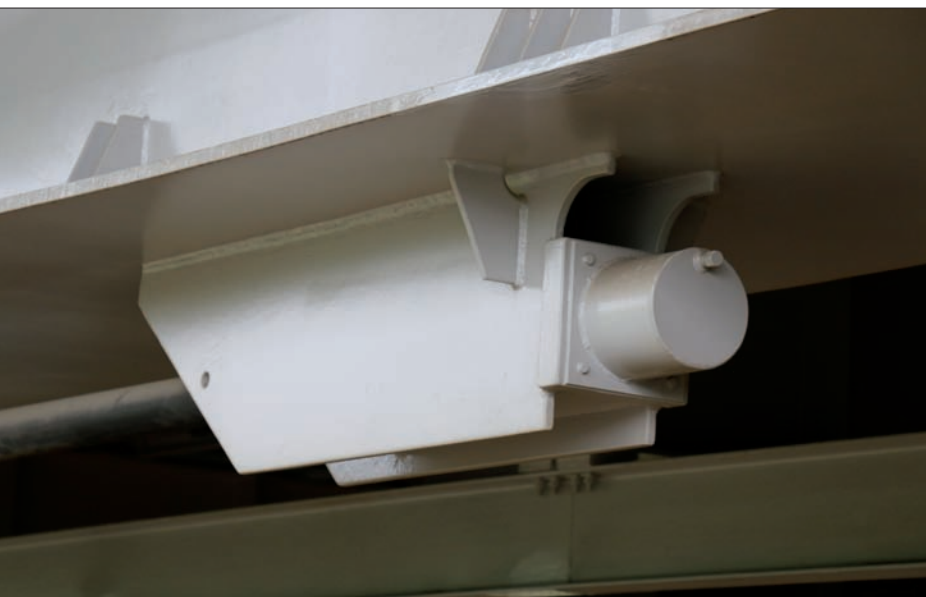
Fot. 4 | Zakotwienie sprężenia dolnego
