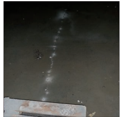
Fot. 3 | Przekieki wody przez płytę denną przez szczelinę otwartą w wyniku skurczu betonu. Na zdjęciu widoczne są wytrącenia soli z wody przepływającej przez beton
