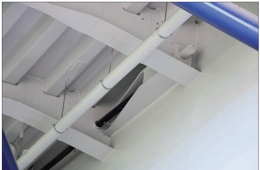
Fot. 6 | Zakotwienie sprężenia górnego
