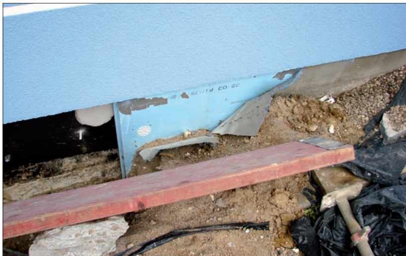
Fot. 1 Antyprzykład izolacji ścian piwnicy (fot. archiwum autora)
