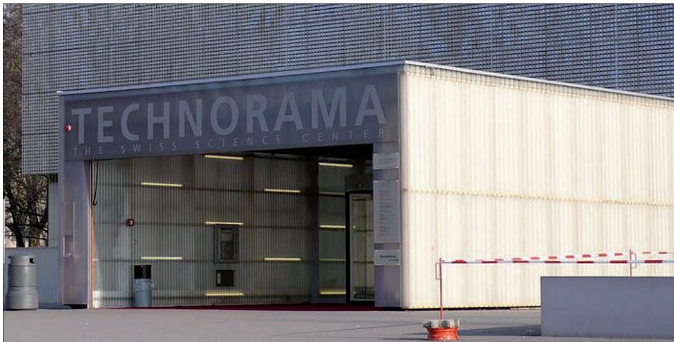
Dynamiczna fasada budynku w Winterthur, Szwajcaria (fot. Reinraum, Wikimedia Commons)
