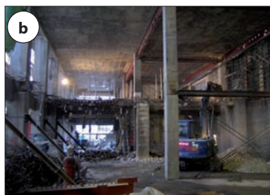
Rys. 4 | Zastosowanie tymczasowych stężeń stalowych podczas przebudowy żelbetowego budynku szkieletowego [7]: a) szkic obiektu z zaznaczeniem wprowadzonych zmian konstrukcyjnych, b) i c) tymczasowe stężenia stalowe w obrębie 1. i 2. kondygnacji
