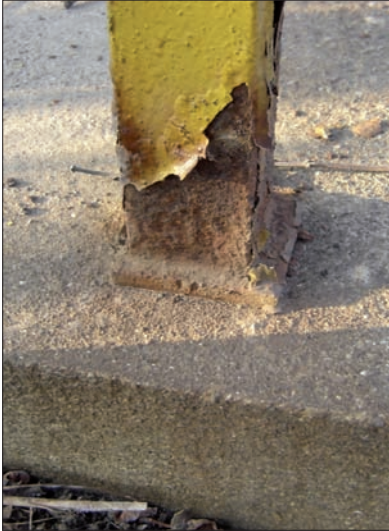
Fot. 1 | Złe zabezpieczenie stali przed korozją i zły montaż
