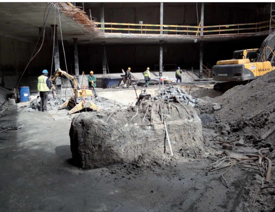
Fot. 1 Widok podziemia budynku posadowionego na fundamencie płytowo-palowym
