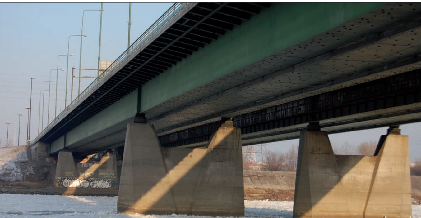
Fot. 1 | Konstrukcja mostu Grota-Roweckiego przed przebudową
