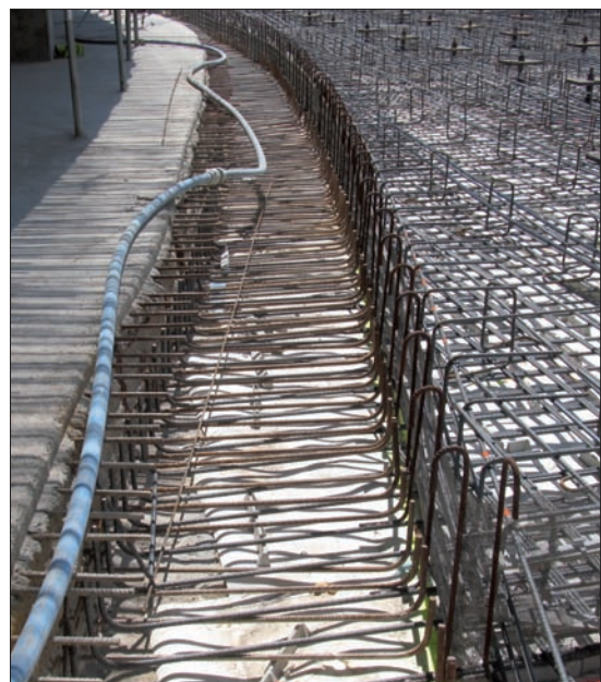
Fot. 4 | Połączenie dwóch dużych działek betonowania płyty elementem o małych wymiarach poprzecznych
