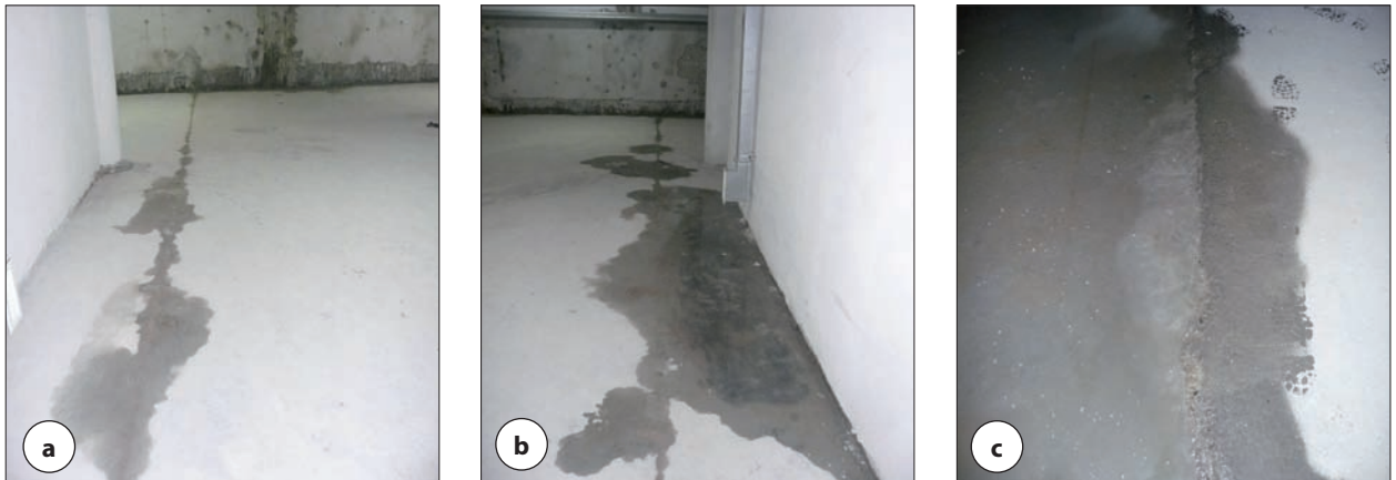
Fot. 2 (a–c) | Przekieki wody przez płytę denną przez szczelinę otwartą w wyniku skurczu betonu
