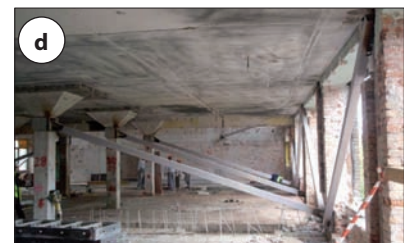
Rys. 3 | Zastosowanie stalowych stężeń tymczasowych w budynku szkieletowym podczas wymiany fragmentu stropu [6]: a) rzut stropu, b) stężenia poziome, c) stężenia pionowe podłużne w linii słupów, d) stężenia pionowe poprzeczne
