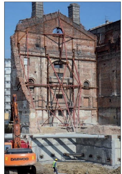
Fot. 4 | Stężenie remontowe typu zastrzałowo-wspornikowego zabytkowej ściany frontowej o wysokości 28,0 m (projektant – Cz. Hodurek) [4]
