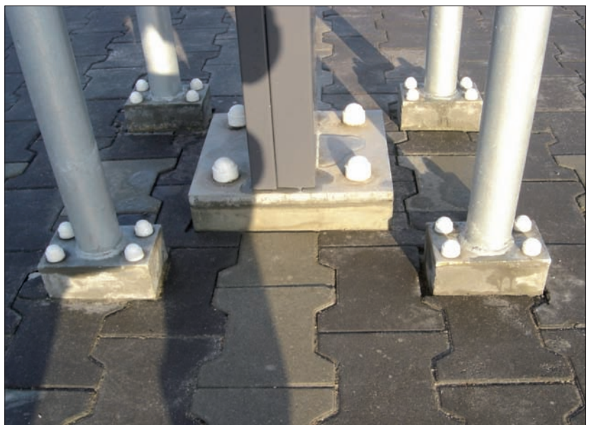
Fot. 3 | Poprawne zabezpieczenie i montaż słupów tablicy reklamowej
