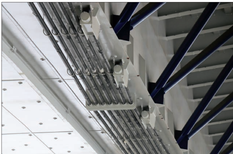
Fot. 3 | Sprężenie dolne w przęśle nurtowym
