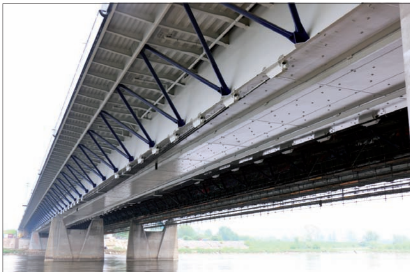
Fot. 7 | Most Grotta-Roweckiego po przebudowie
