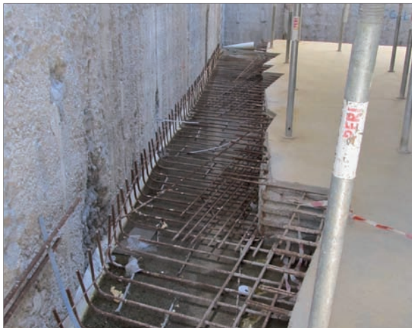
Fot. 5 | Przykład płyty dennej niedobetonowanej do ściany szczelinowej. Uzupełnienie płyty będzie wykonane po zrealizowaniu osiadań i skurczu żelbetowej płyty fundamentowej
