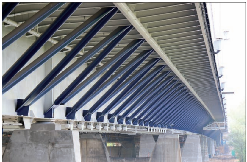
Fot. 2 | Wspornik zewnętrzny (most Grot-Roweckiego)
