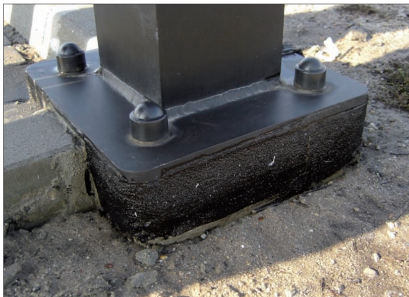
Fot. 2 | Poprawne zabezpieczenie i montaż słupa oświetlenia
