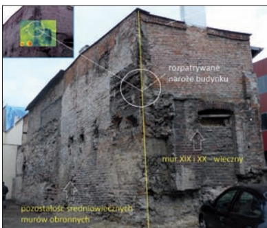
Rys. 1 | Fragment budynku, gdzie jedną z przegród stanowi fragment średniowiecznego muru obronnego
