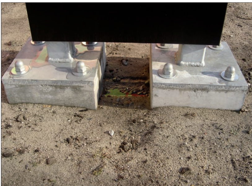
Fot. 4 | Poprawne zabezpieczenie i montaż słupa informacyjnego
