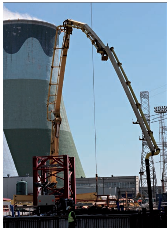
Fot. 2 | Betonowanie fundamentu
