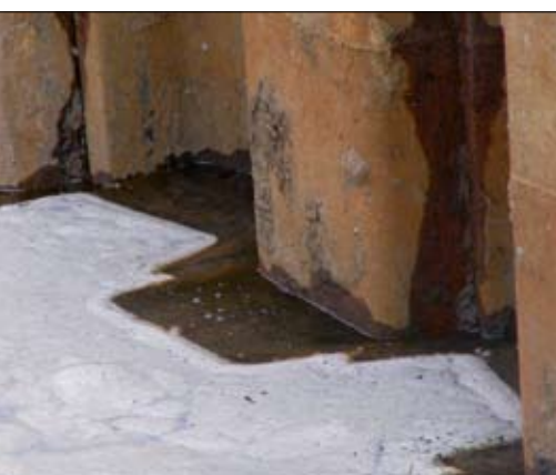
Fot. 1 | Wyływy wody przez zamki grodzic ścianki szczelnej
