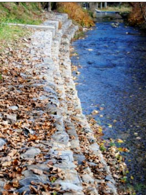
Fot. 8 | Regulacja linii cieków wodnych i stabilizacja skarp
