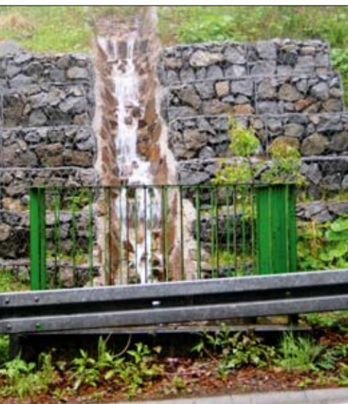
Fot. 6 | Przykład ubezpieczenia wlotu przepustu i skarpy (obrukowanie wraz z zastosowaniem szykan z kamieni, mur z gabionów)
