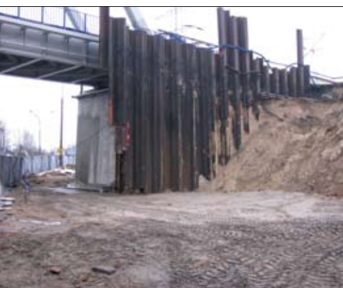
Fot. 2 | Ścianka stalowa z widocznymi śladami korozji, umożliwiającą półkowe wykonanie przebudowy wiaduktu kolejowego
