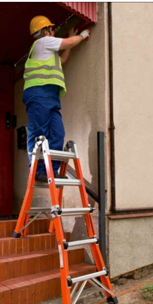
Fot. 5 | Wykonywanie prac z drabiny rozstawnej na schodach [9]
