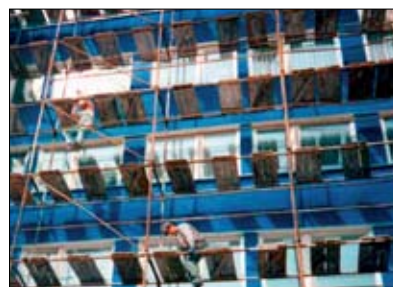
Fot. 1 | Nieprawidłowo ustawione rusztowanie (stężenie pionowe, pomosty robocze, balustrady, drabinki) [6]
