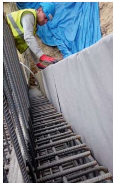
Fot. 2 | Montaż maty na boku płyty fundamentowej
