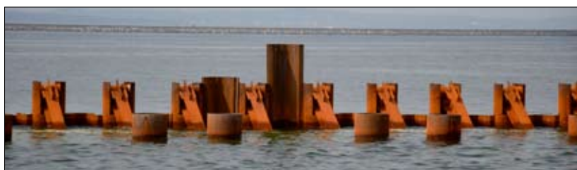
Fot. 8 | Ścianki stalowe na budowie gazoportu w Świnoujściu
