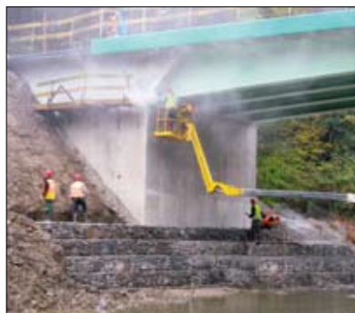
Fot. 9 | Zastosowanie gabionów w pracach związanych z budową mostu
