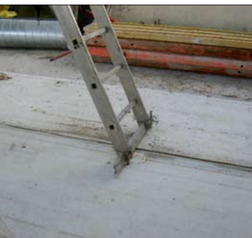
Fot. 6 | Zabezpieczenie drabiny przystawnej przed zmianą położenia (fot. autor)
