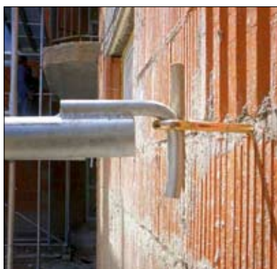
Fot. 3 | Prawidłowe kotwienie rusztowania do ściany budynku [8]
