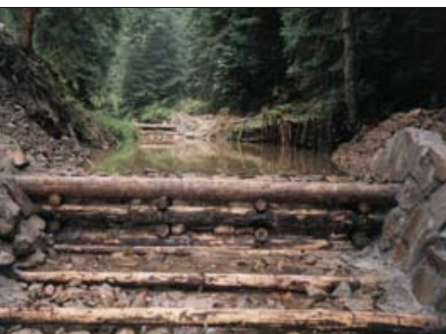
Fot. 7 | Stopień kaszycowy wraz z ubezpieczeniem
