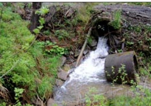
Fot. 4 | Przeszkoda w korycie potoku w postaci luźno rozlokowanych elementów betonowych pochodzących ze zniszczonego przepustu
