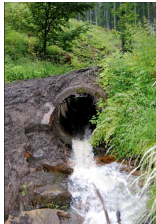
Fot. 3 | Wymywanie drogi w wyniku braku wykonania zabezpieczenia wylotu przepustu
