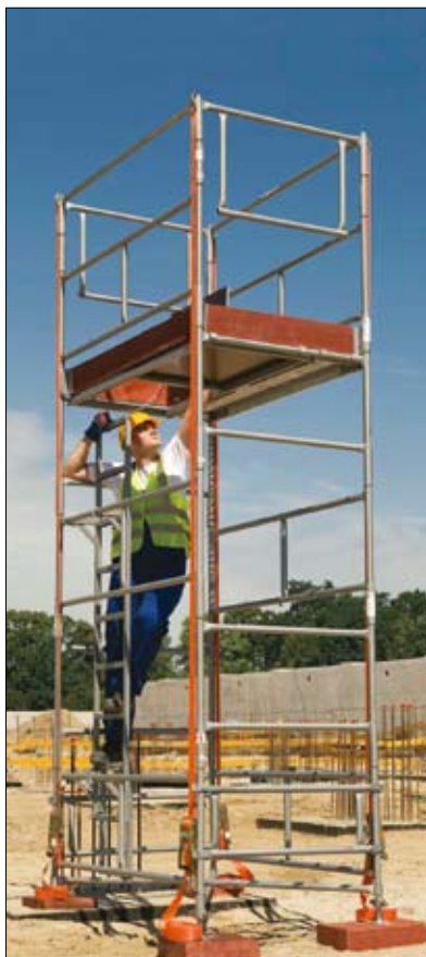
Fot. 2 | Prawidłowo ustawione rusztowanie warszawskie [8]
