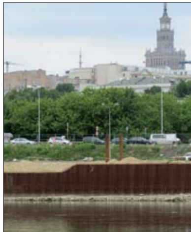
Fot. 13 | Ścianka stalowa w konstrukcji bulwarów wiślanych w Warszawie
