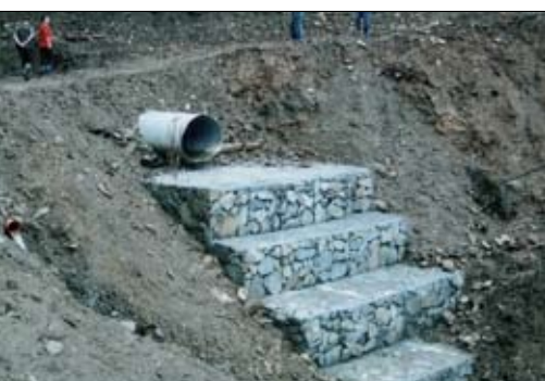
Fot. 5 | Wykonywanie ubezpieczenia wylotu przepustu i skarpy (prace w toku)
