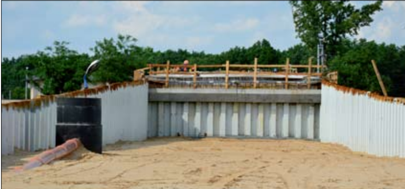
Fot. 10 | Ścianka stalowa stanowiąca trwały przyczółek oraz ściany oporowe dojazdów do wiaduktu
