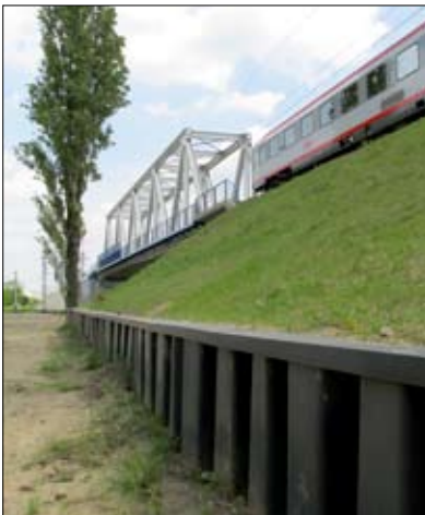
Fot. 11 | Zabezpieczenie skarpy nasypu kolejowego z grodzic winylowych
