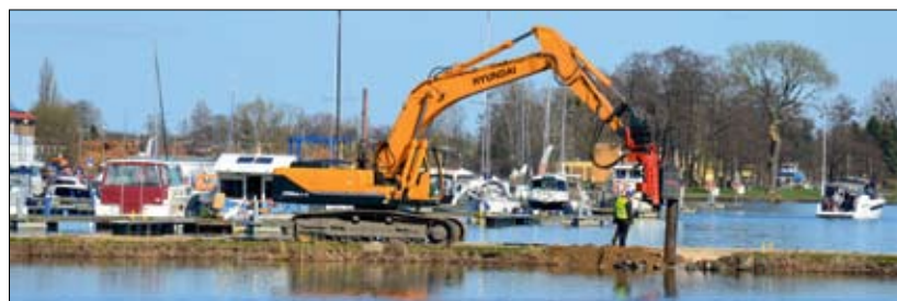
Fot. 7 | Pograżanie elementów stalowych w czasie budowy marin
