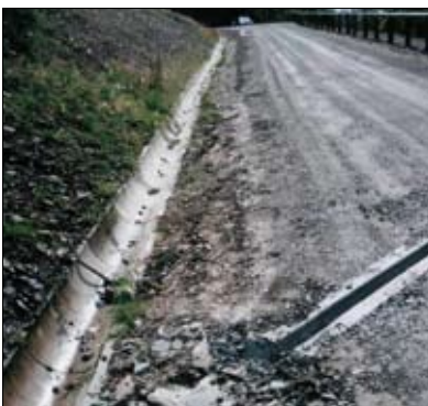
Fot. 2 | Wodospust i korytka ściekowe
