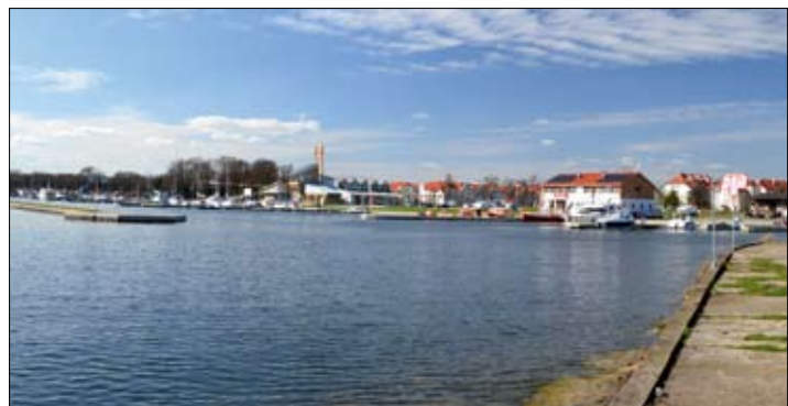
Fot. 6 | Widok mariny wykonanej z wykorzystaniem grodzic
