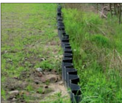
Fot. 11 | Zabezpieczenie skarpy nasypu kolejowego z grodzic winylowych
