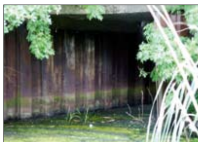
Fot. 3, 4 | Posadowienie mostu na grodzicach stalowych na Pomorzu Zachodnim pochodzące sprzed II wojny światowej [2]
