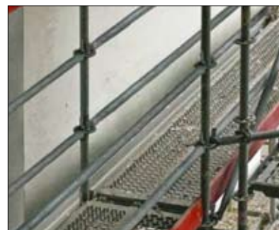
Fot. 4 | Przy odsunięciu rusztowania od ściany na odległość ponad 0,2 m wykonano balustrady od strony ściany [8]
