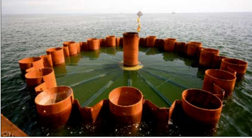
Fot. 9 | Konstrukcja stalowa posadowienia stawy nawigacyjnej na Bałtyku ok. 10 km od brzegu [3]
