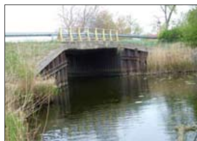
Fot. 3, 4 | Posadowienie mostu na grodzicach stalowych na Pomorzu Zachodnim pochodzące sprzed II wojny światowej [2]
