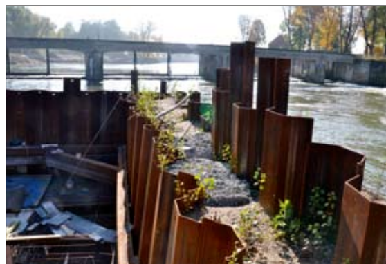
Fot. 5 | Budowa w nurcie rzeki zabezpieczona tymczasową ścianką stalową, po prawej widoczne umocnienie brzegu rzeki ścianką stałą
